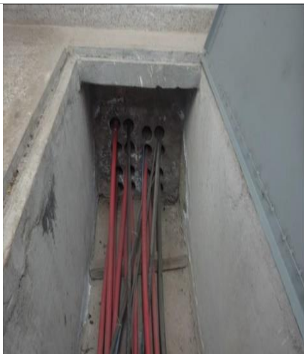
Vistas de SET P483 Friaspata, espacios disponibles para el proyecto: armario para la Celda A4104, buzones interior y exterior del ducto de salida para el nuevo Alimentador
