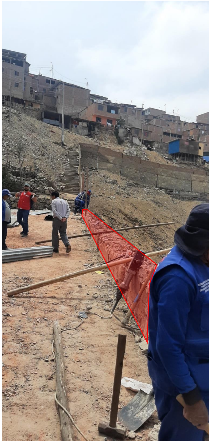
Imagen N° 11 Vista externa de cerco perimétrico que ha colapsado 29.30 ml. Intervención contempla completar la demolición de base de muro que colapsó (resaltado en rojo) para colocar cerco provisional de Aluzinc.
