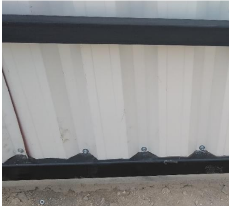
Esquema de anclaje de plancha de Aluzinc y tubo metálico 3"x3" e=3 mm., con pernos autoroscantes
