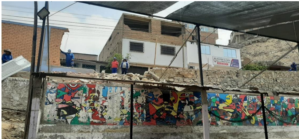
Imagen N° 07 Vista interna de cerco perimétrico que ha colapsado 29.30 ml.
