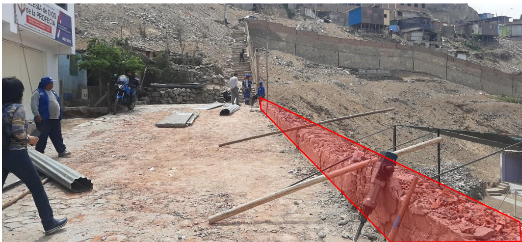
Imagen N° 10 Vista externa de cerco perimétrico que ha colapsado 29.30 ml. Intervención contempla completar la demolición de base de muro que colapsó (resaltado en rojo) para colocar cerco provisional de Aluzinc.
