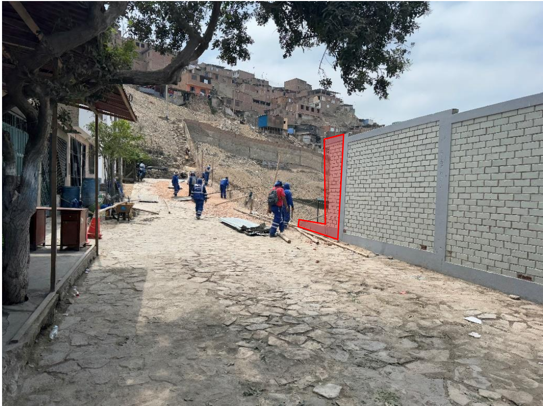
Imagen N° 09 Vista externa de cerco perimétrico que ha colapsado 29.30 ml. Se intervendrá 30.70 m. debido a que se completará la demolición de muros de albañilería que han quedado sin confinamiento (resaltado en rojo), así como base de muro
