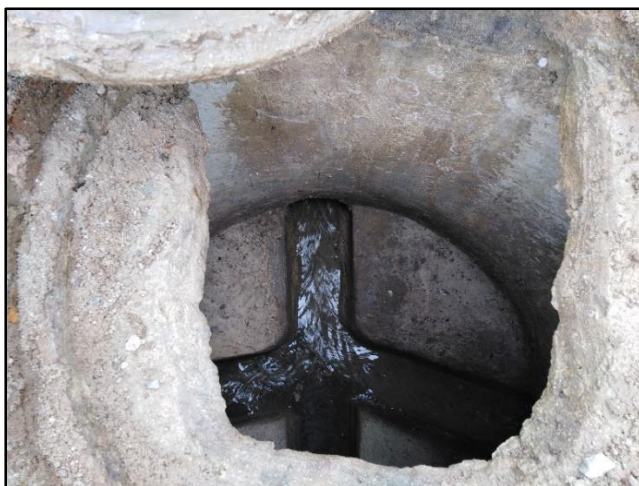
Imagen 18. Buzón existente de alcantarillado en regular estado. Fuente: Elaboración propia.
