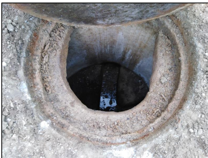
Imagen 13. Buzón existente de alcantarillado en regular estado. Fuente: Elaboración propia.
