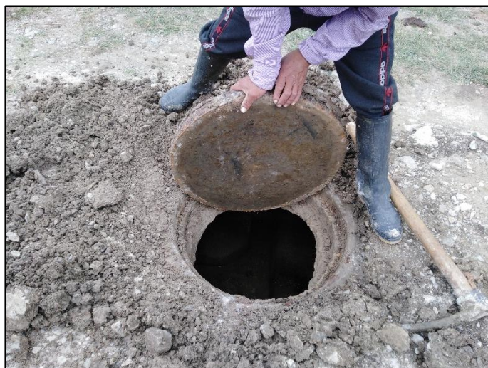
Imagen 12. Buzón existente de alcantarillado en regular estado. Fuente: Elaboración propia.
