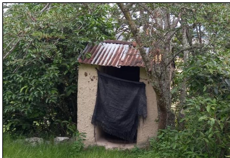
Imagen 11. Servicio higiénico con pozo ciego, en mal estado.
