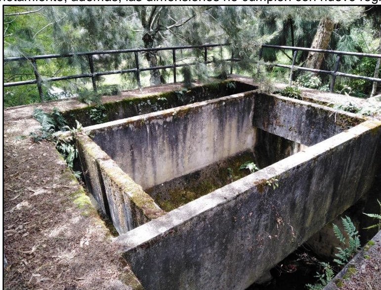
Imagen 25. Tanque Imhoff en mal estado.
