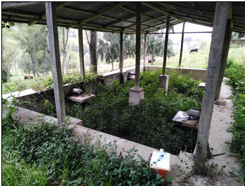
Imagen 27. Lecho de Secado en abandono, actualmente inoperativo.
