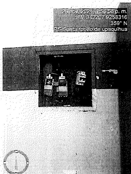
FOTO 4.- SE OBSERVA EL TABLERO GENERAL DEL ESTABLECIMIENTO, SE PUEDE VER QUE LOS INTERRUPTORES TERMOMAGNETICOS NO SON ADECUADOS.
