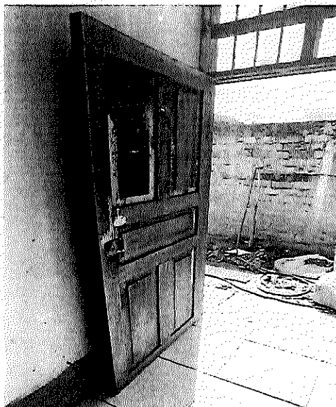
FOTO 1.- SE OBSERVA UNA PUERTA QUE SE ENCUENTRA EN MAL ESTADO, LA CERRADURA NO FUNCIONA, LO CUAL ES UN PELIGRO PARA LA SEGURIDAD DEL ESTABLECIMIENTO. TAMBIÉN SE OBSERVA QUE LA PUERTA NO TIENE BUEN ACABADO.
