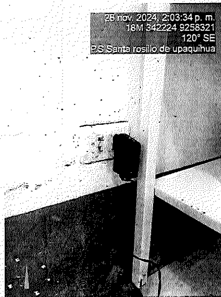
FOTO 4.- SE OBSERVA QUE LOS TOMACORRIENTES SON ANTIGUOS, POR LO CUAL SE REQUIERE UTILIZAR TOMACORRIENTES MAS SEGUROS.
