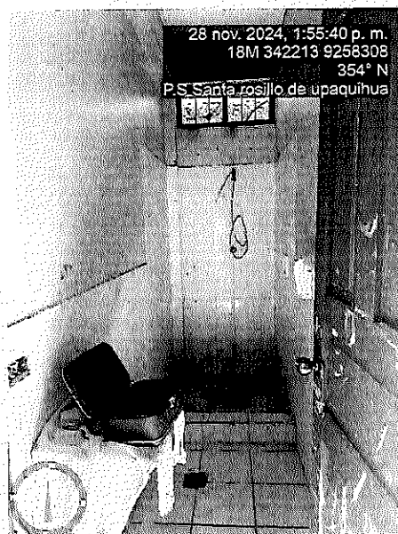
FOTO 4.- SE OBSERVA EL ESTADO ACTUAL DE UN SERVICIO HIGINICO, DONDE SE EVIDENCIA QUE EXISTE EL PUNTO DE DESAGUE PERO NO EL INODORO.
