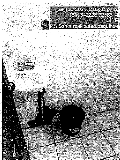
FOTO 2.- SE OBSERVA EL DESPRENDIMIENTO DEL REVESTIMIENTO DE CERÁMICA EN EL SSHH DE ÁREA MUJER, TAMBIÉN SE CONSTATÓ QUE NO HAY SUMINISTRO DE AGUA.
