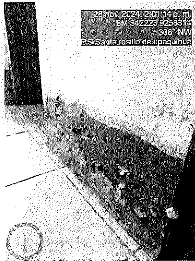
FOTO 3.- SE OBSERVA EL DESPRENDIMIENTO DE LA PINTURA INTERIOR Y EL MAL ESTADO DE ESTE MISMO.
