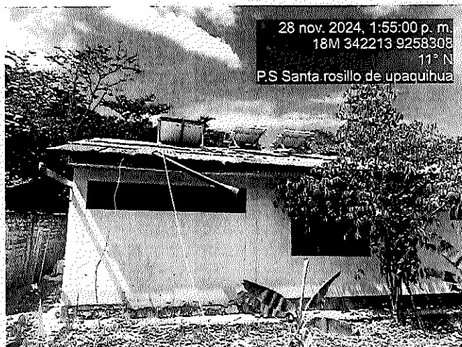
FOTO 6.- SE OBSERVA EL DESPRENDIMIENTO DE LA CANALETA GALVANIZADA, NO PERMITE LA CORRECTA EVACUACIÓN DE AGUAS DE LLUVIA.
