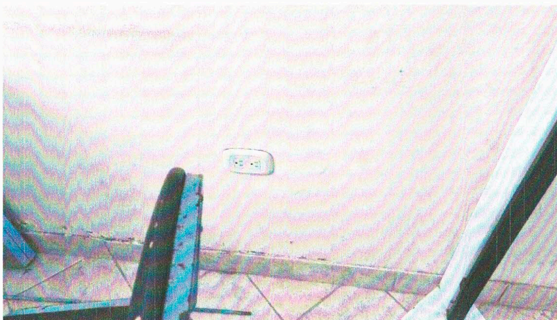
Foto 09. Se observa tomacorrientes en mal estado
