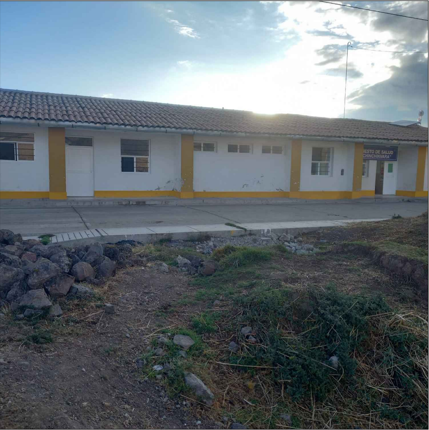
FOTO 01: SE OBSERVA EL PINTADO DE LA FACHADA EN MAL ESTADO, CUBIERTA DE TEJA DE ASBESTO EN MAL ESTADO, CANALETA METALICA EN MAL ESTADO.
