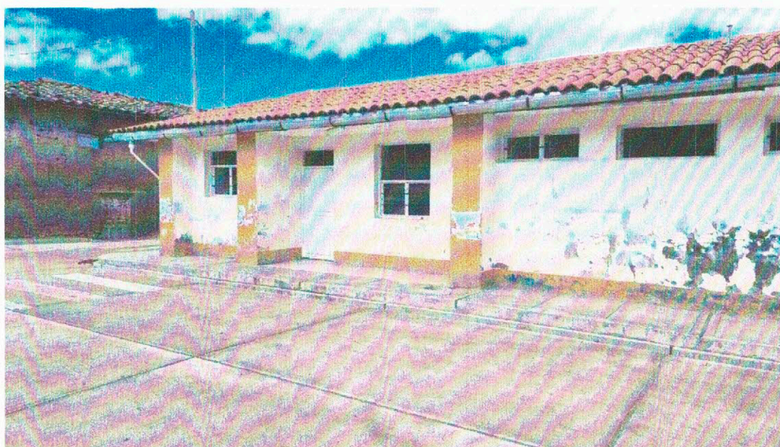
Foto 04. Se observa cobertura existente en mal estado
