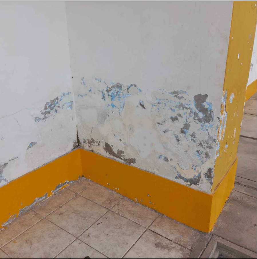
FOTO 03: PINTURA DE MUROS EXTERIORES EN MAL ESTADO
