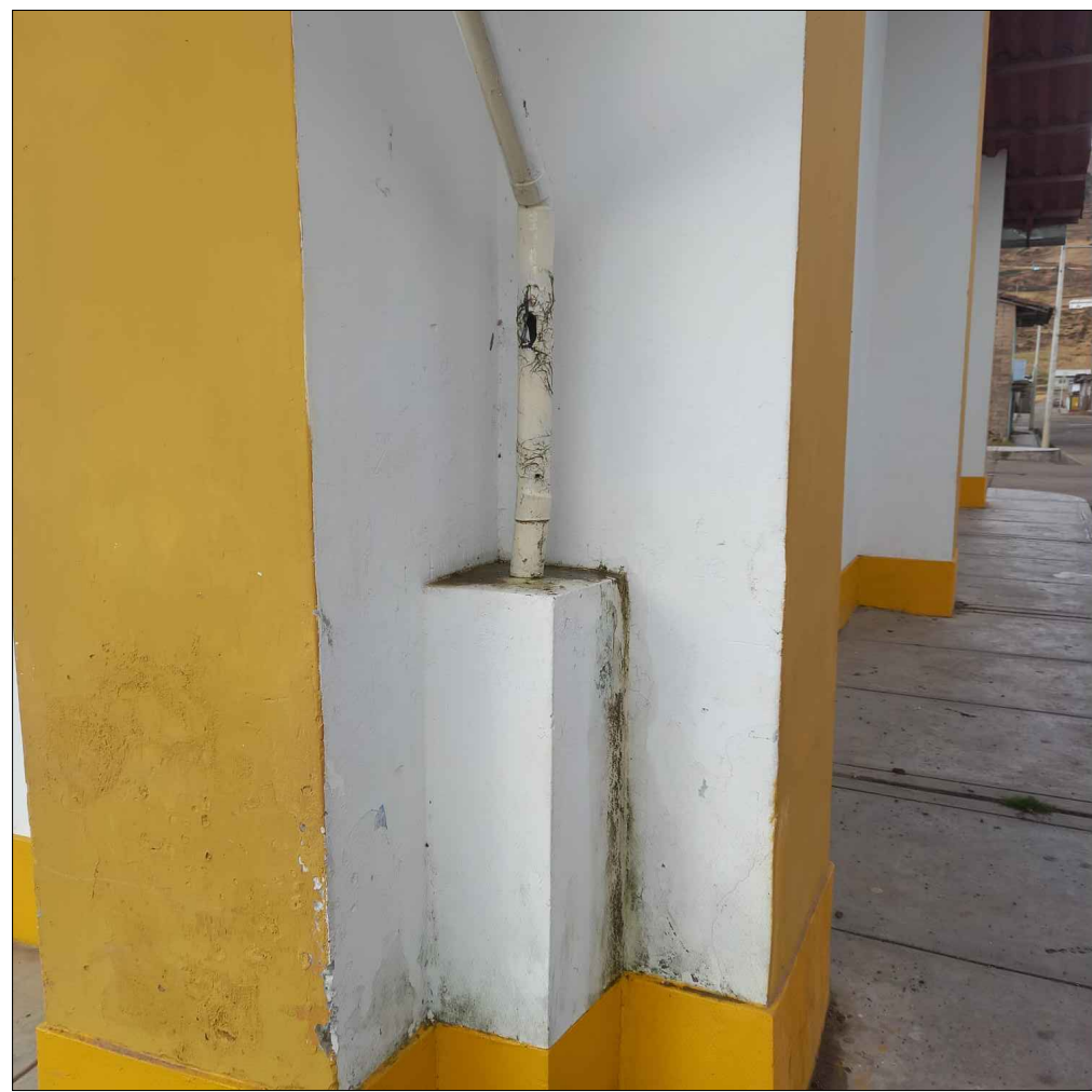
FOTO 1: MONTANTE DE DESAGUE DE 2" EN MAL ESTADO
