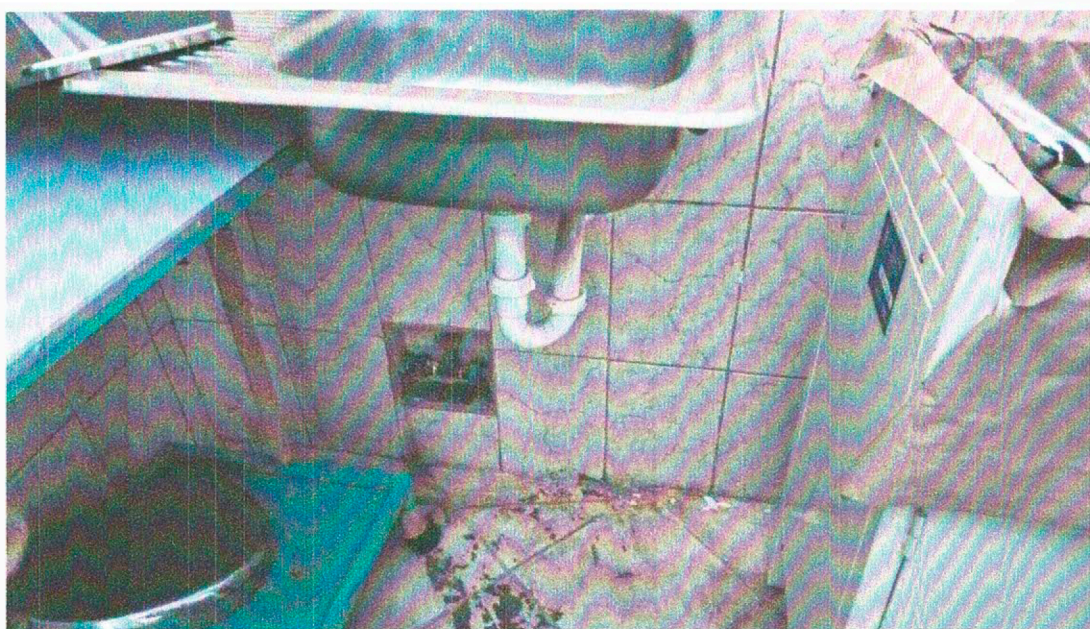
Foto 13. Se observa que las redes sanitarias en mal estado
