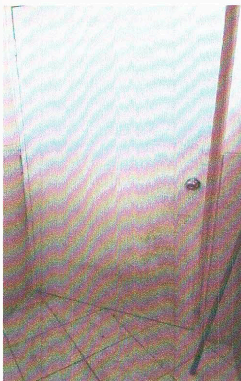
Foto 10. Se observa pintura de puertas en mal estado
