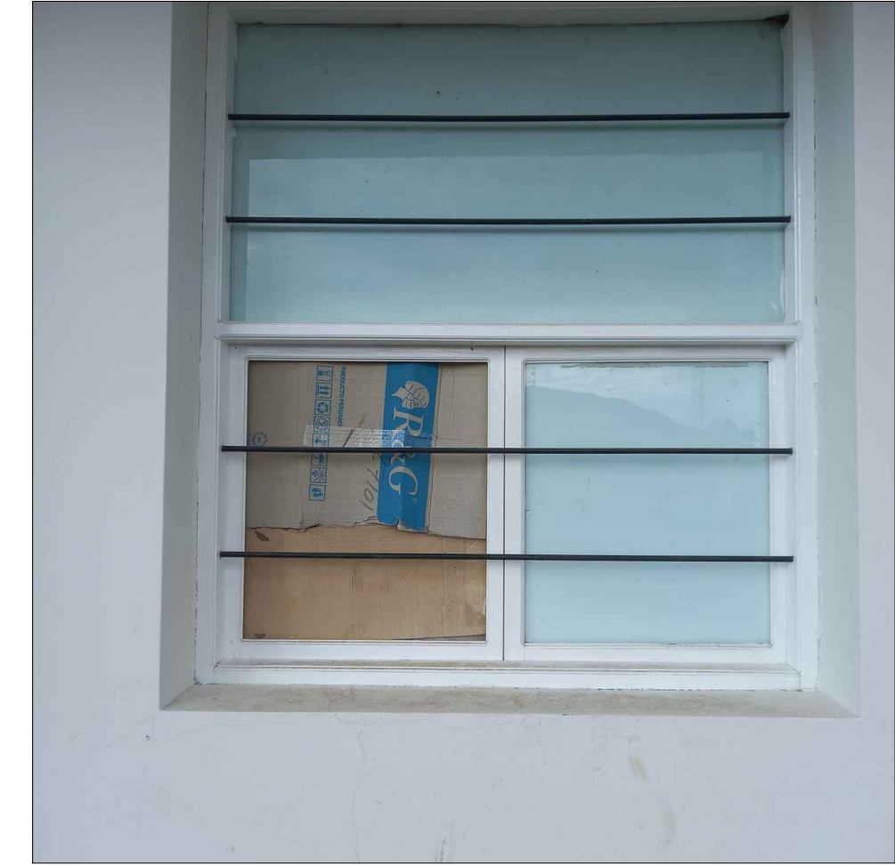
FOTO 01: SE OBSERVA VENTANAS EN MAL ESTADO, ROTAS
