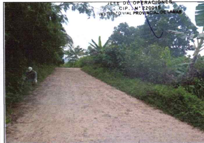
Foto 12: Se observa encalaminado de la Plataforma en el Km.2+750
