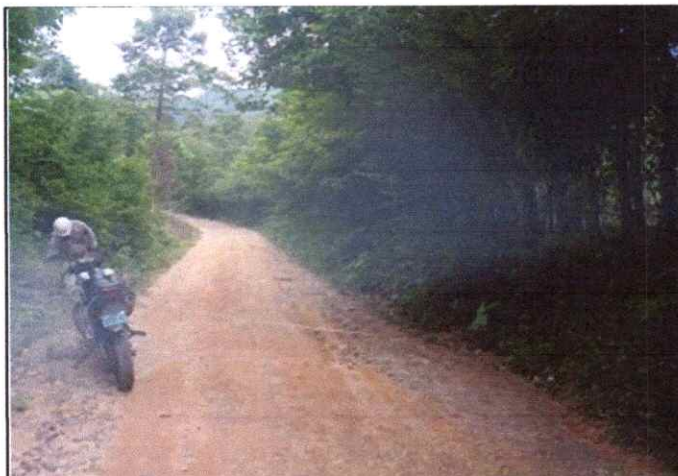
Foto 07: Se observa encalaminado de la Plataforma en el Km.1+500
