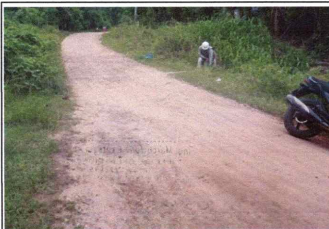
Foto 03: Se observa baches en la Plataforma en el Km. 0+500
