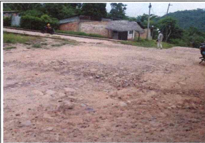
Foto 01: Badén ubicado en el km, 0+020, se encuentra en mal estado de conservación.
