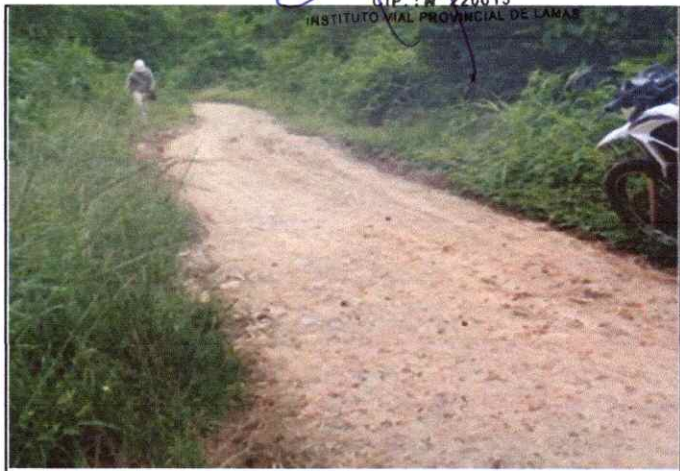
Foto 24: Se observa erosión de la Plataforma en el Km. 5+750
