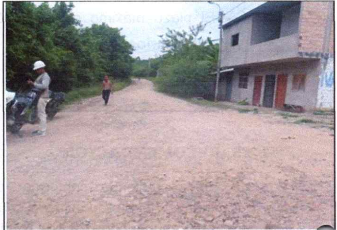
Foto 02: Se observa encalaminado en la Plataforma en el Km. 0+250
