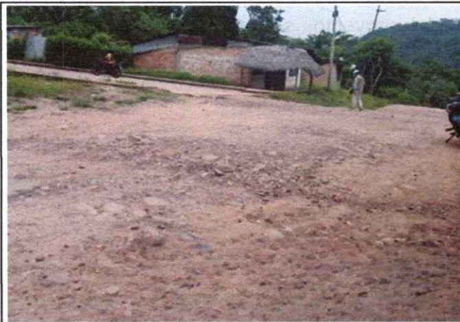
Foto 01: Se observa Baches Y Encalamindo en la Plataforma en el Km.0+000
