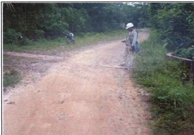
Foto 13: Se observa encalaminado, erosión de la Plataforma en el Km. 3+000
