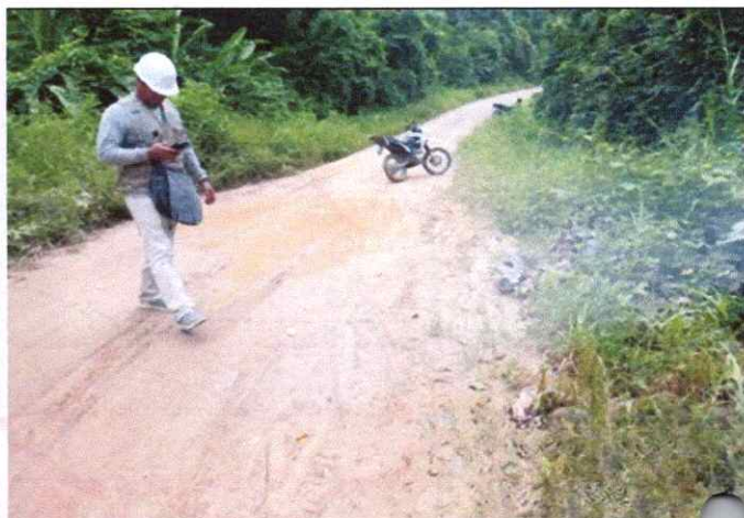
Foto 16: Se observa ahuellamiento, encalaminado y erosión de la Plataforma en el Km. 3+750
