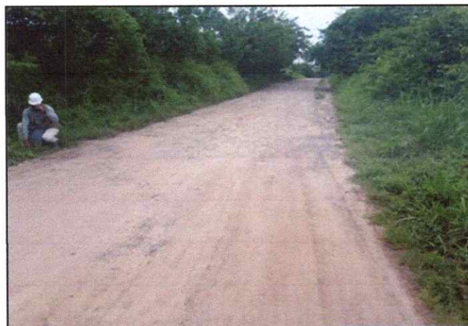
Foto 09: Se observa encalaminado de la Plataforma en el Km. 2+000
