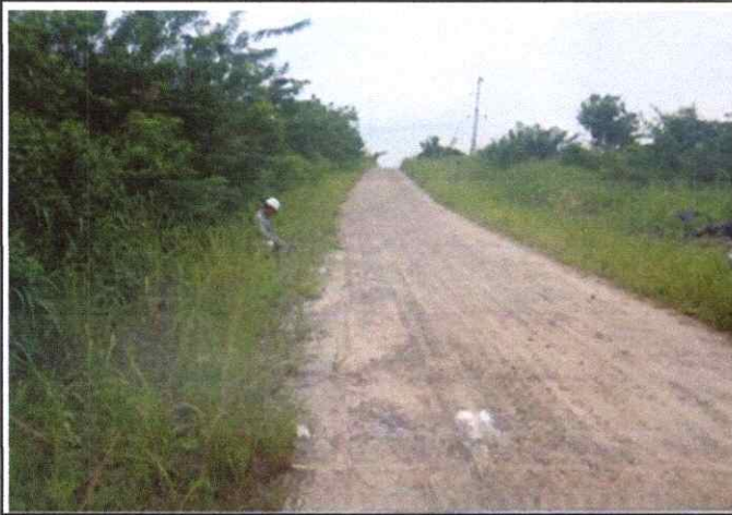
Foto 19: Se observa encalaminado y erosión de la Plataforma en el Km. 4+500
