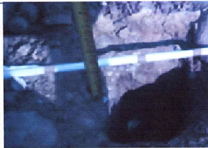
Foto 20: Espesor de la plataforma 0.06 mts. LI En el Km. 4+750
