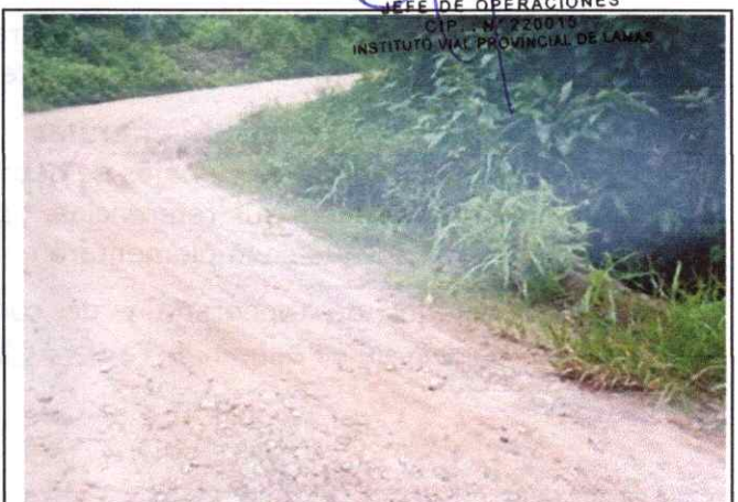
Foto 06: Badén ubicado en el km 02+120, se encuentra en regular estado de conservación.
