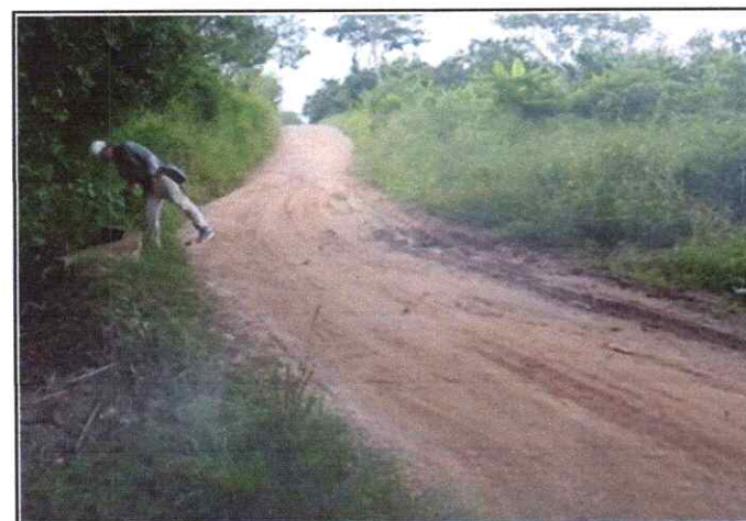
Foto 11: Se observa encalaminado de la Plataforma en el Km.2+500
