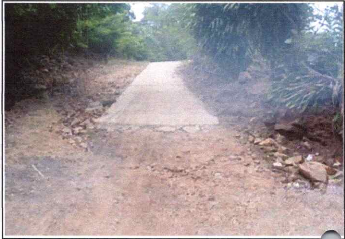
Foto 20: Se observa erosión de la Plataforma en el Km. 4+750
