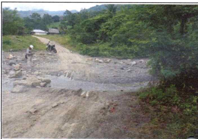
Foto 26: Se observa ahuellamiento y erosión de la Plataforma en el Km. 6+252.
