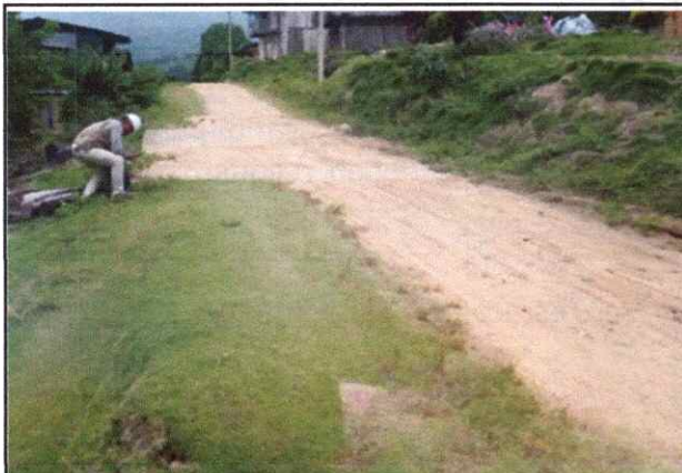
Foto 15: Baden ubicado en el km 04+620, se encuentra en regular estado, un poco colmatado.
