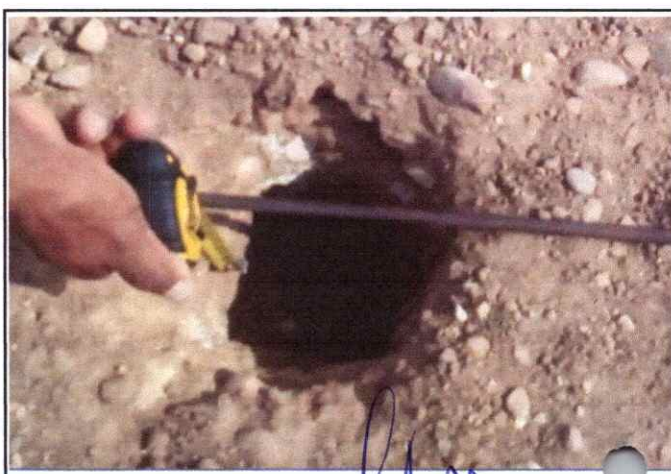
Foto 04: Espesor de la plataforma 0.05 mts. En el Km. 0+750
