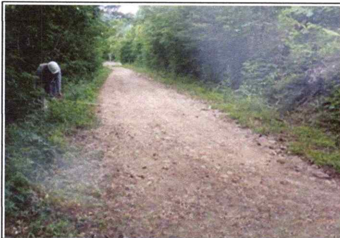
Foto 25: Se observa erosión de la Plataforma en el Km. 6+000
