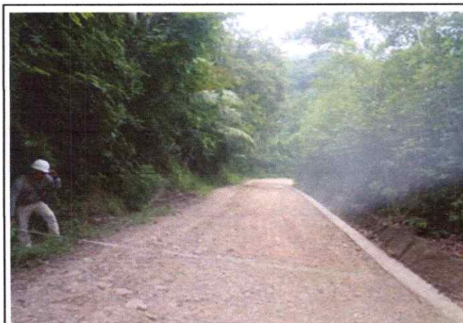
Foto 05: Se observa encalaminado de la Plataforma en el Km. 1+000
