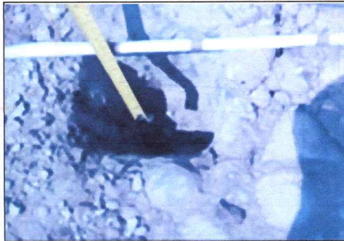
Foto 26: Espesor de la plataforma 0.05 mts. LD En el Km. 6+252
