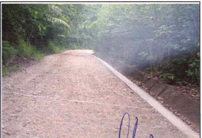
Foto 04: Cuneta ubicado en el km, 00+390 al km 00+640 se encuentra en buen estado de conservación.
