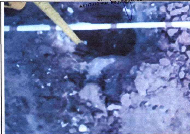
Foto 24: Espesor de la plataforma 0.05 mts. LD En el Km. 5+750
