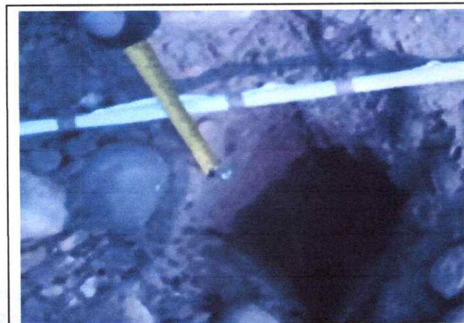
Foto 23: Espesor de la plataforma 0.05 mts. LI En el Km. 5+500
