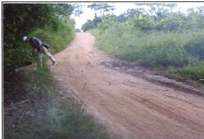
Foto 08: Badén ubicada en el km 02+580, se encuentra en regular estado de conservación, falta limpieza interior.
