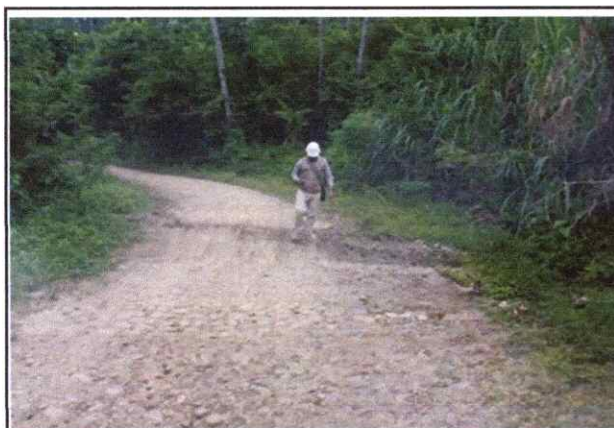
Foto 17: Badén ubicado en el km 05+340, se encuentra en regular estado de conservación.
