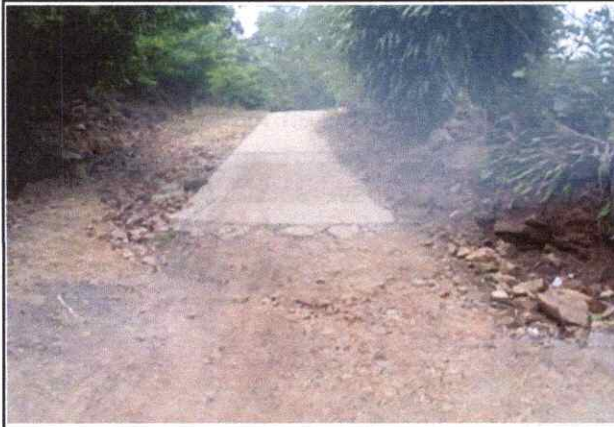
Foto 13: Rampa de concreto ubicado en el km 04+400, se encuentra en buen estado de conservación requiere de una limpieza interior.
