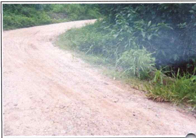
Foto 08: observa encalaminado y ahuellamiento en Plataforma Km. 1+750
