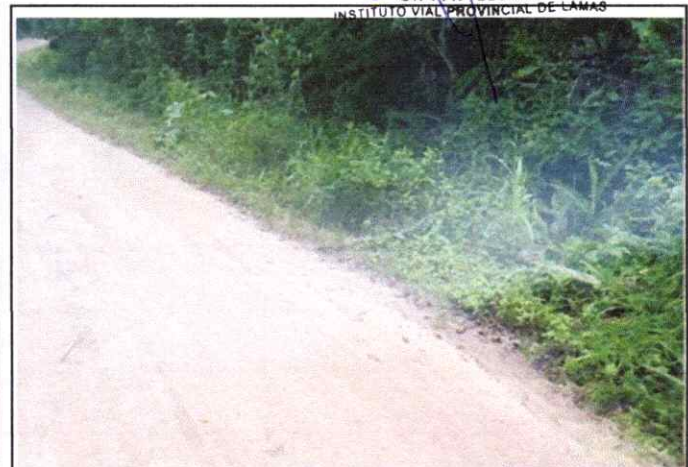
Foto 06: Se observa Ahuellamiento de la Plataforma en el Km.1+250
