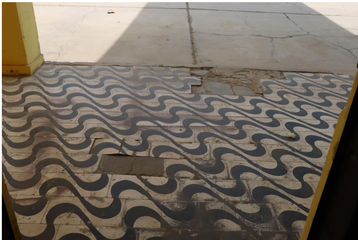
VEREDA DEL PABELLON 1, DONDE SE APRECIA DETERIORO Y MAL ESTADO DE CONSERVACIÓN
