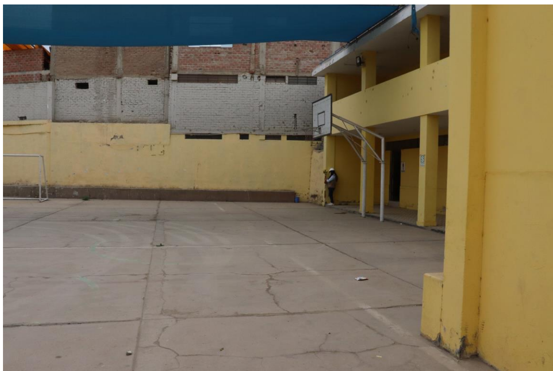
VISTA EXTERIOR DE PATIO DE FORMACION DONDE SE OBSERVA GRIETAS EN EL PISO
