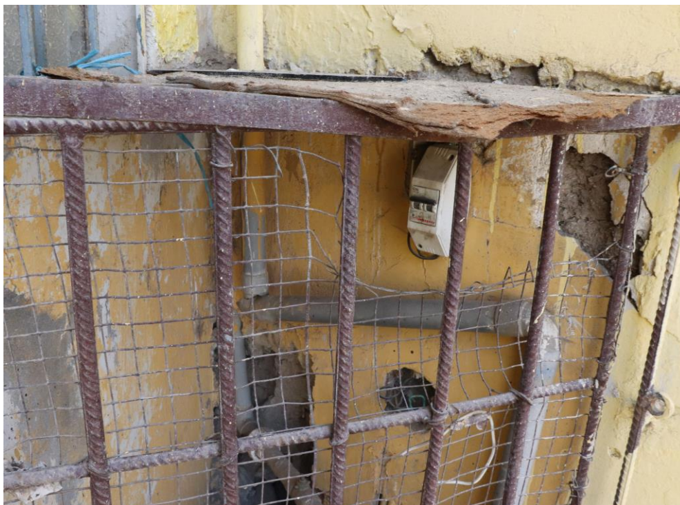
MOTOR DE AGUA, DONDE SE OBSERVA EL DETERIORO DE LOS MUROS Y LAS INSTACIONES ELECTRICAS EXPUESTAS
