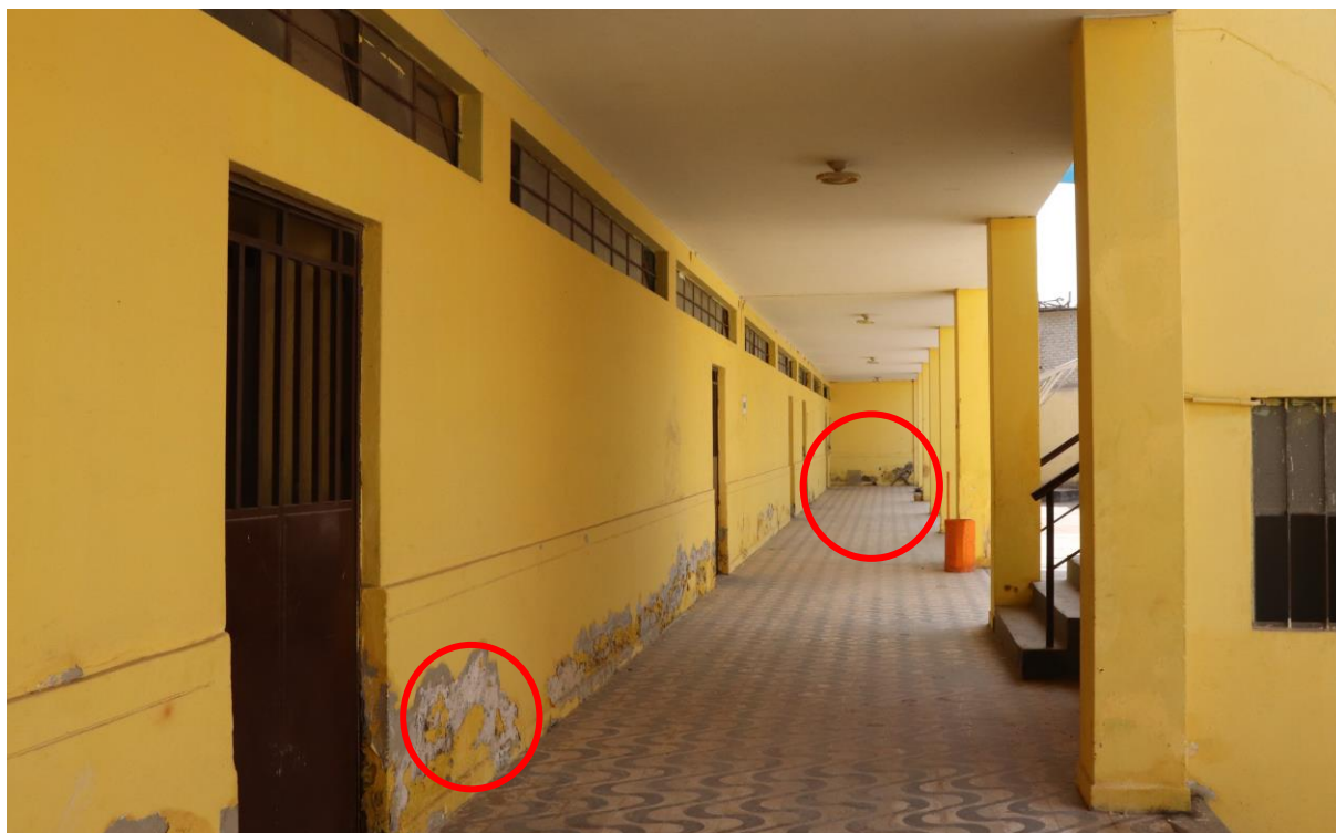
EN PASILLO DE PABELLÓN 1 SE APRECIA SALITRE DEBIDO A LA PRESENCIA DE HUMEDAD EN MUROS
