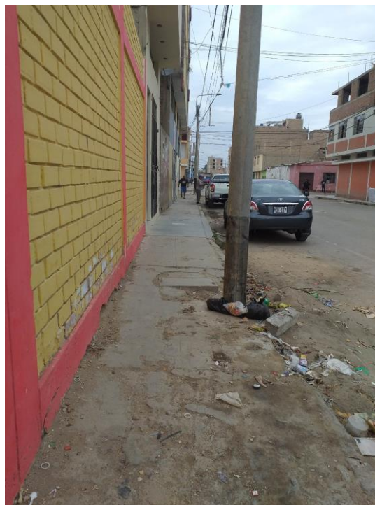
VISTA EXTERIOR DESDE CALLE 7 DE ENERO Y ANDRES RAZURI, SE EVIDENCIA SALITRE EN CERCO PERIMETRICO
