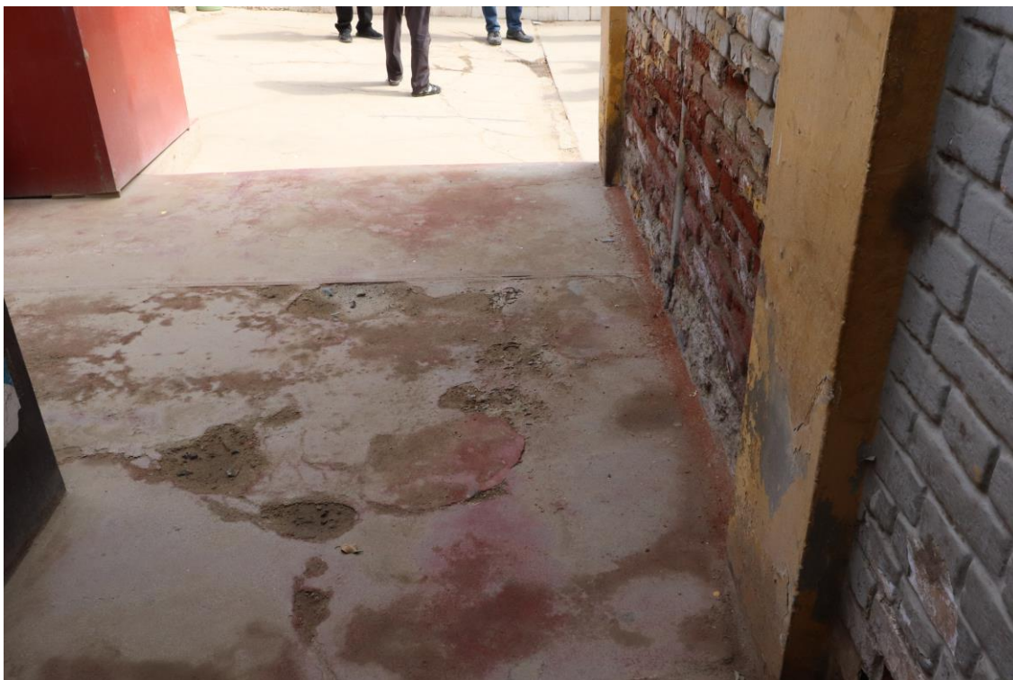
VEREDA EXTERIOR DEL KIOSCO Y CAFETIN, DONDE SE APRECIA DETERIORO EN LA SUPERFICIE
