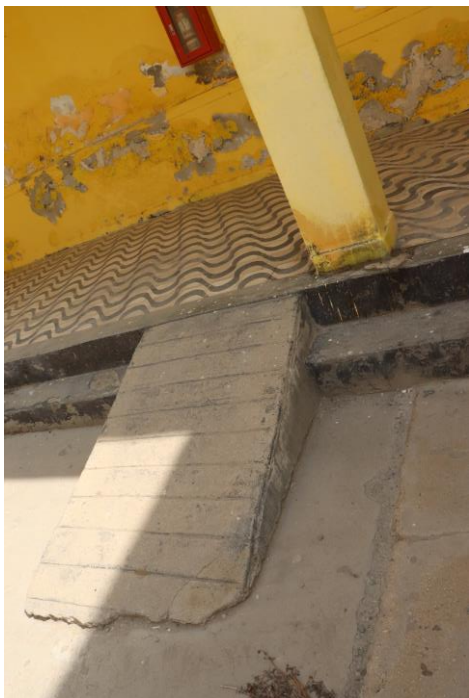
VISTA EXTERIOR DONDE SE OBSERVA LA RAMPA Y VEREDAS EN REGULAR ESTADO DE CONSERVACIÓN
