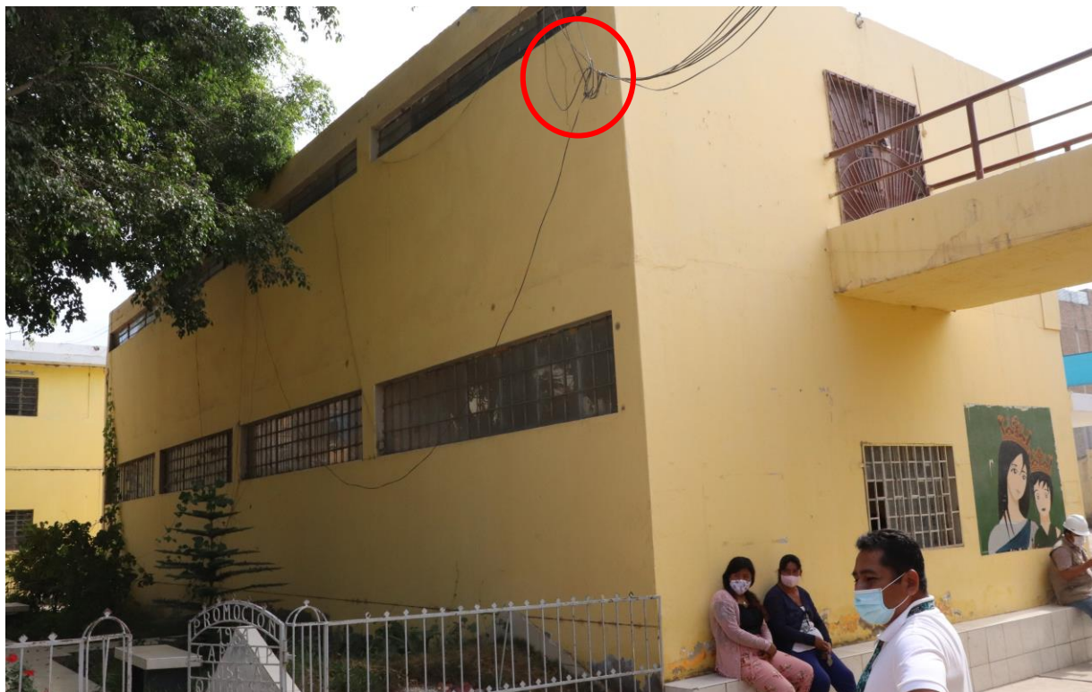
VISTA POSTERIOR DEL PABELLÓN 2 SE APRECIA CABLES EXPUESTOS
