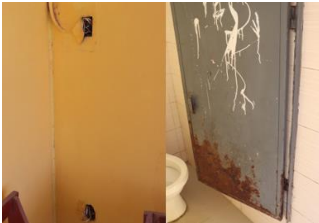
VISTAS DE INTERIORES DONDE SE APRECIA, CONEXIONES EXPUESTAS Y CARPINTERÍA METÁLICA EN PUERTAS EN MAL ESTADO
