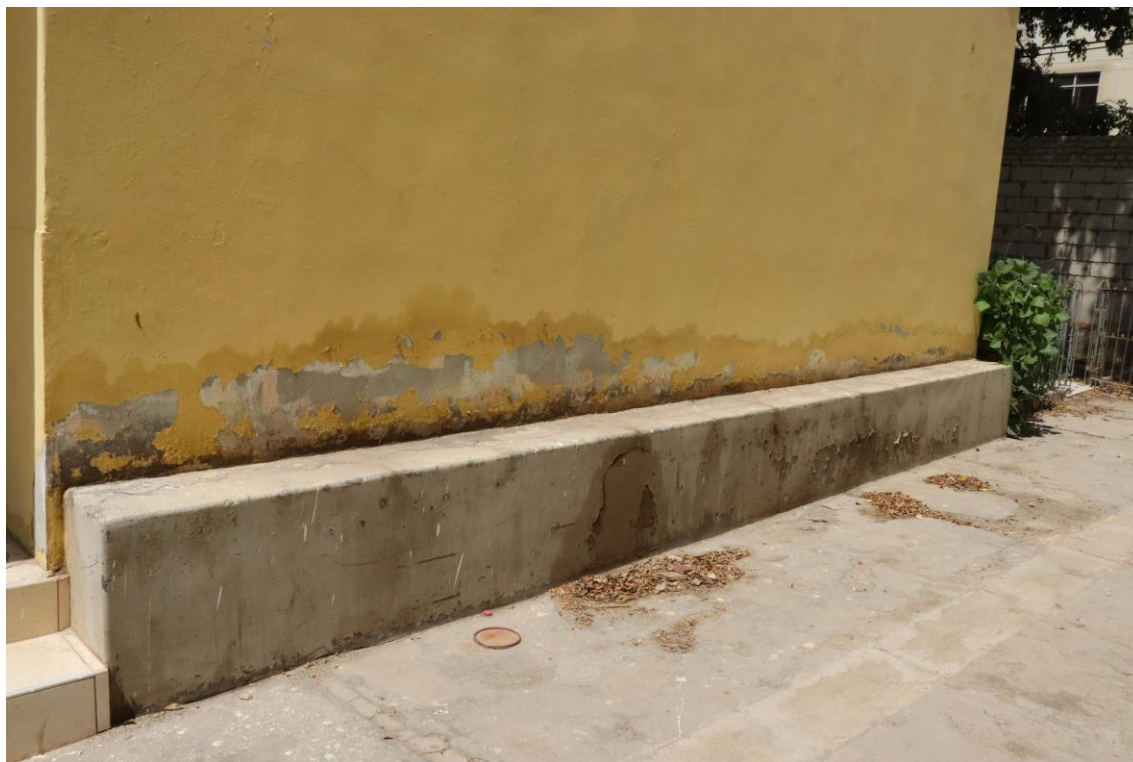
EXTERIOR DEL PABELLON 2, SE OBSERVA PRESENCIA DE SALITRE EN BANCA DE CONCRETO
