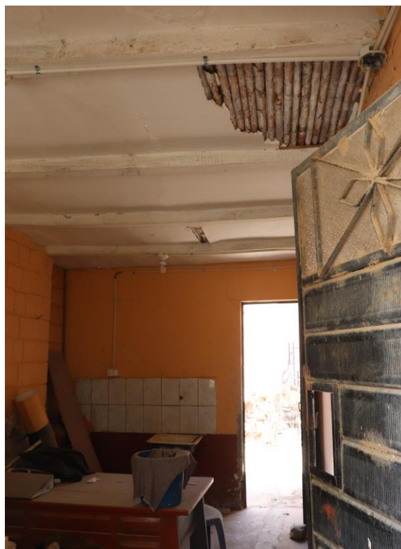
VISTA INTERIOR DONDE SE OBSERVA EL MAL ESTADO DE LA LOSA DE ADOBE CON QUINCHA
