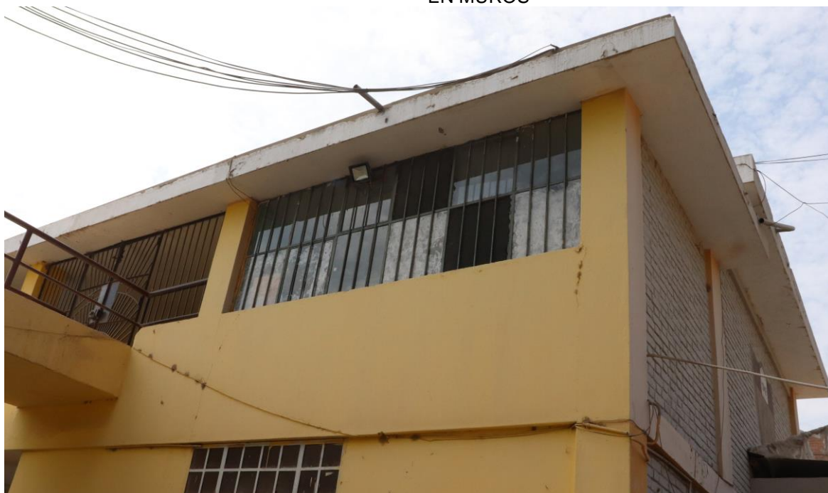
VISTA EXTERIOR DEL PABELLÓN 3 – SEGUNDO NIVEL, DONDE SE APRECIA LAS INSTALACIONES ELÉCTRICAS EXPUESTAS EN CONDICIONES INSEGURAS
