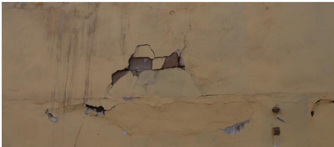
CERCO PERIMETRICO DE LA ZONA ESTE, SE EVIDENCIA GRIETAS
