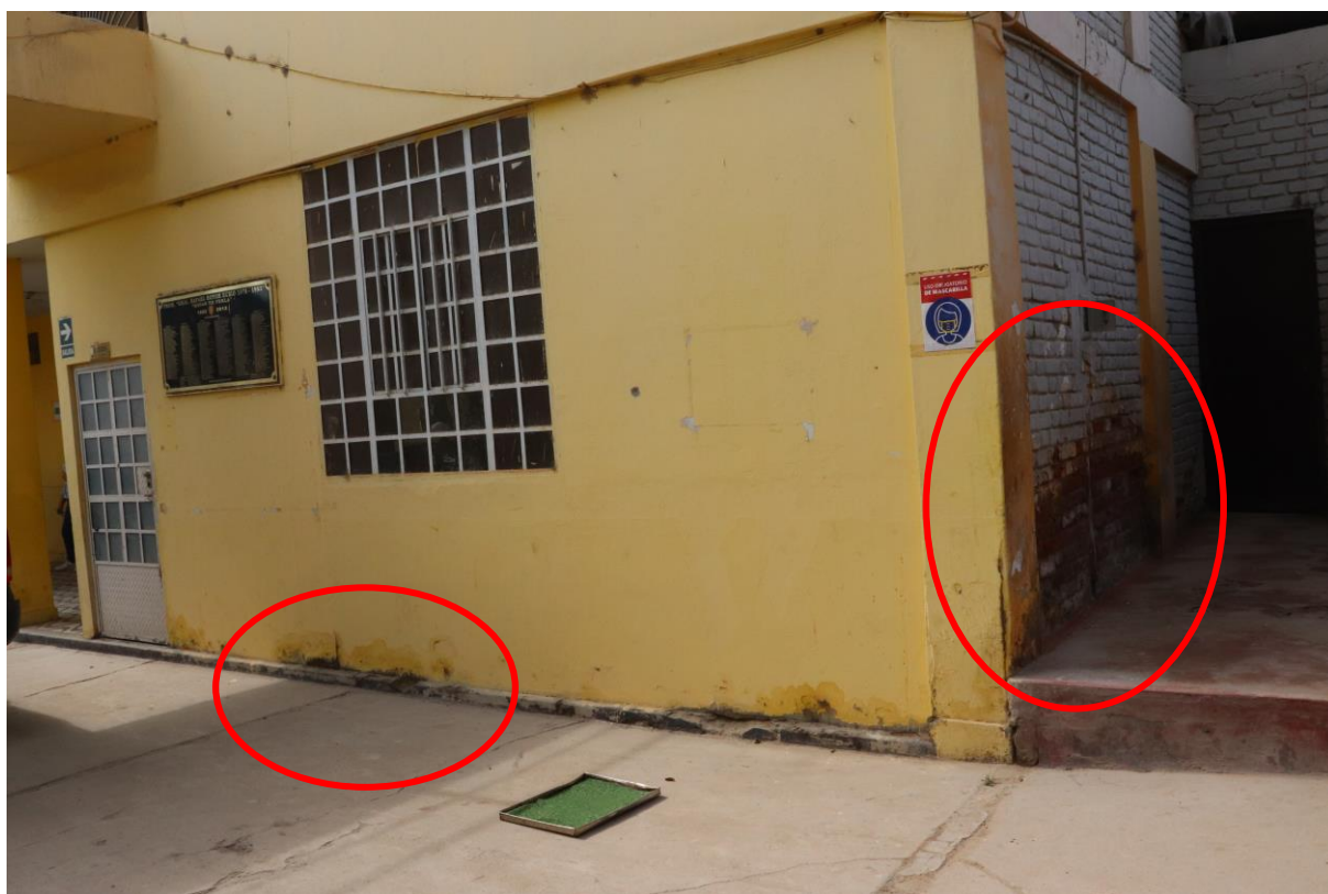
VISTA EXTERIOR DEL PABELLÓN 3 – PRIMER NIVEL, DONDE SE APRECIA EL DETERIORO Y SALITRE EN MUROS
