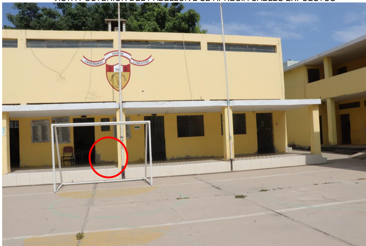
EN PASILLO DE PABELLÓN 2 SE APRECIA SALITRE DEBIDO A LA PRESENCIA DE HUMEDAD
