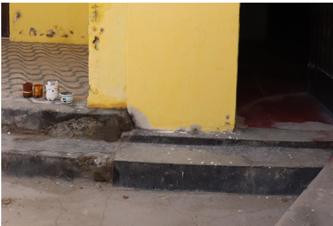
VEREDA EXTERIOR DEL KIOSCO Y CAFETIN, DONDE SE APRECIA DETERIORO EN LA SUPERFICIE
