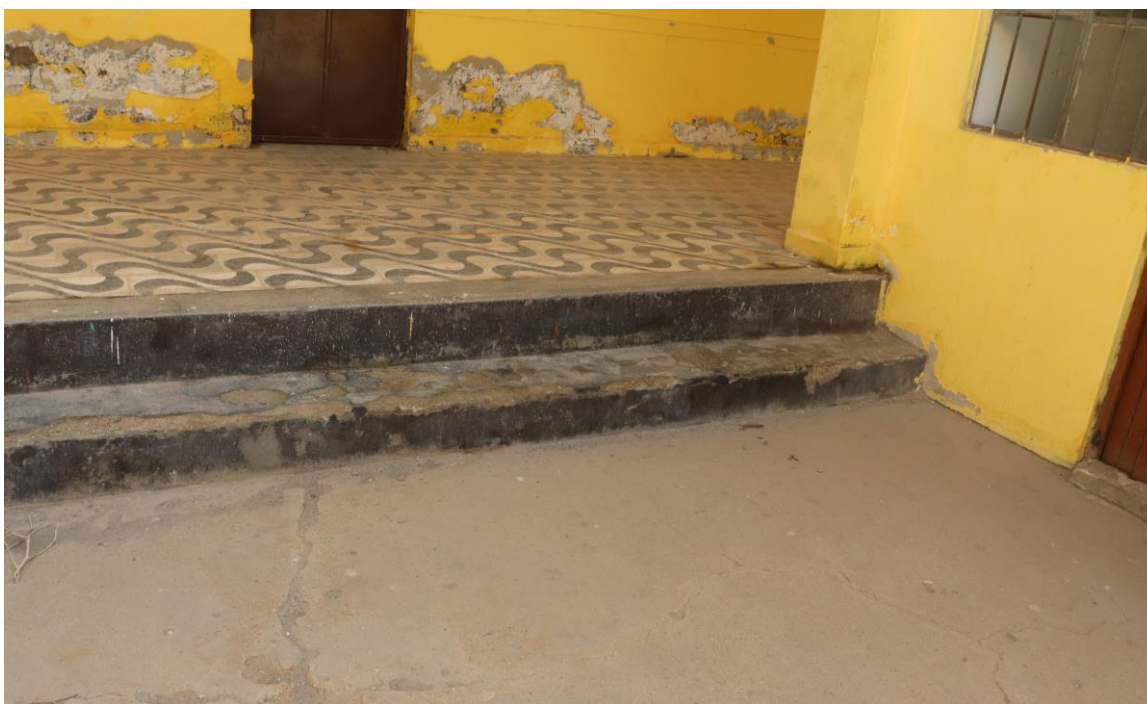
VEREDA DEL PABELLON 1, DONDE SE OBSERVA DETERIORO EN EL DESNIVEL
