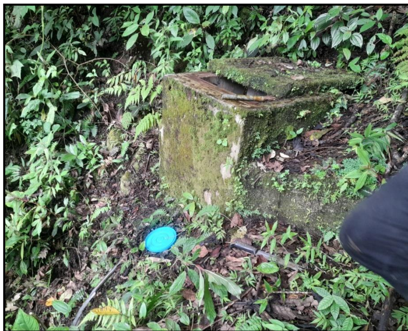
IMAGEN N° 4. Captación Existente Manantial Vista Hermosa 3
