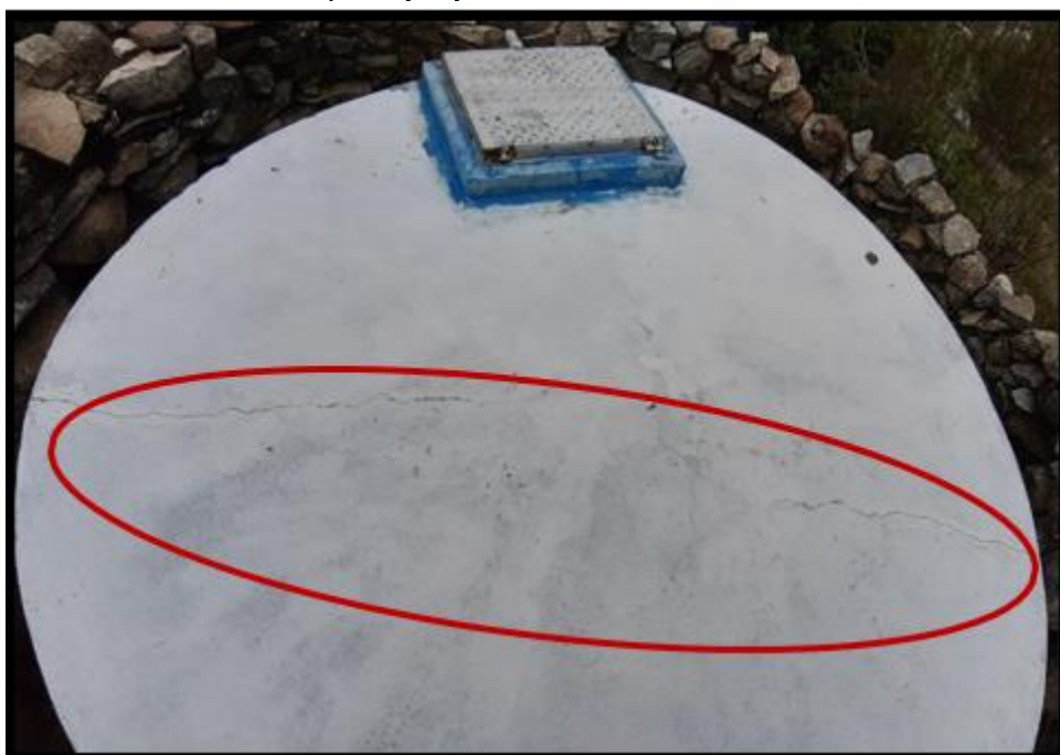
Imagen de vista del reservorio quintoyllay, se observa una fisura en el techo
