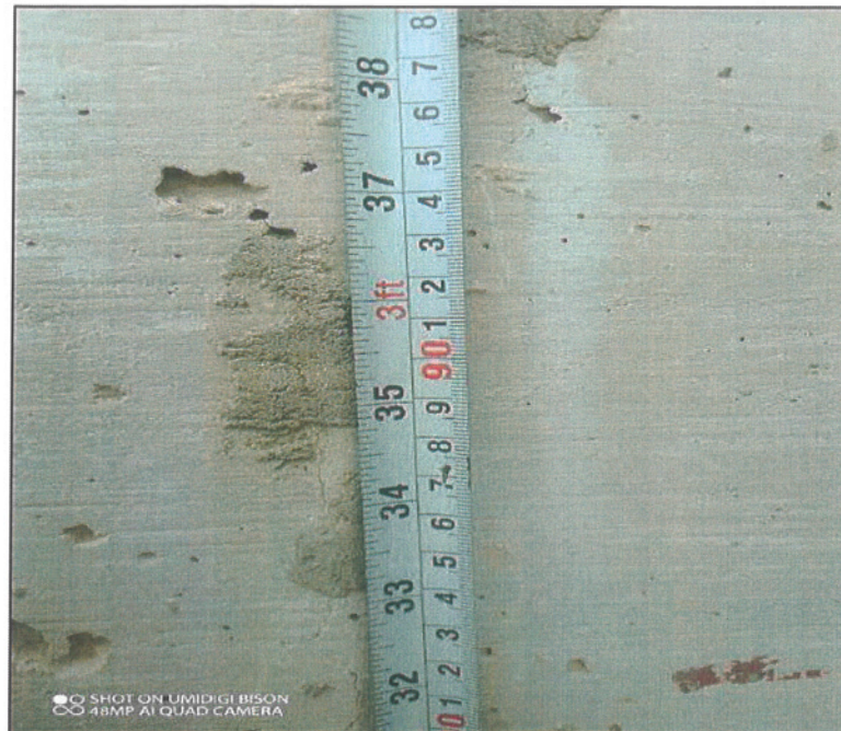
Medida de fisuras longitudinales de la viga invertida de la azotea, la cual viene siendo de 92.5 cm respectivamente.
