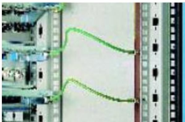
Ilustración 1: Guía de Puesta de Tierra Vertical
