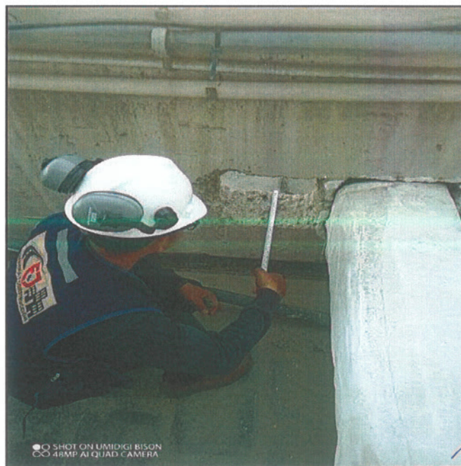
Ubicación: Azotea – Viga invertida perforada.
