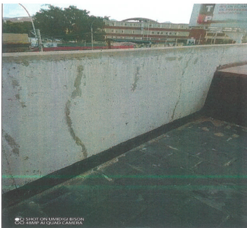
Vista de fisuras longitudinales resanadas en la viga invertida de la azotea (vista al hall de ingreso a la edificación).
