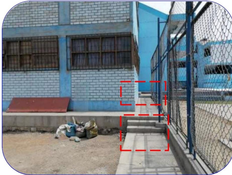
Fotografía N°05.- Vista de desnivel en zona de cancha de futbol, se requiere rampas de acceso según normativa.
