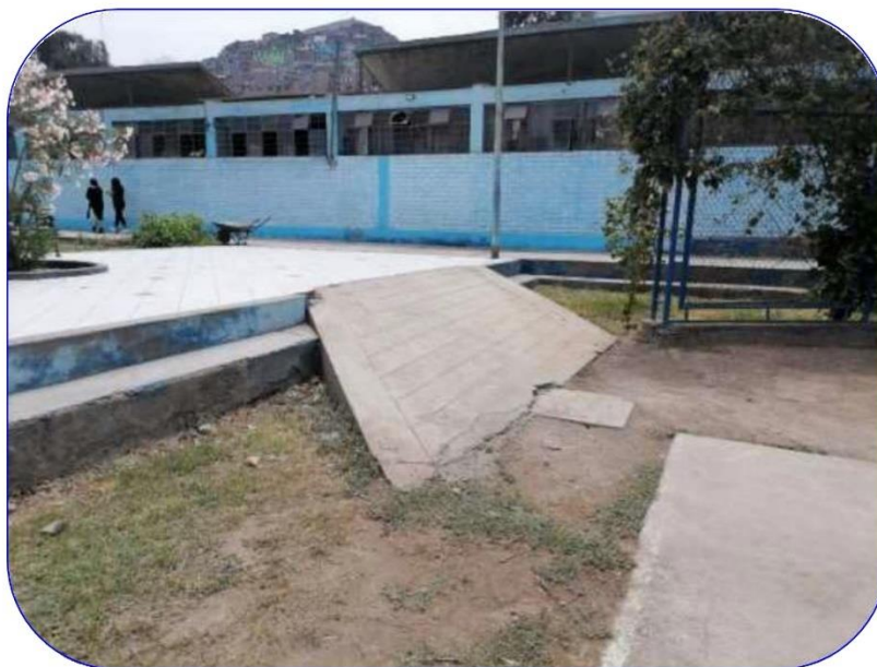
Fotografía N°04.- Vista de desnivel y rampa temporal en zona de cancha de futbol, se requiere rampa de acceso según normativa.
