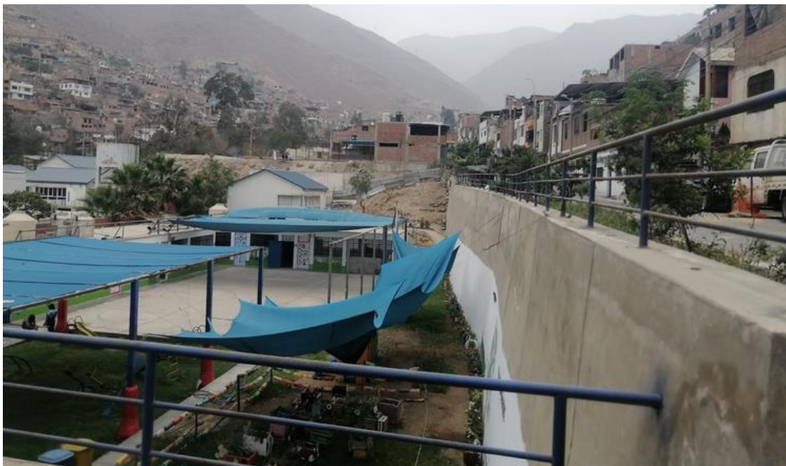
Imagen N°10: Cerco de muro de contención en la prolongación Los Héroes sin protección desde la vía pública, por lo que se requieren de un cerco tipo malla
