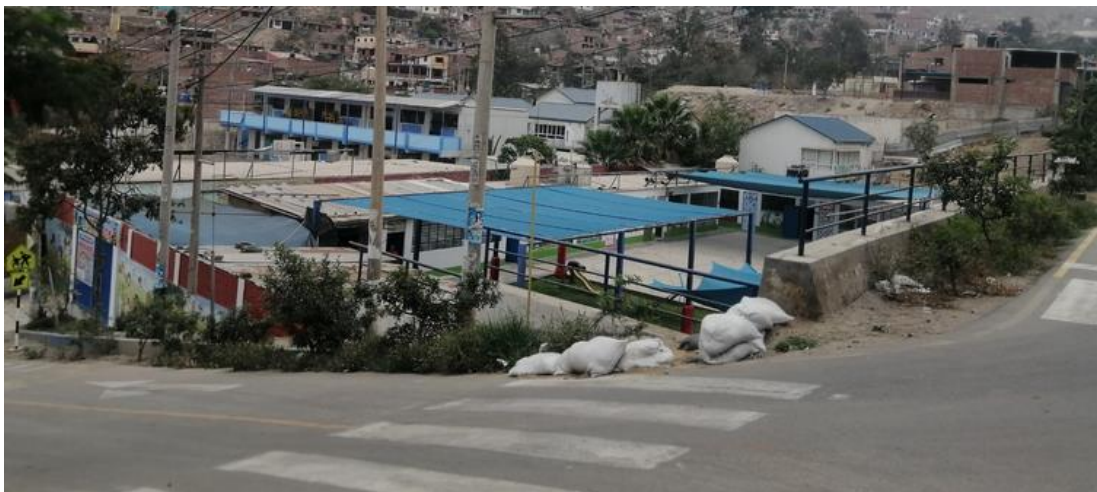
Imagen N°09: Cerco de muro de contención en la prolongación Los Héroes y Jr. Augusto Salazar Bondy sin protección desde la vía pública, por lo que se requieren cerco malla.
