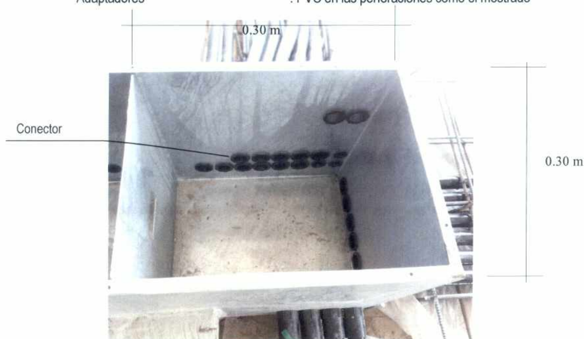
Detalle de Caja de Pase de Fierro Galvanizado en las Islas
