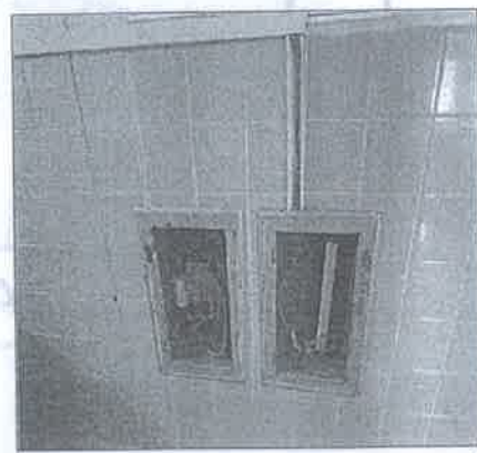
IMAGEN 10: TABLERO ELECTRICOS CON CABLES EXPUESTOS Y SIN MANTENIMIENTO
