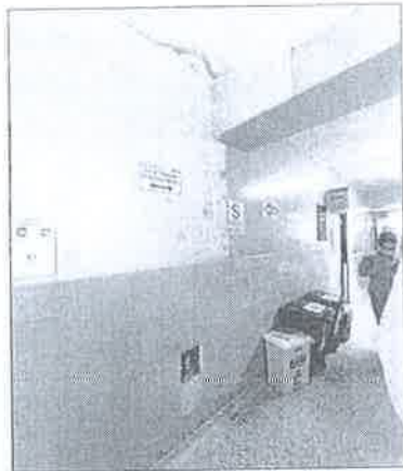
IMAGEN 05: TECHO CON PRESENCIA DE SALITRE EN CORREDOR LADO A
