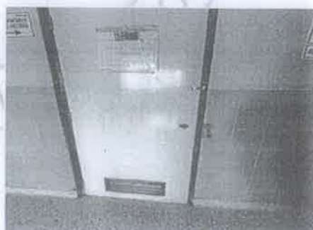
IMAGEN 28: ZOCALO DETERIORADO, PUERTA SIN MANIJA Y CON FALTA DE MANTENIMIENTO.
