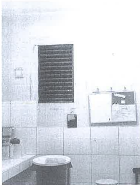
IMAGEN 29: VENTANA BATIENTE DAÑADA Y CON FALTA DE MANTENIMIENTO.
