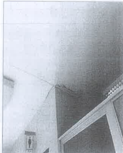
IMAGEN 12: TECHO CON PRESENCIA DE SALITRE Y DESPRENDIMIENTO DE PINTURA
