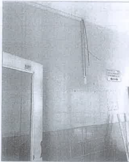
IMAGEN 11: CABLES EXPUESTOS
