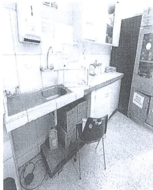
IMAGEN 30: DESPRENDIMIENTO DE CERAMICO, MUEBLE DE CONCRETO, LOCETAS ASTILLADAS Y MUEBLES ALTOS SIN CERRAJOS
