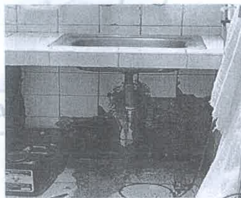
IMAGEN 22: INSTALACIONES SANITARIAS EN MAL ESTADO. ZOCALO SIN CERAMICO
