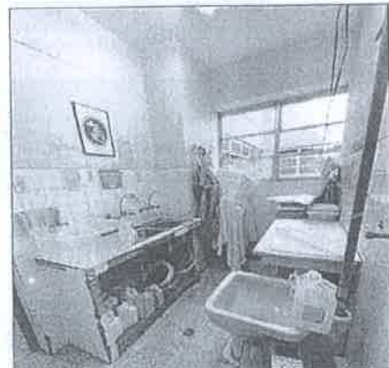
IMAGEN 08: DESPRENDIMIENTO DE CERAMICO EN MUEBLE DE CONCRETO
