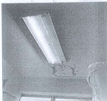
IMAGEN 09: TECHO CON PRESENCIA DE SALITRE Y LUMINARIA CON FLUORESCENTE QUEMADO
