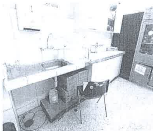
IMAGEN 18: DESPRENDIMIENTO DE CERAMICO EN MUEBLE DE CONCRETO, LOCETAS ASTILLADAS Y MUEBLES ALTOS SIN CERROJOS
