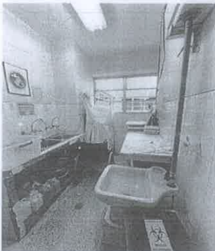
IMAGEN 25: DESPRENDIMIENTO DE CERAMICO EN MOBLE DE CONCRETO, LOCÍAS ASTILLADAS Y MUEBLES ALTOS SIN CERROSJOS
