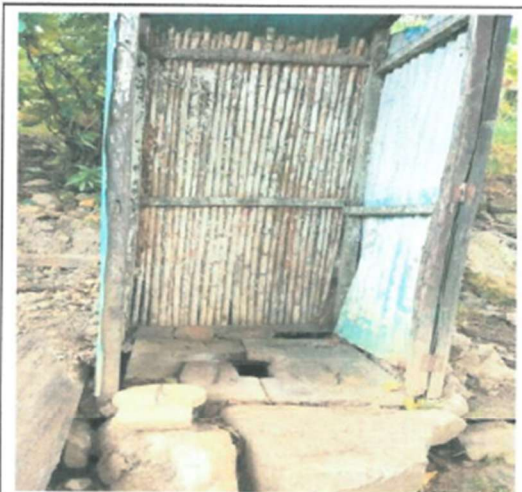
Fotografía 4. Letrina con pozo ciego en mal estado de conservación, sin caseta adecuada, tubería de ventilación y losa
