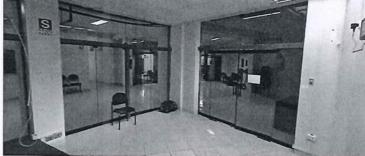
Instalación de lámina de seguridad de 4μ color blanco en el interior y color negro en el exterior.
