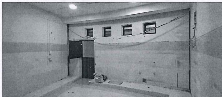
Demolición de la losa de concreto revestido con cerámico, resane de muros, piso y pintado de muros.
