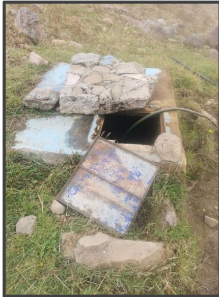
Imagen N°5. Vista de la cámara rompe presión existente
