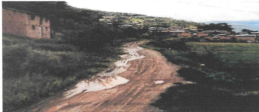
Foto N° 39: Baches en la vía, cunetas colmatadas, se proyecta alcantarilla Km. 29+080
