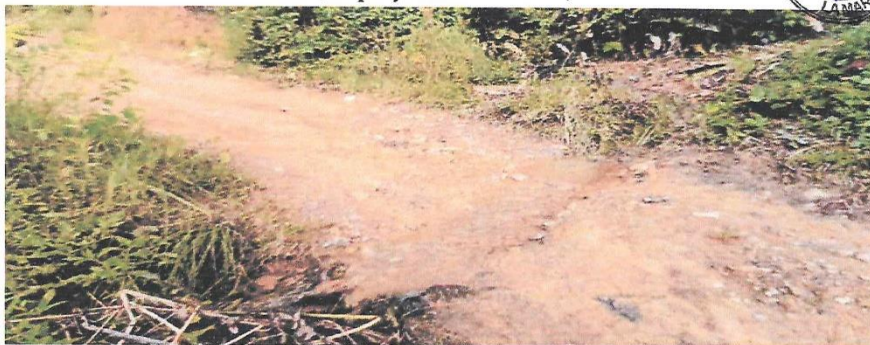
Foto N° 36: Cunetas colmatadas, se proyecta alcantarilla, Km. 28+200
