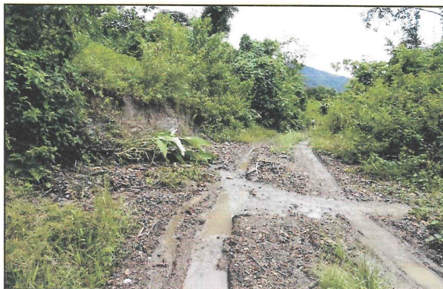
Foto N° 14: Fuente de agua, rodadura deteriorada con cunetas colmatadas alcantarilla proyectada en Km. 21+766
