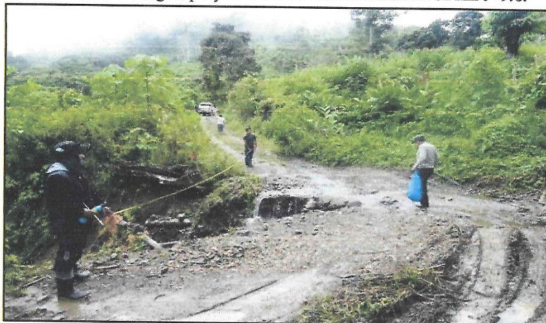
Foto N° 4: Fuente de agua, proyección de un badén 8.0x4.50m en Km 0+975.
