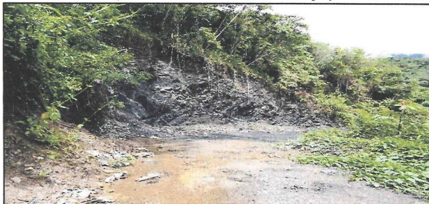
Foto N° 17: Fuente de agua, rodadura deteriorada, alcantarilla proyectada Km. 22+236
