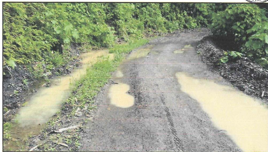
Foto N° 34: Baches en la vía, cunetas colmatadas Km. 27+580.00.
