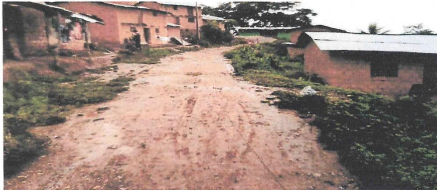
Foto N° 40: Superficie de Rodadura Deteriorada, Cunetas Colmatadas, Km. 29+200
