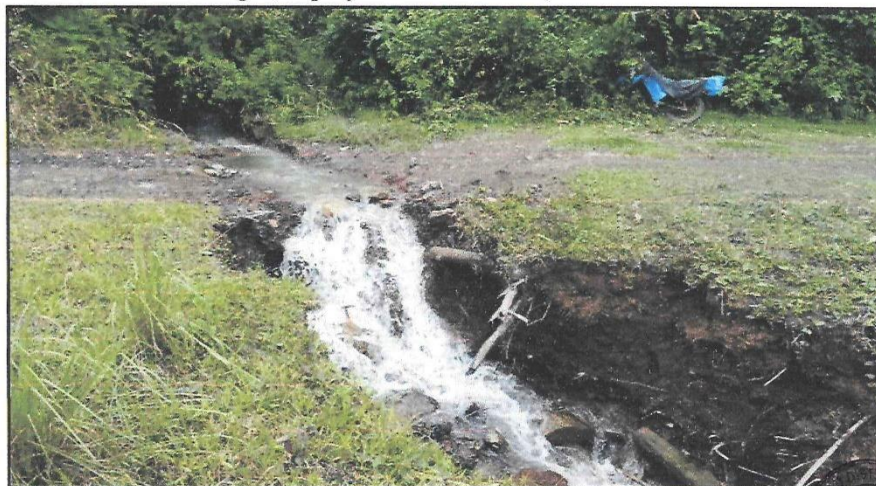
Foto N° 32: Fuente de agua, se proyectada alcantarilla, Km. 26+496
