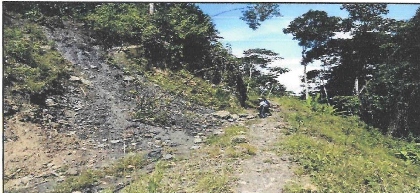
Foto N° 27: Superficie de rodadura deteriorada con cunetas colmatada, Km. 25+040
