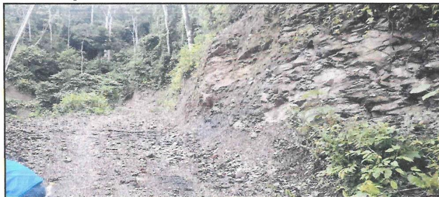
Foto N° 22: Superficie de rodadura deteriorada con cunetas colmatadas, Km. 23+960
