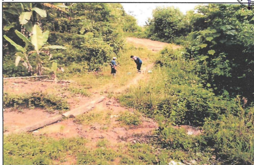
Foto N° 43: Superficie de rodadura deteriorada, cunetas colmatadas, alcantarilla proyectada Km. 29+481
