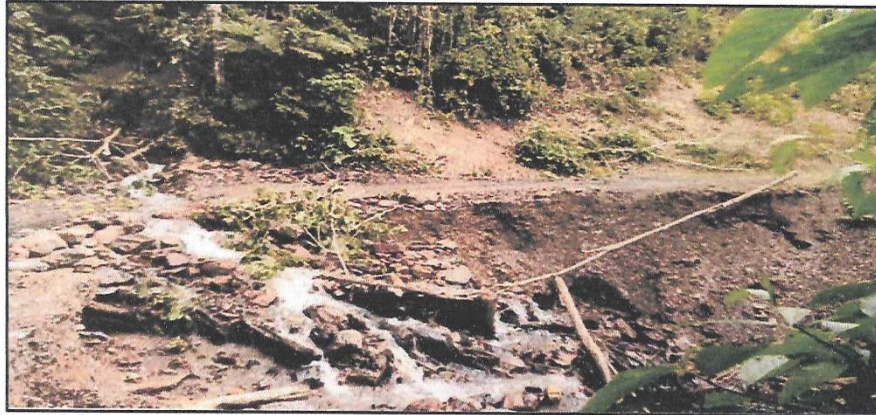
Foto N° 35: Fuente de agua, superficie de rodadura deteriorada, se proyectada alcantarilla, Km. 27+705
