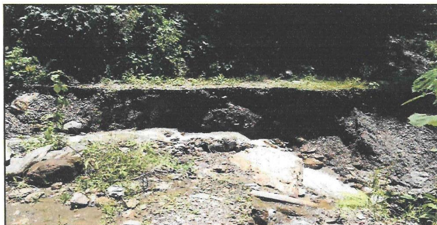
Foto N° 22: Superficie de rodadura deteriorada con cunetas colmatadas, Km. 23+960
