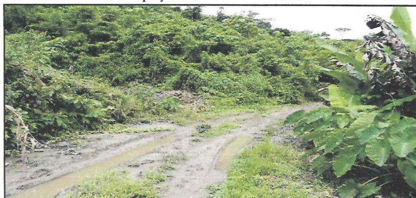
Foto N° 18: Fuente de agua, rodadura deteriorada con cunetas colmatadas, alcantarilla proyectada Km. 22+644
