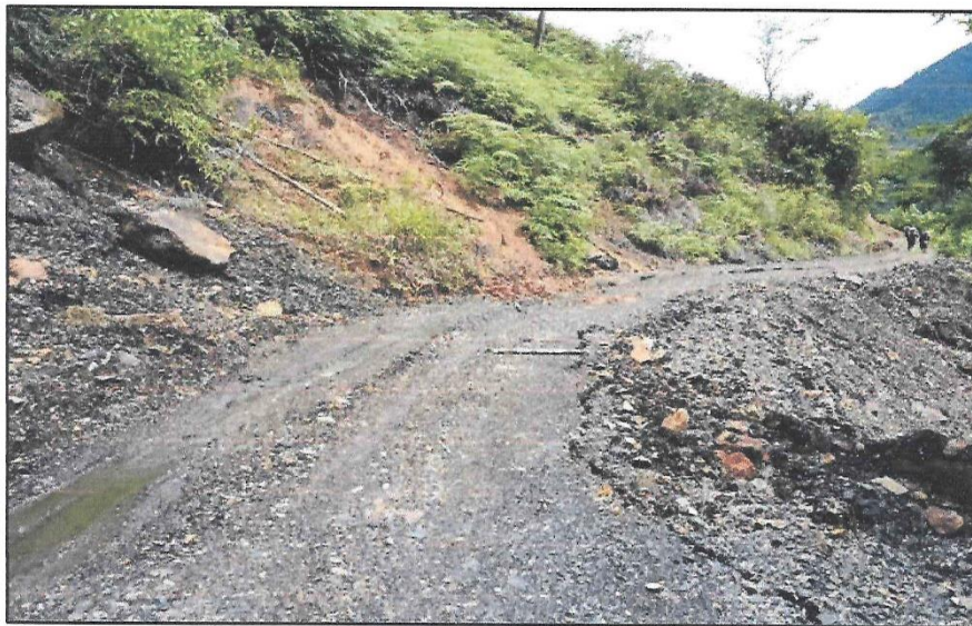
Foto N° 13: Superficie de rodadura deteriorada con cunetas colmatadas Km. 21+220
