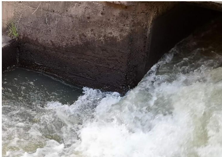
Imagen 02: Vista de flujo turbulento de agua en canal de descarga exterior, que provocan pérdida de superficie de concreto.
