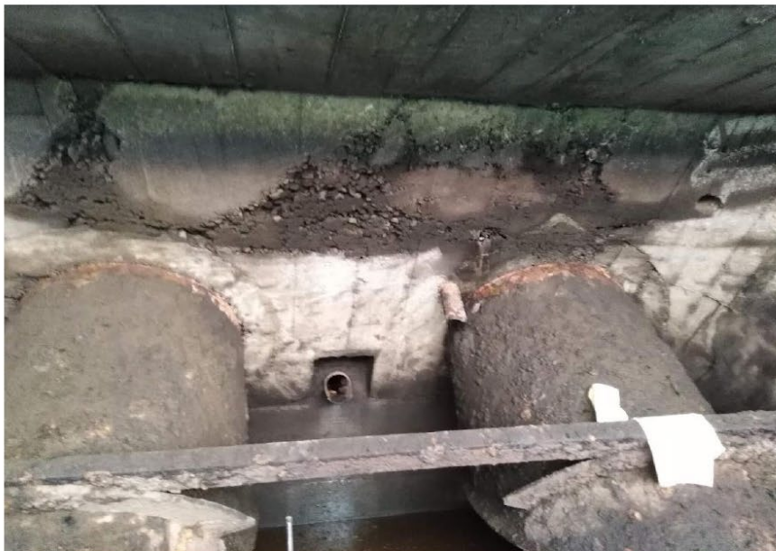
Imagen 07: Elementos de concreto con pérdida de recubrimiento superficial por acción de la turbulencia del agua.
