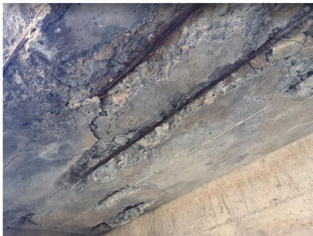
Imagen 06: Varillas de refuerzo de acero expuestas en piso de casa de máquinas.
