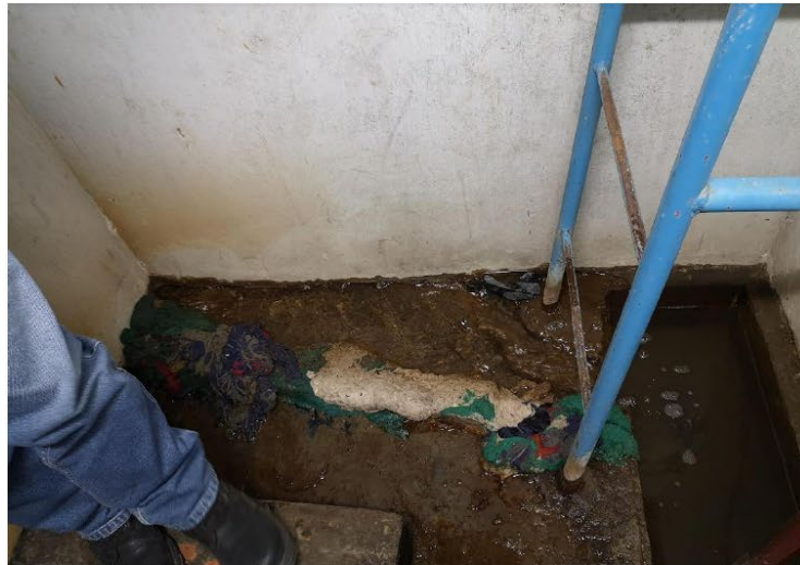
Imagen 01: Condiciones de filtración de agua en zona de sótanos y afectación de instalaciones eléctricas.
