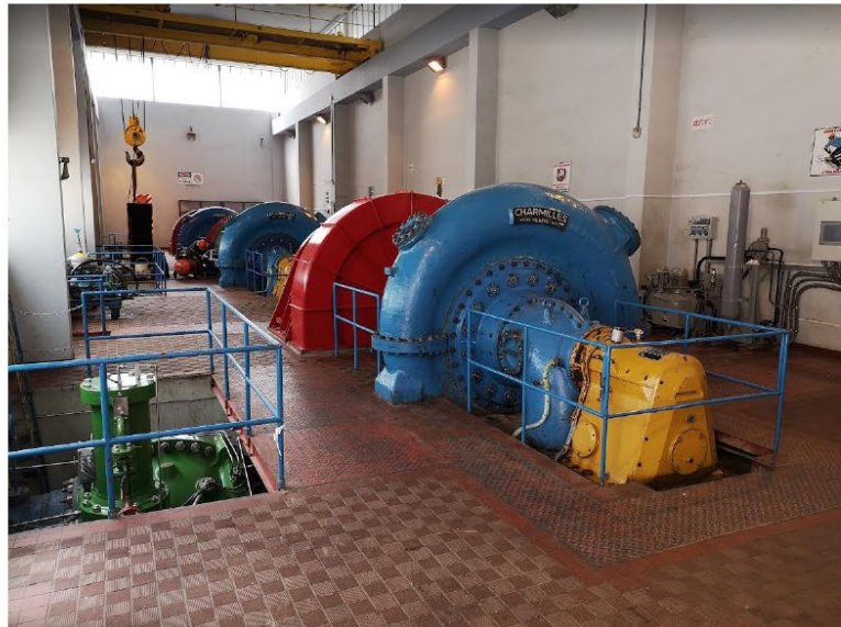
Imagen 04: Vista general de la Casa de Maquinas, donde se aprecian vigas de soporte de puente grúa y columnas peraltadas cuya cimentación se debe evaluar.
