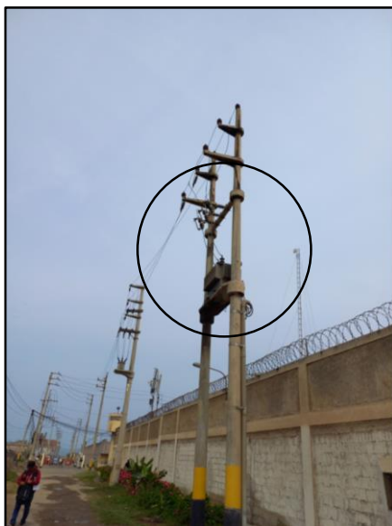
Imagen 5. Tramo de conductor Cu 25mm 2 a reemplazar
