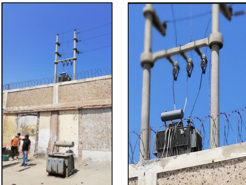
Imagen 4. Subestación aérea biposte (SAB)
