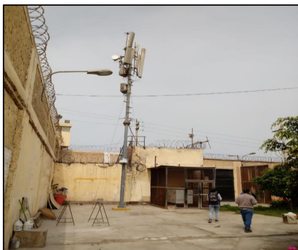
Imagen 19. Luminaria Na 250W en pastoral de pared perimetral
