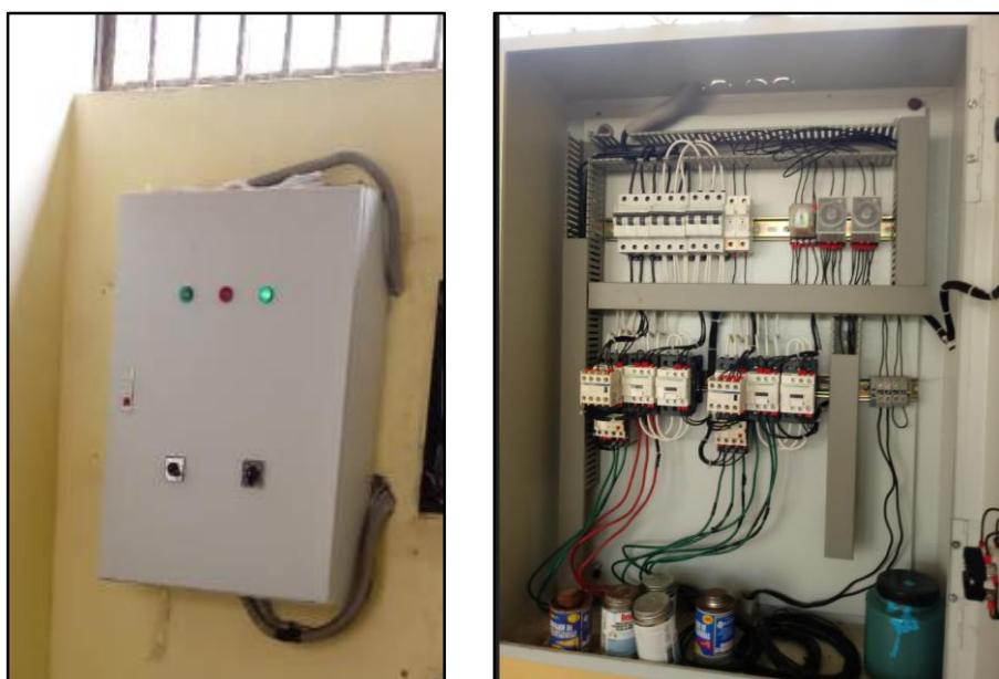
Imagen 11. Tablero de fuerza y control de electrobombas
