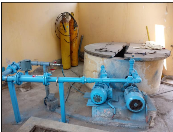
Imagen 15. Electrobombas de cloración
