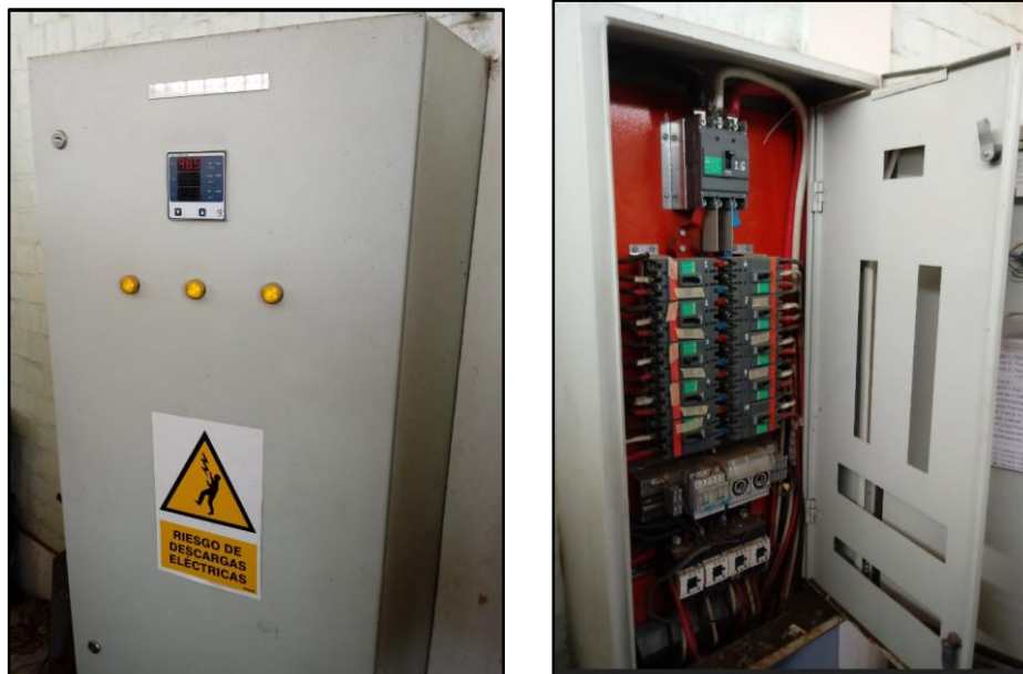
Imagen 8. Tablero de emergencia adosado
