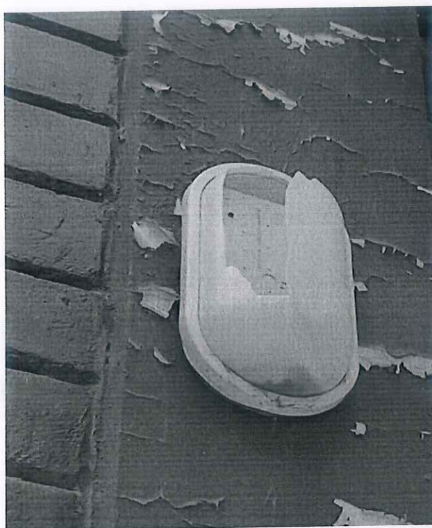
Luminarias exteriores dañadas, pintura dañada por la humedad
