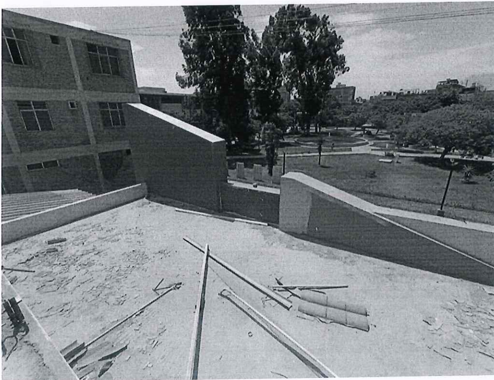
Techos sin drenaje pluvial
