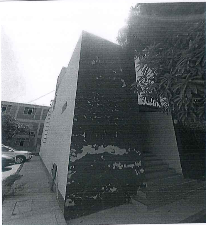
Acabados de pintura deteriorados por la humedad
