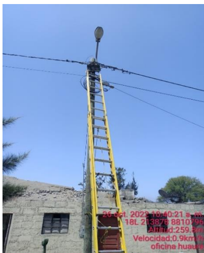
Caja de derivación en mal estado
