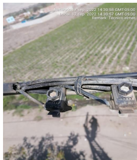
Conductor Tripolar en mal estado
