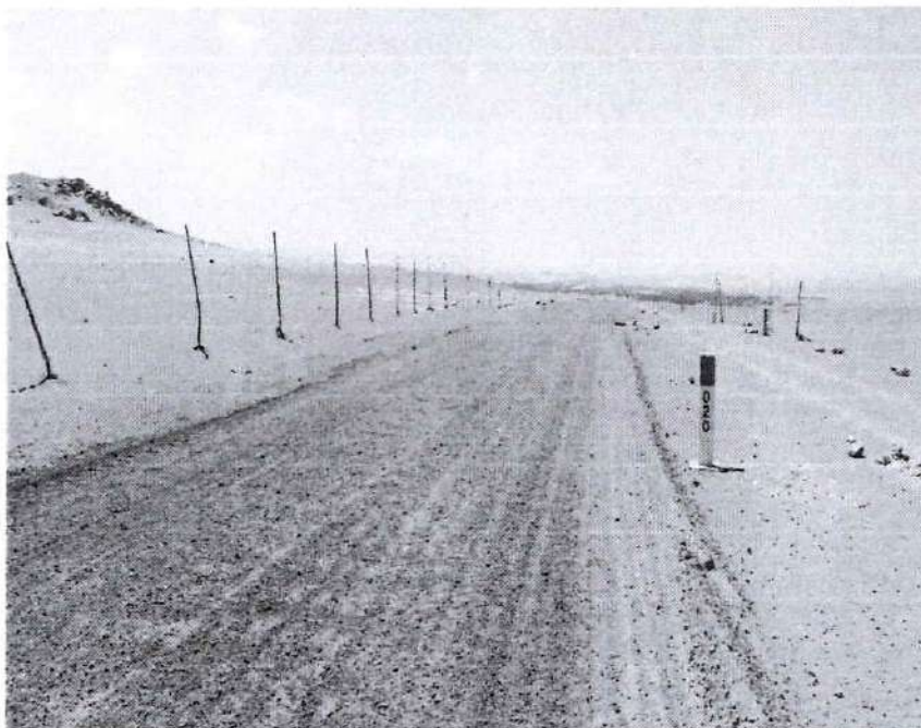
Foto N°03: Km. 20 Se aprecia e mal estado de la superficie de rodadura.
