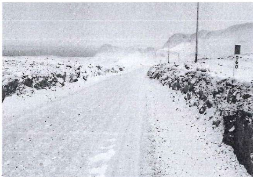
Foto N°07: Km. 60 Se aprecia superficie rodadura en malas condiciones.
