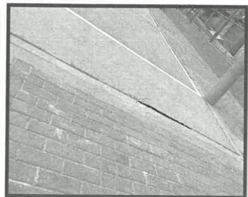
Imagen 02: Arco desgastado por el uso continuo.
