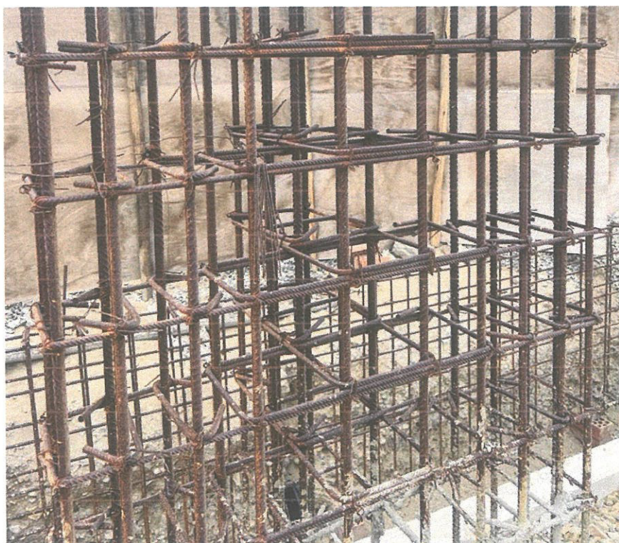
Imagen 6 Se evidencia que el acero de las columnas presenta oxido superficial, dado el tiempo de paralización de la obra (> 3 meses), y las condiciones del clima de la zona.
