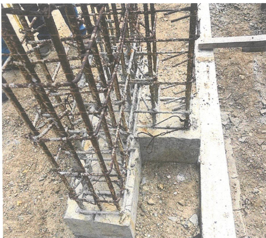
Imagen 5 En las columnas aun por vaciar, se evidencia espesor de recubrimiento menores al mínimo (4cm)
