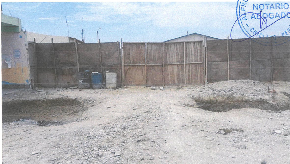
Imagen 12 Excavaciones para portada de ingreso
