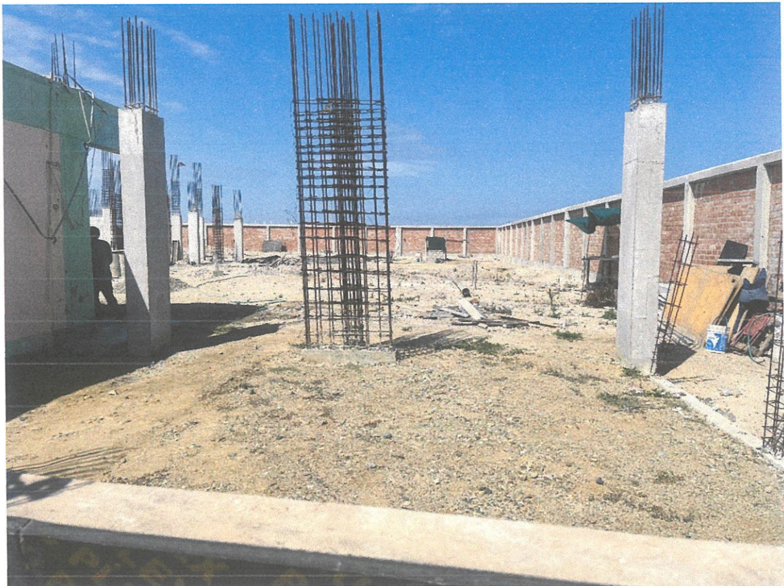
Imagen 10 Se aprecia el avance a nivel de cimentación ejecutado por el contratista.
