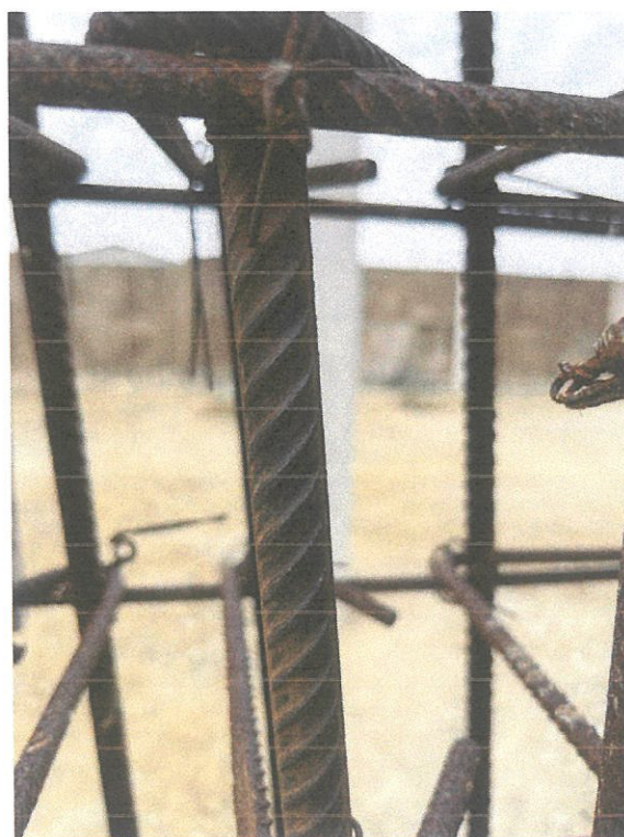
Imagen 7 Con lo descrito anteriormente se ha realizado una limpieza a una barra de acero, verificando que su sección no ha sido afectada, recomendándose su pronta protección.
