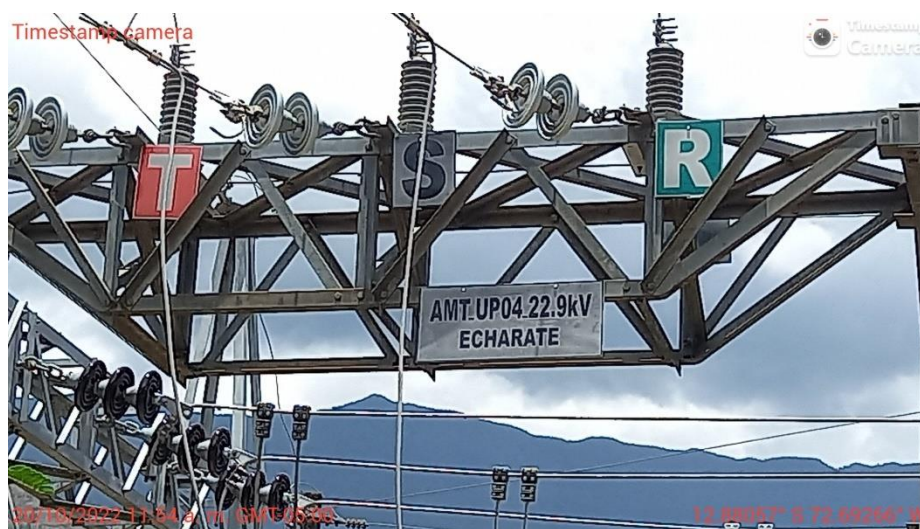
Figura 44: Fases en pórtico de llegada, SE Urpipata
