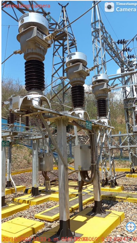
Figura 41: Transformador de corriente, Interruptores
