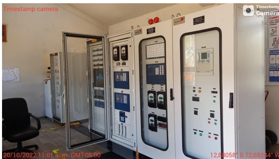
Figura 46: Tablero de control, protección y medición ; tablero auto portado; SE Uripata
