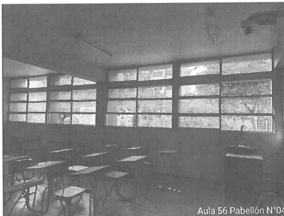
Figura 129. Reposición de hoja de ventana, instalar vidrio crudp e=6\text{mm} , laminado de 4 micras en ventanas y mantenimiento de ventanas incl. marcos y accesorios en aula 56 del B-04.
