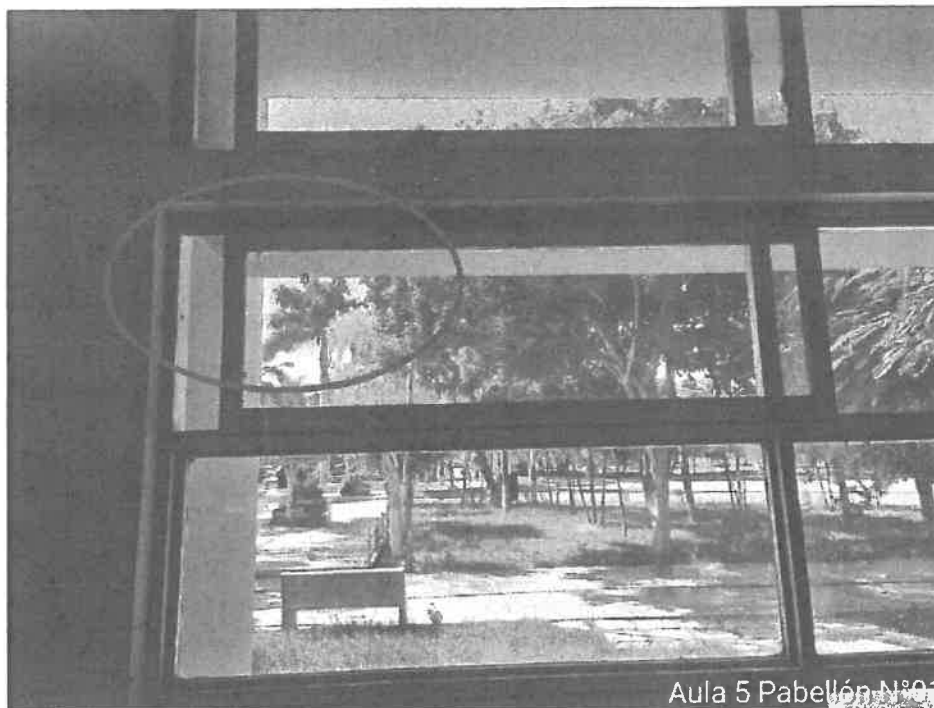
Figura 16. Vidrio quebrado por reemplazar en aula 5 del B-01.
