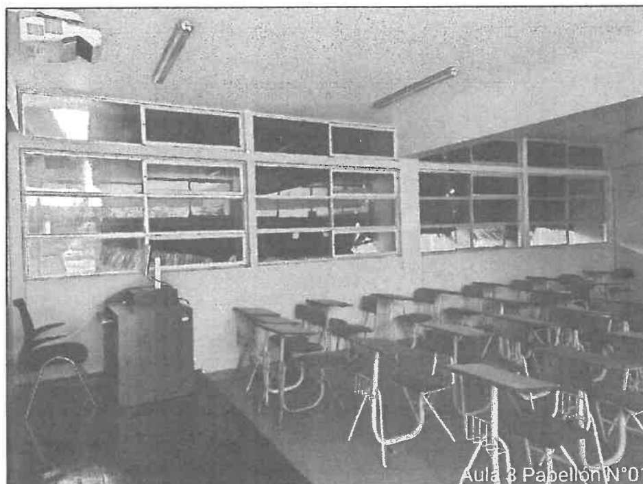
Figura 9. Reposición de hoja de ventana, instalar de lámina de 4 micras en vidrios, mantenimiento de ventanas incl. marcos y accesorios en aula 3 del B-01.
