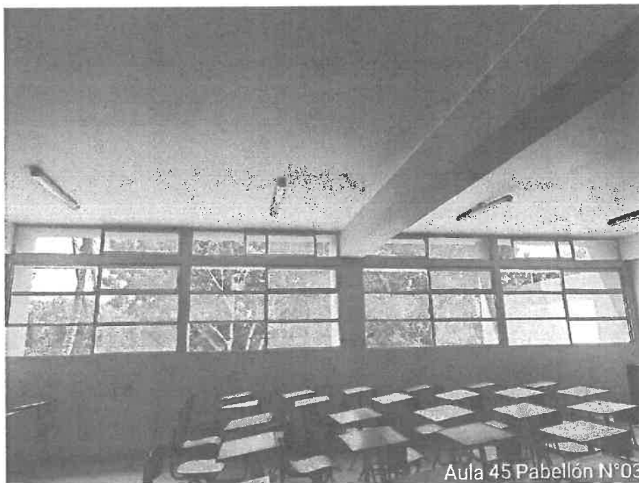
Figura 106. Reposición de hoja de ventana, laminado de 4 micras en ventanas y mantenimiento de ventanas incl. marcos y accesorios en aula 45 del B-03.
