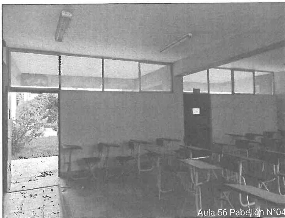
Figura 128. Laminado de 4 micras en ventanas y mantenimiento de ventanas incl. marcos y accesorios en aula 56 del B-04.
