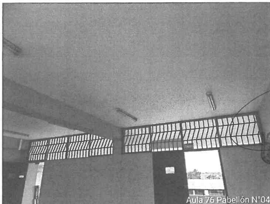
Figura 160. Desmontaje de protectores metálicos, laminado de 4 micras en ventanas y mantenimiento de ventanas incl. marcos y accesorios en aula 76 del B-04.
