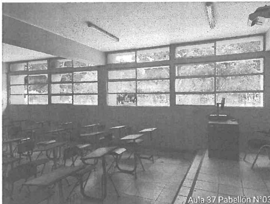
Aula 37 Pabellón N°03 Figura 90. Reposición de hoja de ventana, instalar vidrio crudo e=6mm, laminado de 4 micras en ventanas y mantenimiento de ventanas incl. marcos y accesorios en aula 37 del B-03.
