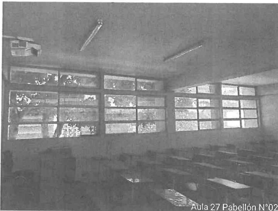
Figura 68. Reposición de hoja de ventana, laminado de 4 micras en ventanas y mantenimiento de ventanas incl. marcos y accesorios en aula 27 del B-02.
