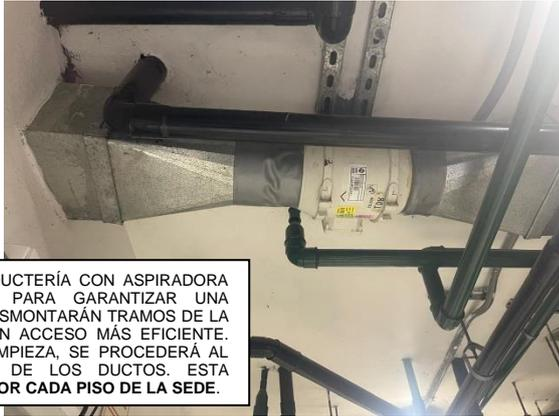
LIMPIEZA INTERNA DE LA DUCTERÍA CON ASPIRADORA INDUSTRIAL PAR POLVO. PARA GARANTIZAR UNA LIMPIEZA PROFUNDA, SE DESMONTARÁN TRAMOS DE LA DUCTERÍA, PERMITIENDO UN ACCESO MÁS EFICIENTE. UNA VEZ FINALIZADA LA LIMPIEZA, SE PROCEDERÁ AL ENSAMBLAJE Y SELLADO DE LOS DUCTOS. ESTA ACTIVIDAD SE REALIZARÁ POR CADA PISO DE LA SEDE.
