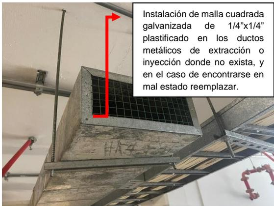
Instalación de malla cuadrada galvanizada de 1/4"x1/4" plastificado en los ductos metálicos de extracción o inyección donde no exista, y en el caso de encontrarse en mal estado reemplazar.
