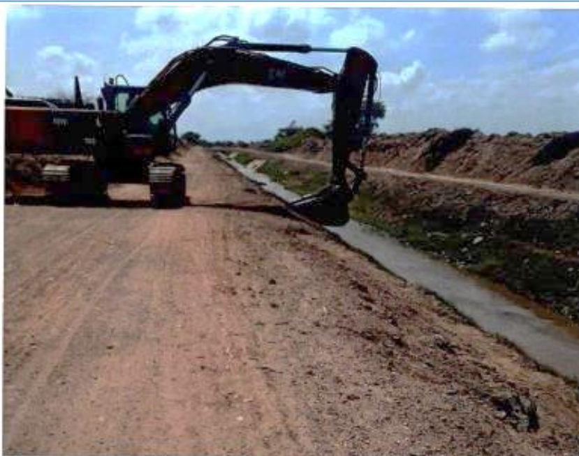
Foto N° 09: Se aprecia excavadora realizando Trabajos de conformación de talud margen izquierda en Dren II-II.
