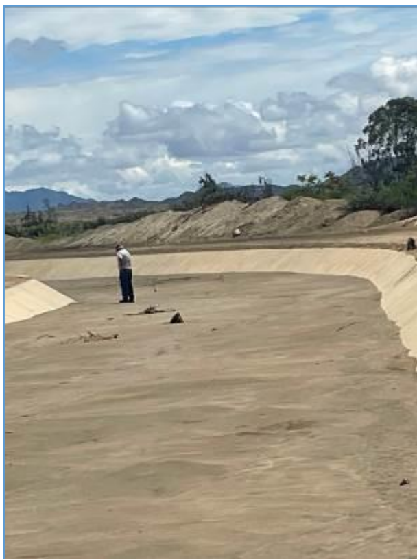
Colmatación de canal en progresiva Km 9+772.5 (aproximadamente 1 Km de longitud)
