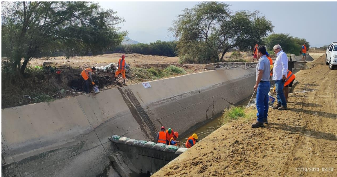
Figura N° 16: Mantenimiento en Canal Derivador Talambo Zaña.
