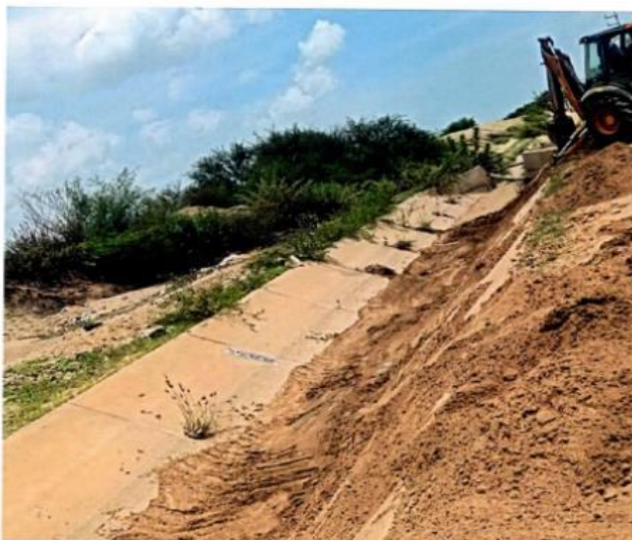
Foto N° 02: Se aprecia Trabajos de limpieza y descolmatación en canal lateral TP 5'
