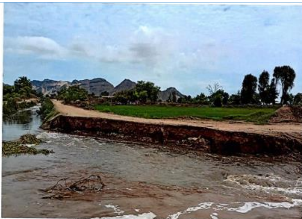
Foto N° 11: Tramo km 3+770.23 al km 3+820.23 Coordenadas 658847 E, 9211924 N Rotura total del camino en la confluencia del Dren IV-IV y Dren I-I.
