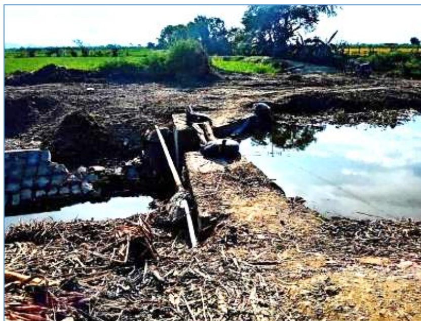
Foto N° 01: Se aprecia daños ocasionados por lluvias intensas en Dren I-I
