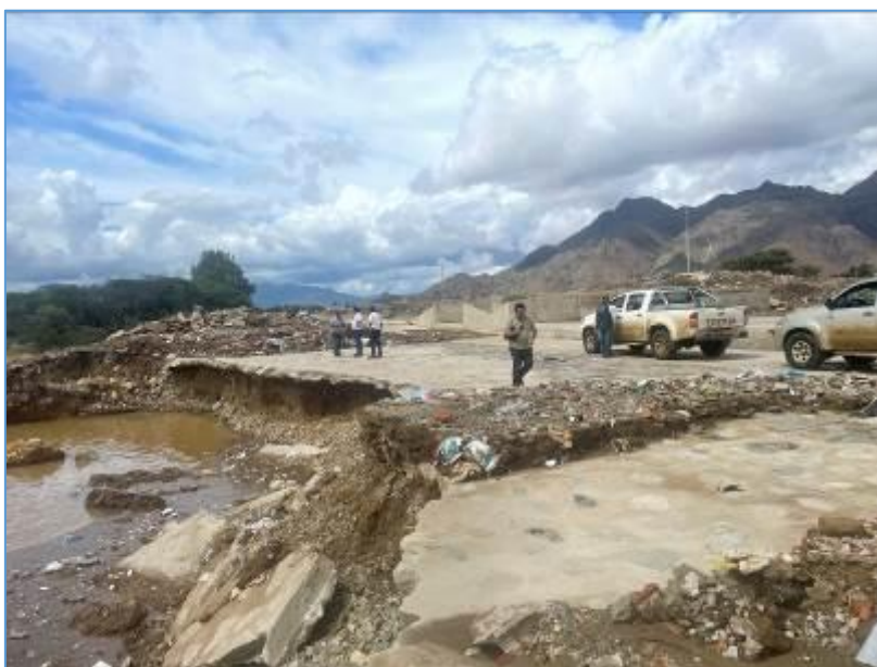
Socavamiento y pérdida de talud, progresiva Km 15+545
