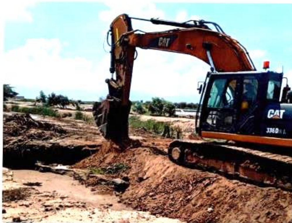
Foto N° 08: Se aprecia excavadora realizando Trabajos de conformación de talud margen izquierda en Dren I-I.
