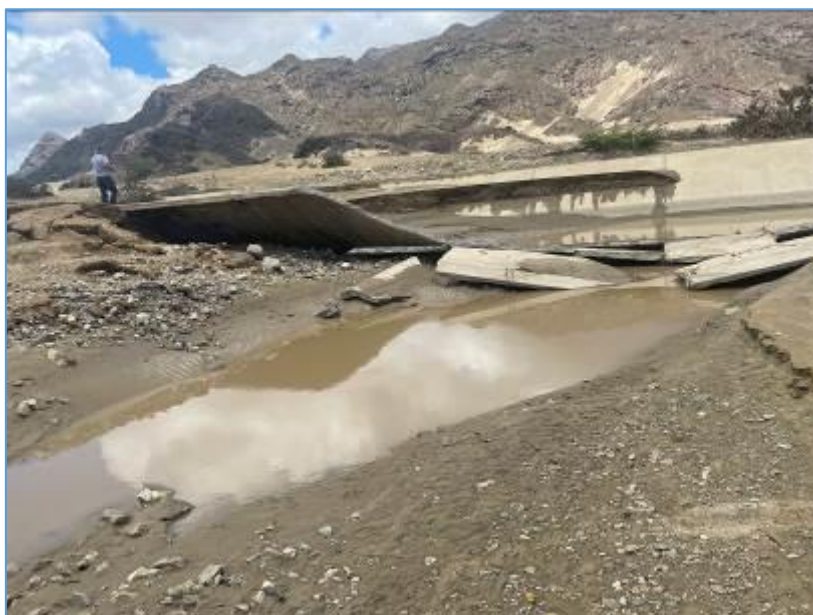
Rotura de canal, progresiva Km 9+000
