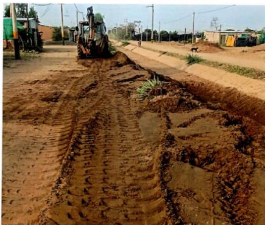
Foto N° 03: Se aprecia retroexcavadora realizando Trabajos de limpieza y descolmatación en canal lateral TP 5'
