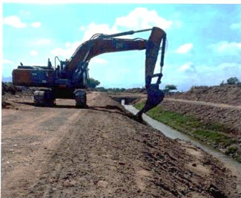
Foto N° 10: Se aprecia excavadora realizando Trabajos de conformación de talud margen izquierda en Dren II-II.
