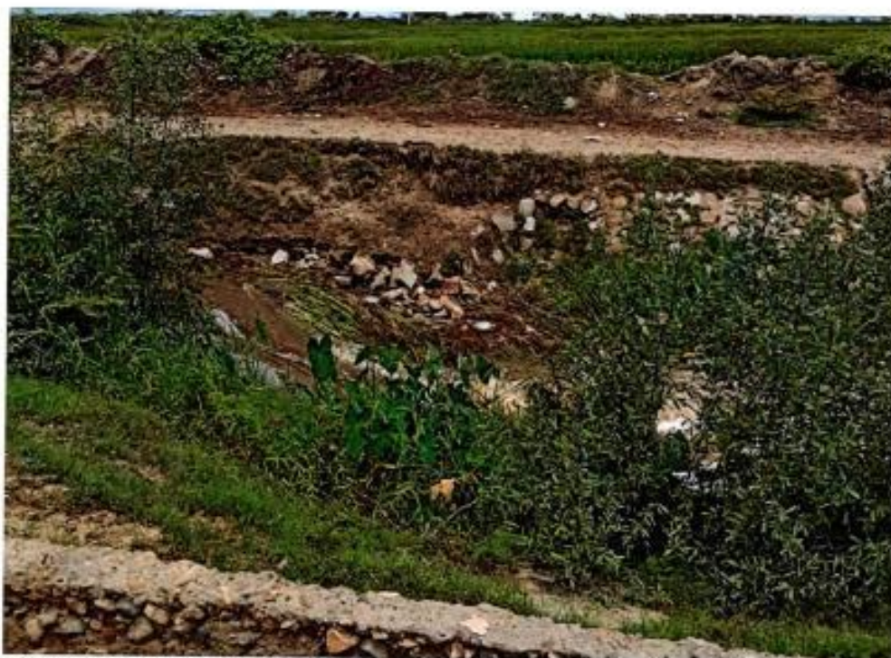
Foto N° 12: Rotura de la sección central de la mampostería de la caída en la margen izquierda del Dren IV-IV
