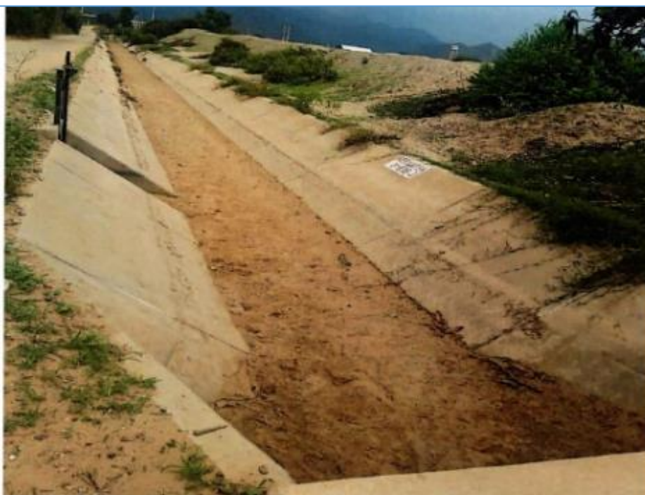
Foto N° 01: Se aprecia canal colmatado ocasionado por lluvias intensas.
