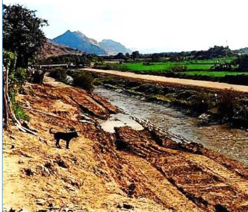
Foto N° 02: Se aprecia daños ocasionados por lluvias intensas en Dren I-I
