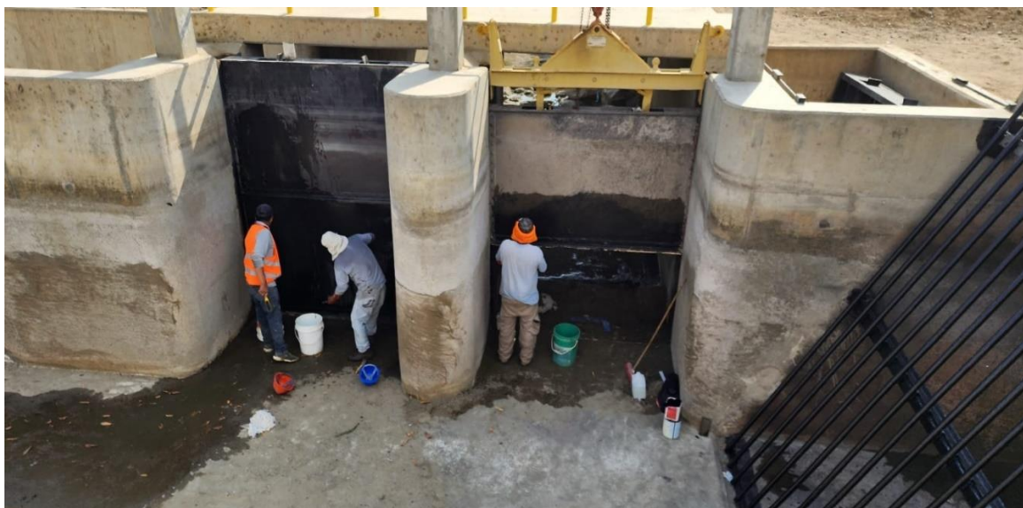
Figura N° 17: Mantenimiento de Compuertas en Sifón Chamán.
