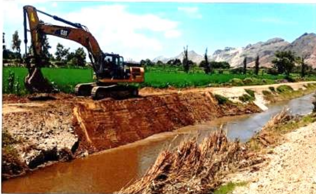
Foto N° 07: Se aprecia excavadora realizando Trabajos de conformación de talud margen derecha en Dren I-I.
