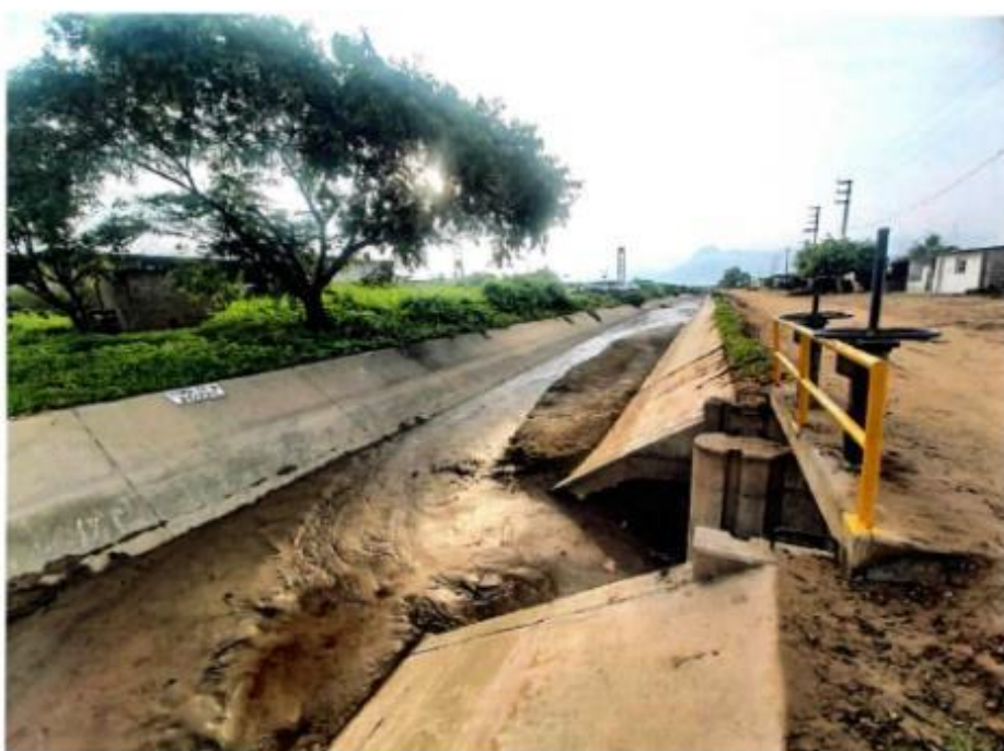
Foto N° 02: Se aprecia ingreso del canal Toma Principal TP 5' colmatado.
