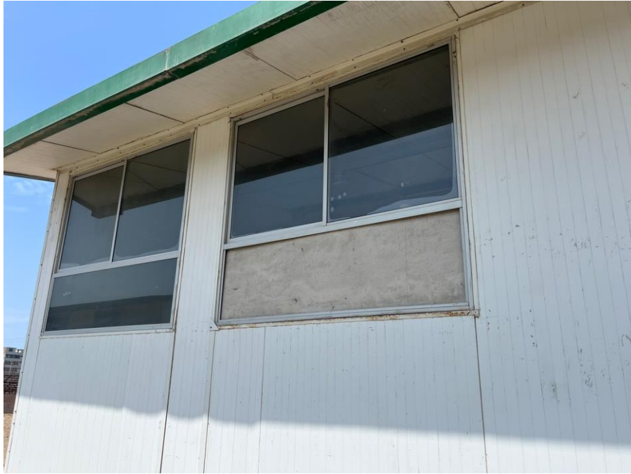
Imagen N°13: Módulos prefabricados: Se observan ausencia de vidrio laminado en algunos vanos, requieren su instalación.
