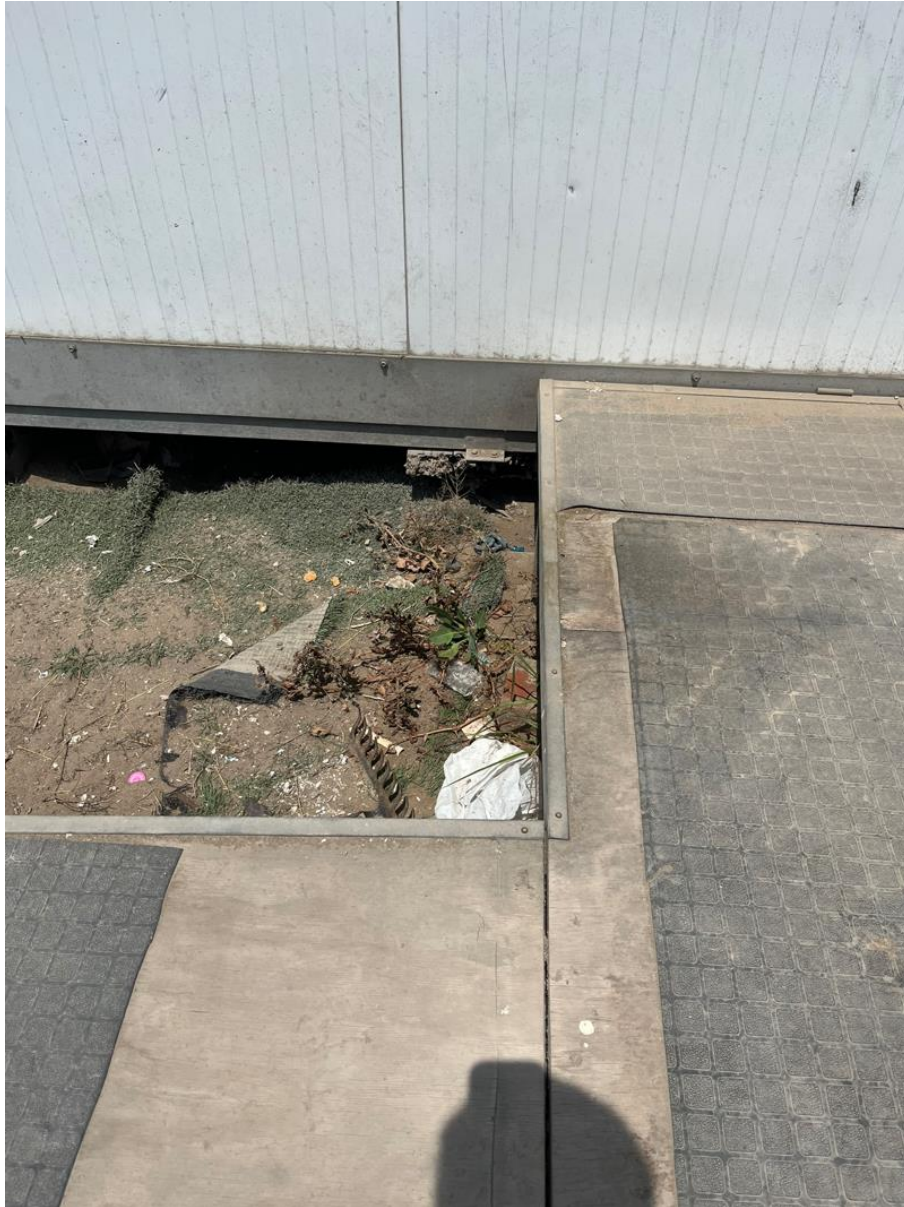
Imagen N°10: Módulos prefabricados: Se observan los paneles fenólicos que conforman el piso, en muy mal estado, requieren su reemplazo y reposición de pisobus.
