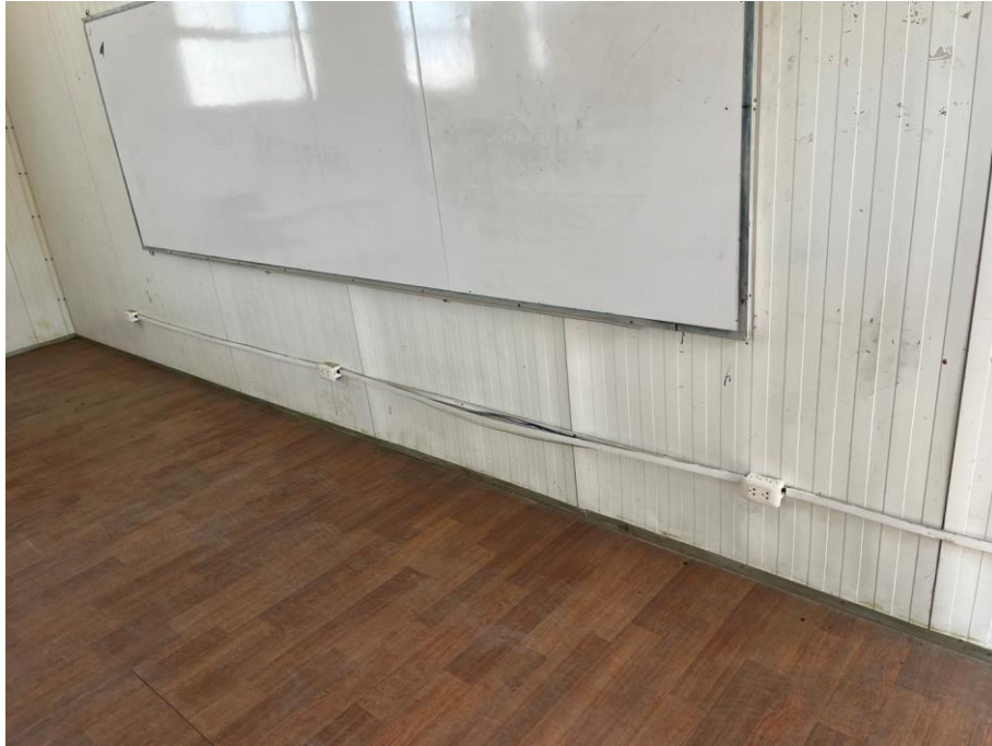
Imagen N°11: Módulos prefabricados: Se observan las canalizaciones eléctricas y tomacorrientes en muy mal estado, requieren su cambio.
