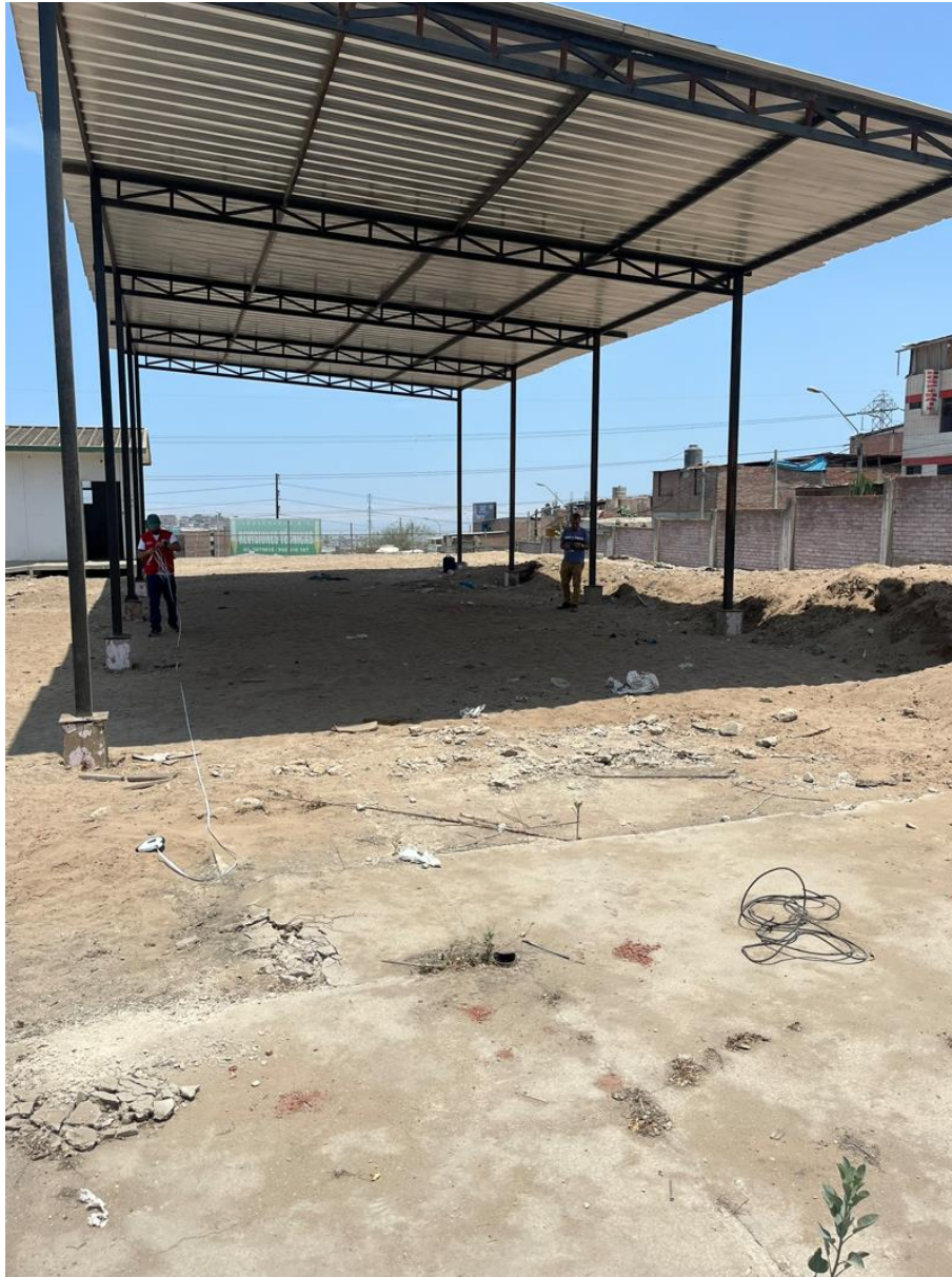
Imagen N°16: Vista panorámica interior de las estructuras con cimentación precaria, sin diseño ni dirección técnica.
