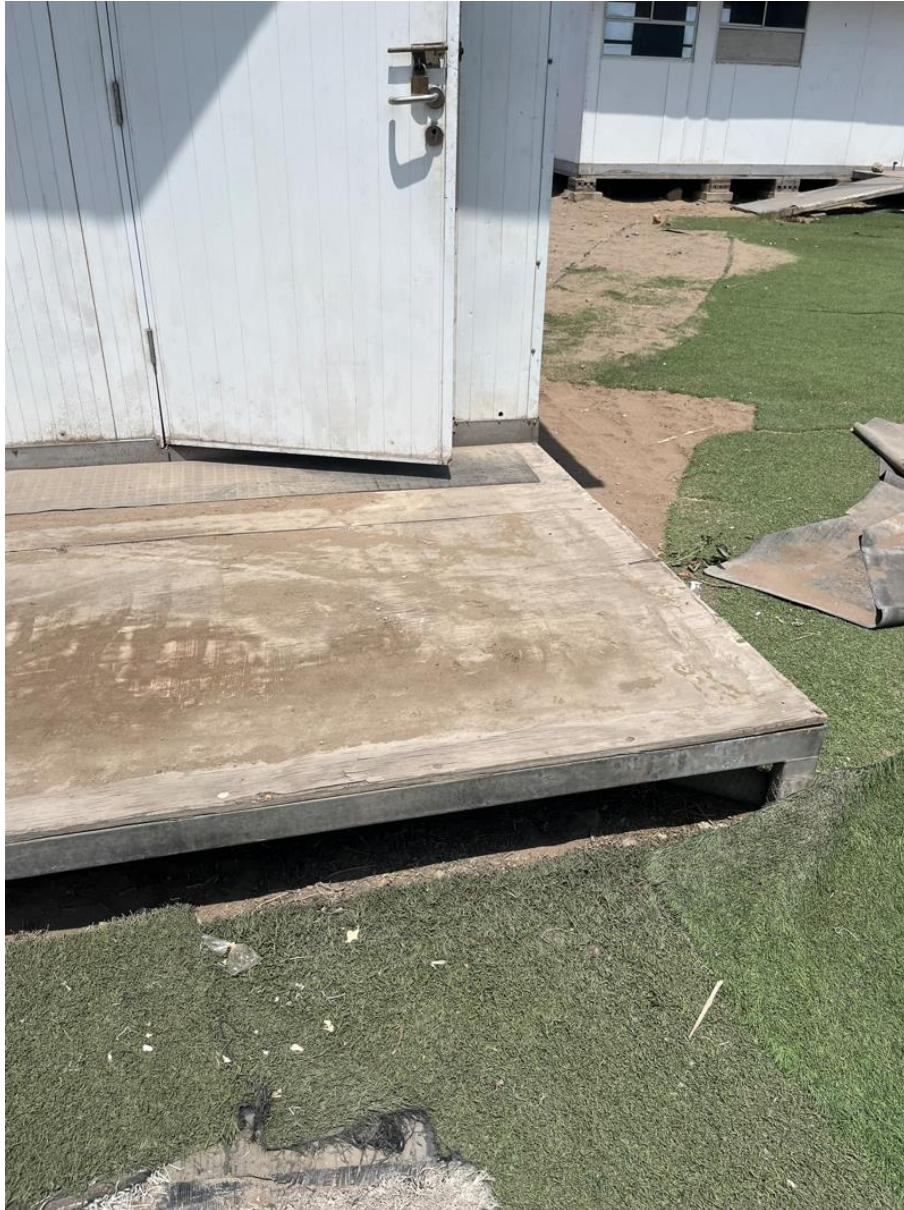
Imagen N°09: Módulos prefabricados: Se observan los paneles fenólicos que conforman el piso, en muy mal estado, requieren su reemplazo y reposición de pisobus.
