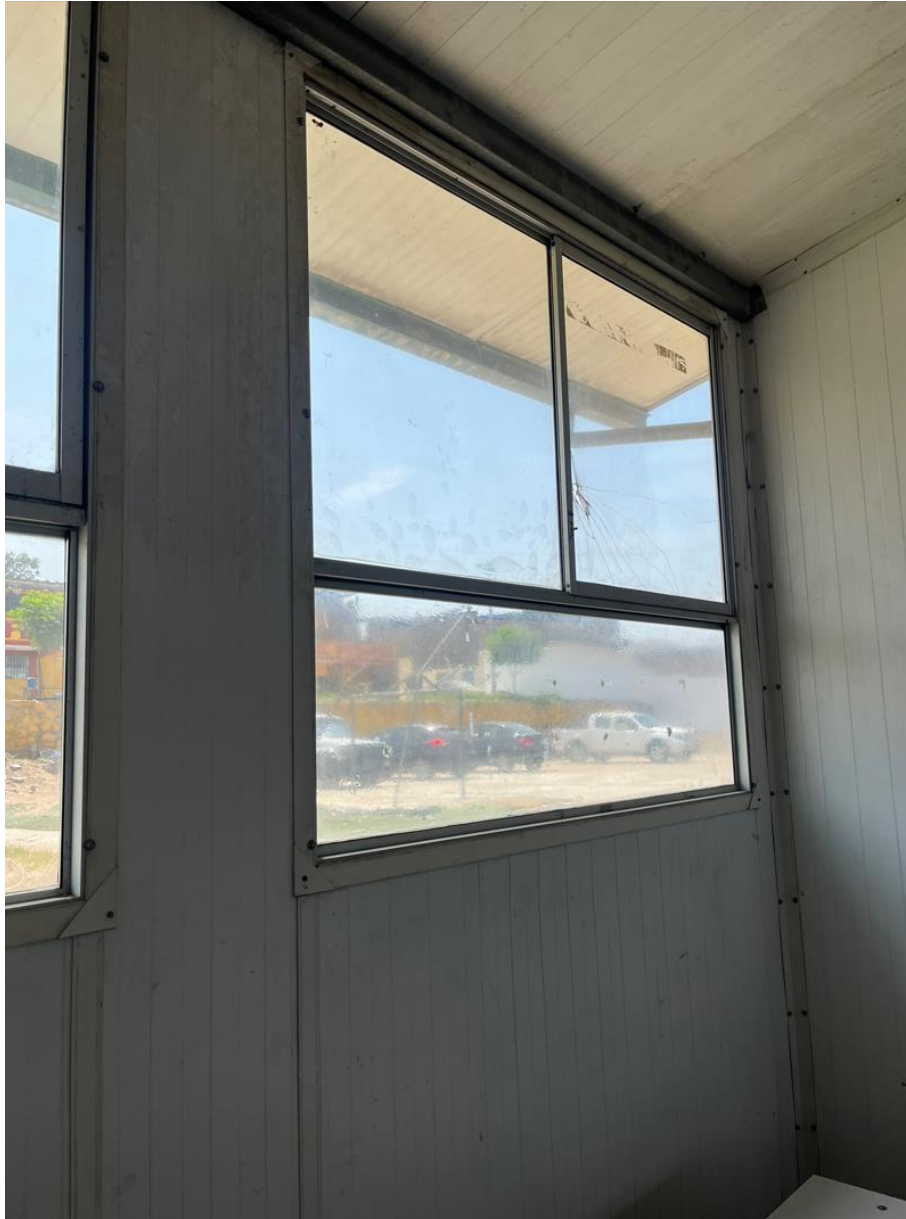
Imagen N°12: Módulos prefabricados: Se observan algunos vidrios rotos que requieren su reemplazo.
