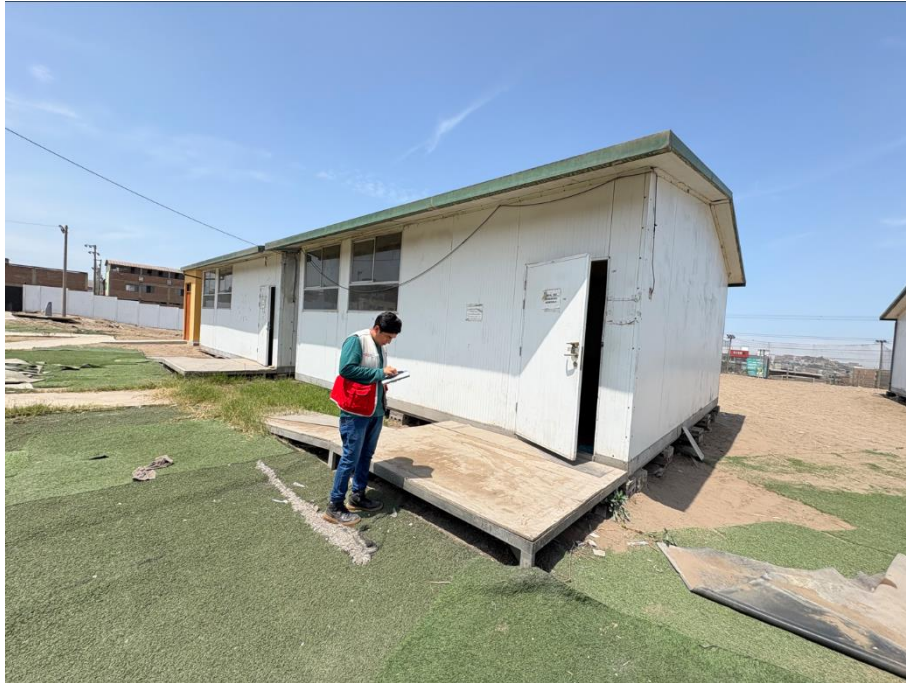
Imagen N°08: Módulos prefabricados: Se observan los paneles fenólicos que conforman el piso, en muy mal estado, requieren su reemplazo y reposición de pisobus.
