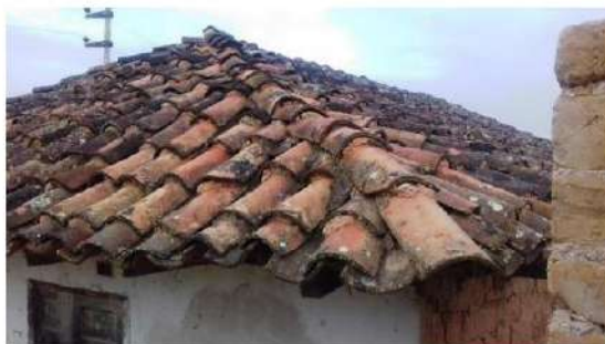
Tejado tradicional, encuentro de un techo a dos aguas, las tejas se colocan en la cumbrera tapando este encuentro para evitar el filtrado del agua y detalle de la cobertura, en algunos casos las tejas están deterioradas por el tiempo, la humedad y sus constantes lluvias.
