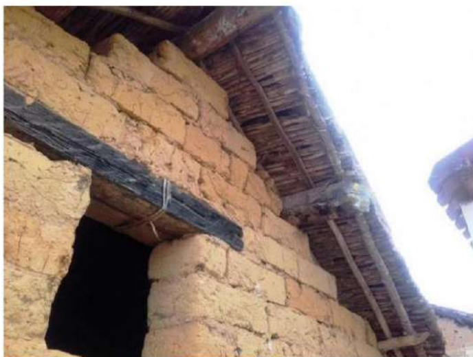
Composición de hiladas en los muros, y la inclusión de dintel de madera para los vanos
