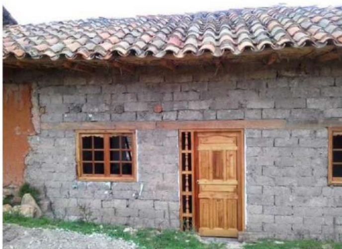
Muro de adobe con barro gris claro y carpintería de madera en puertas y ventanas.
