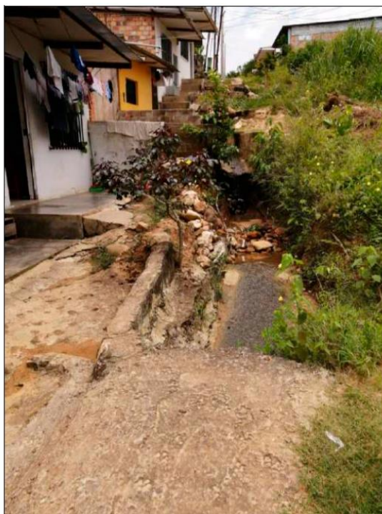
Foto 01: Nótese un sector con cunetas existente, pésimas condiciones.
