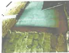
Fotografía 02. Se observa la falta de tarrajeo y acabado en la zona del muro.
