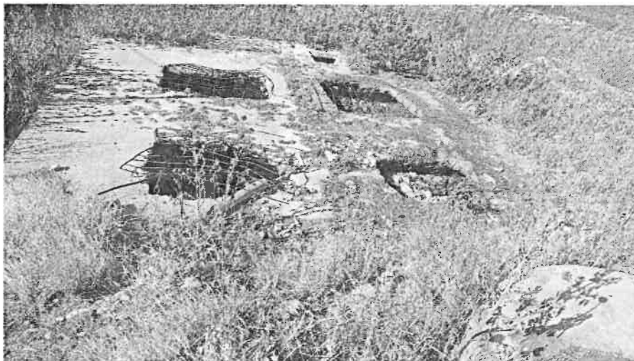
Imagen referencial para el cambio de tapas de inspección en el Tanque Séptico
