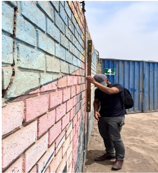
Imagen N°18: Cerco Perimétrico Vista Exterior: Cerco en zona de Avenida Áncash, en muy mal estado de conservación, muro grieta y además con inclinación, a la altura de Puerta 4.
