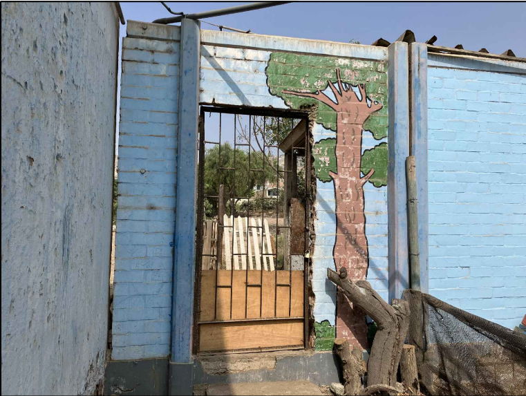
RI.3. CERCO PRIMÉTRICO EN RIESGO INMINENTE MURO CON INCLINACIÓN
