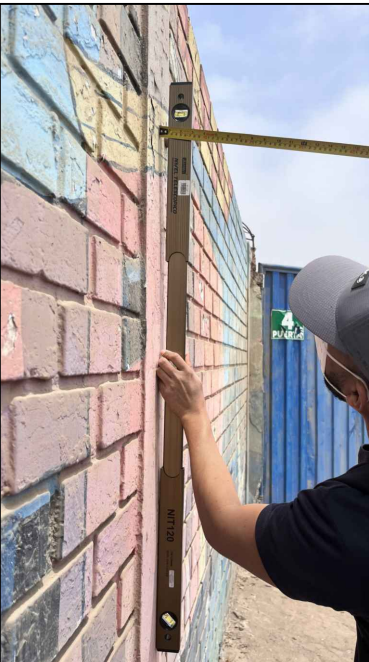
RI.2. CERCO PRIMÉTRICO EN RIESGO INMINENTE MURO CON INCLINACIÓN
