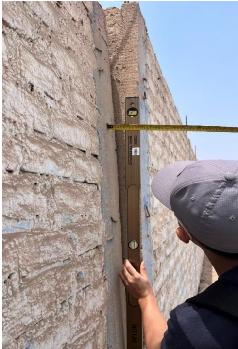
Imagen N°12: Cerco Perimétrico Vista Exterior: Cerco en zona de Avenida 6 de febrero, en muy mal estado de conservación, con inclinación y ausencia de viga de confinamiento.
