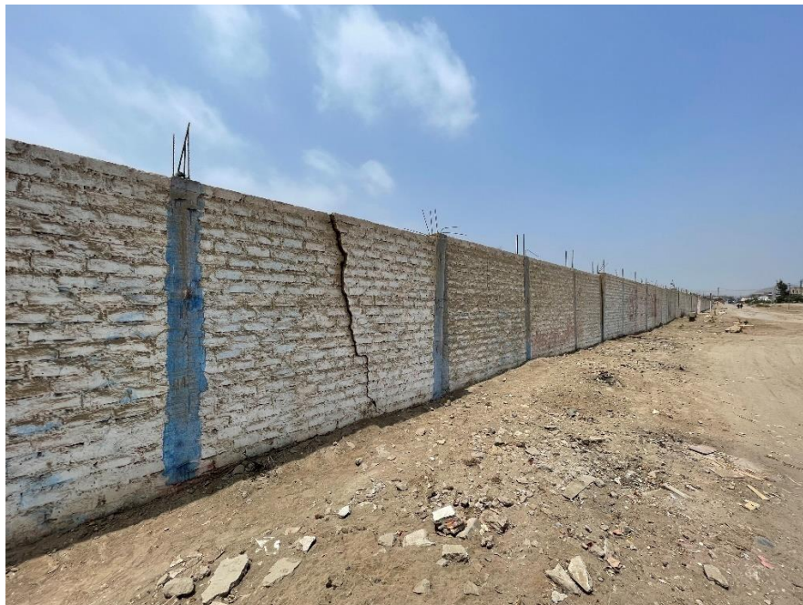
Imagen N°13: Cerco Perimétrico Vista Exterior: Cerco en zona de Avenida 6 de febrero, con gran fisura, inclinación de muro y ausencia de vigas de confinamiento, en muy mal estado de conservación.
