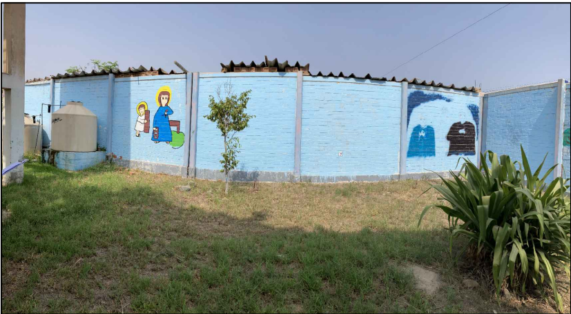
RI.3. CERCO PRIMÉTRICO EN RIESGO INMINENTE MURO CON INCLINACIÓN
