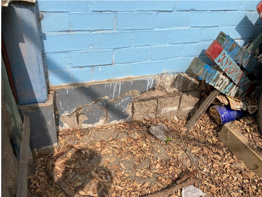
Imagen N°23: Cerco Perimétrico Interior: Cerco interno colindante con vivero, en mal estado de conservación, acero de refuerzo expuesto en sobrecimiento.
