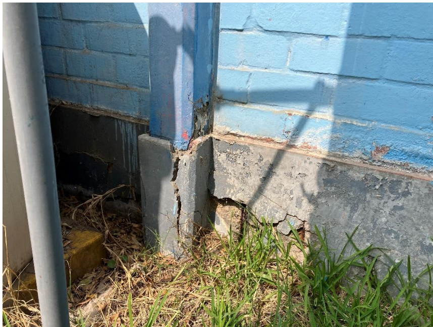
Imagen N°24: Cerco Perimétrico Interior: Cerco interno colindante con vivero, en mal estado de conservación, acero de refuerzo expuesto en base de columna.
