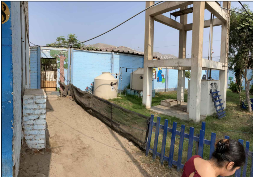
RI.3. CERCO PRIMÉTRICO EN RIESGO INMINENTE MURO CON INCLINACIÓN
