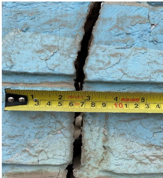
Imagen N°17: Cerco Perimétrico Vista Exterior: Cerco en zona de Avenida Áncash, en muy mal estado de conservación, muro con fisura a la altura de Puerta 4.
