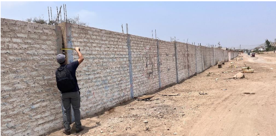
Imagen N°11: Cerco Perimétrico Vista Exterior: Cerco en zona de Avenida 6 de febrero, en muy mal estado de conservación, con inclinación y ausencia de viga de confinamiento.
