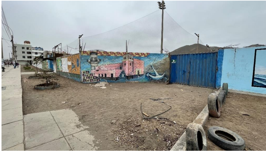
Imagen N°16: Cerco Perimétrico Vista Exterior: Cerco en zona de Avenida Áncash, en muy mal estado de conservación, muro con fisura a la altura de Puerta 4.
