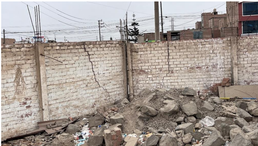
Imagen N°15: Cerco Perimétrico Vista Interior: Acercamiento de Imagen N°20, Cerco en zona de Avenida Áncash, en muy mal estado de conservación, muros con fisuras, y con ausencia de vigas de confinamiento.
