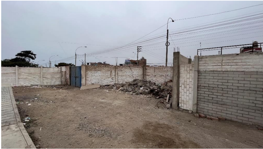
Imagen N°14: Cerco Perimétrico Vista Interior: Cerco en zona de Avenida Áncash, en muy mal estado de conservación, muro con fisuras, y con ausencia de vigas de confinamiento.
