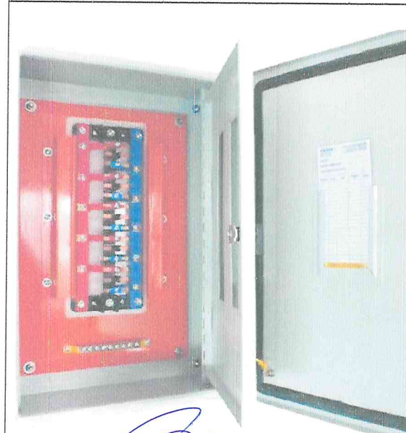
43. TABLERO METALICO DE BARRA DE 24 POLOS
