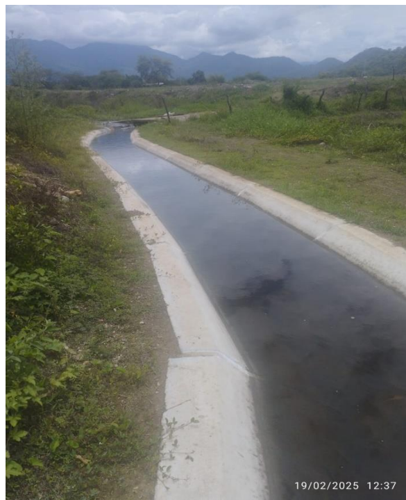
Fotografía N° 02: Canal trapezoidal – cruce de caudal de quebrada, canal si protección.
