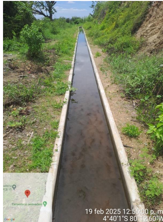
Fotografía N° 01: Canal rectangular – Talud pronunciado lado lateral
