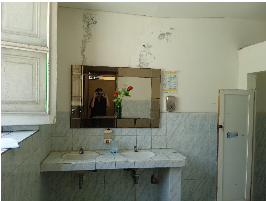
FOTO 05: Se observa presencia de humedad en muros y desprendimiento de pintura
