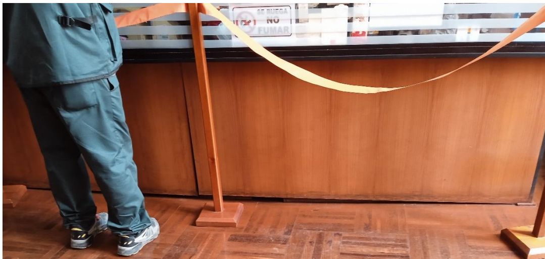
FOTO 17: desnivel del mueble de oficina por hundimiento de piso
