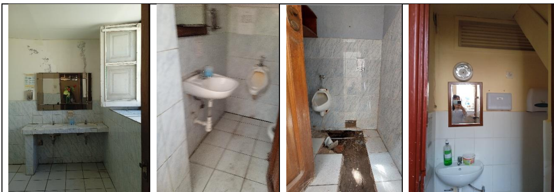
Foto 08a11: Los SSHH pertenecientes o ubicados en la Zona 03(17.34m 2 ) y 08(5.84m 2 ) son los que se reflejan en las imágenes, donde se evidencio que bajo su rasante se encontró material de relleno húmedo, como una de las causantes del hundimiento general del sector, a corregir.
