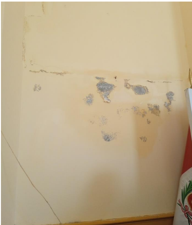
FOTO 13: desprendimiento y manchas de la pintura por humedad.
