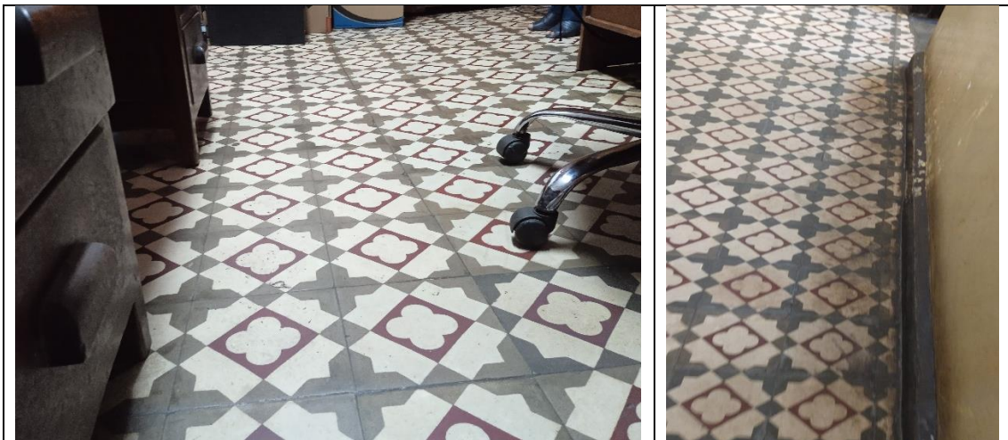
Foto 06y07: La zona 02(61.81m 2 ) esta conformada por la oficina de economía (jefatura y personal), donde el piso esta bastante desnivelado y/o hundido en su zona central, reflejándose un aumento periódico en la luz entre los elementos divisorios y el piso.
