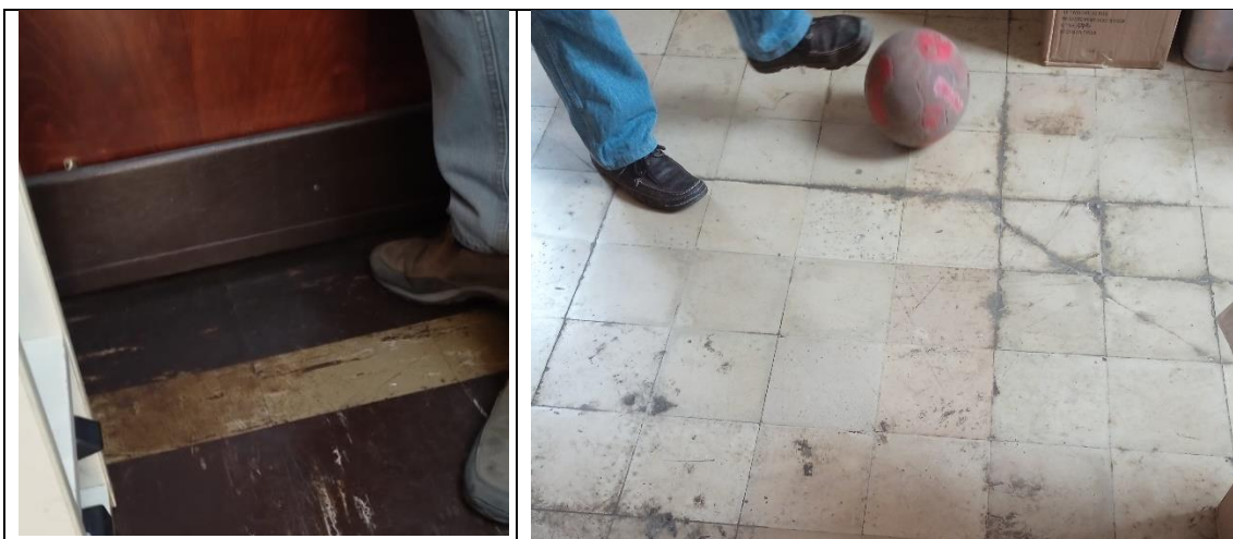
Foto 12y13: En la zona 04(32.10m 2 ) y 05(25.79m 2 ) se encuentra la dirección de administración y la oficina de comunicaciones en ambos ambientes se observa un hundimiento / deformación / grietas del piso, bastante pronunciado, por lo que se encuentra priorizado dentro del alcance del servicio.
