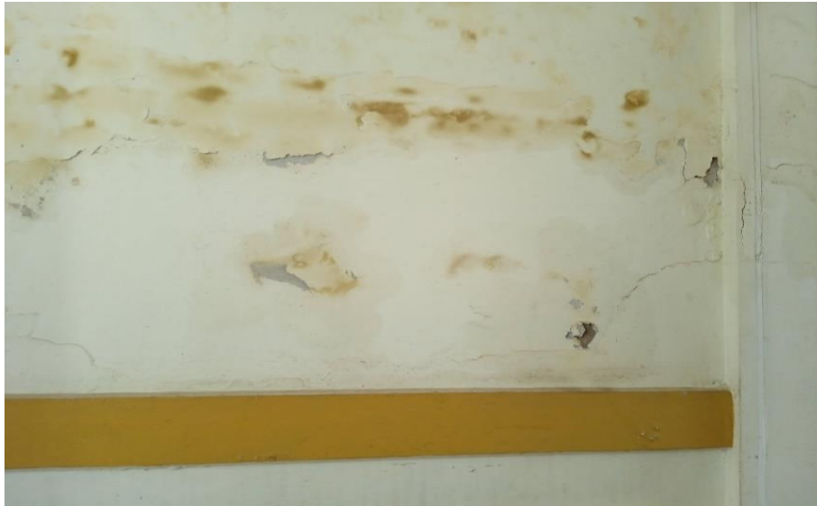
FOTO 01 : presencia de moho y desprendimiento de pintura
