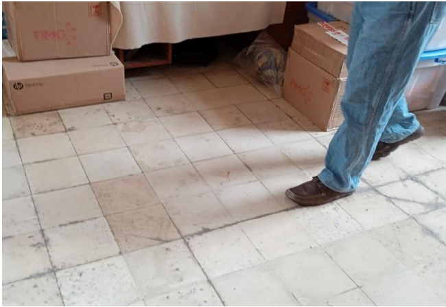
FOTO 11: hundimiento en piso de comunicación.
