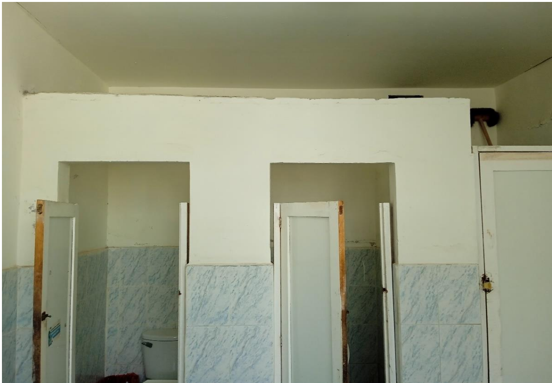
FOTO 07: habilitación en tabiquería muro de soga simple media altura
