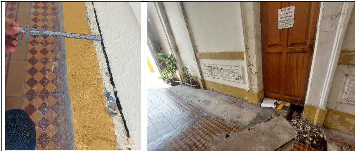
Foto 04y05: La deformación o hundimiento del área, no solo afecta el desplazamiento peatonal del sector; sino además genera el desplazamiento de elemento colindantes (ejemplo la primera imagen) y la red de desagüe de los SSHH anexos, provocando derrame que va (con el pasar del tiempo) en detrimento incluso de la estabilidad del lugar.
