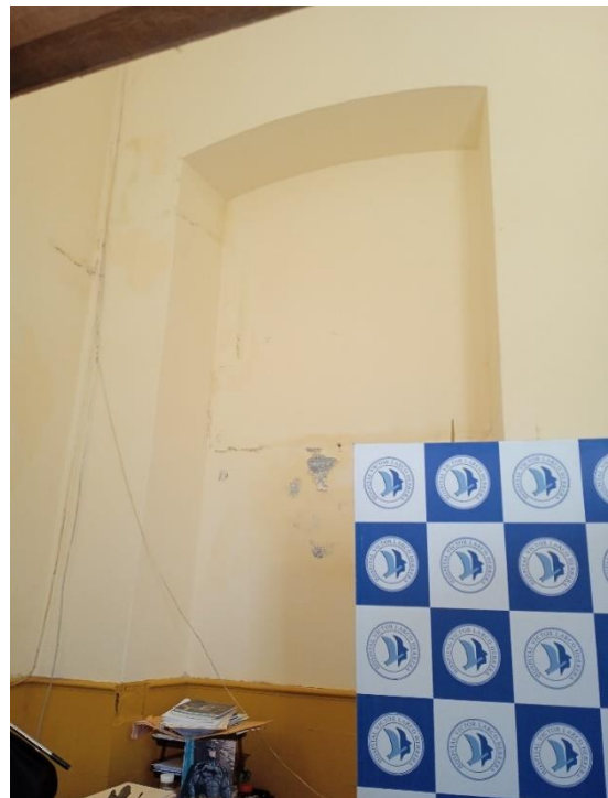
FOTO 13: desprendimiento y manchas de la pintura por humedad.
