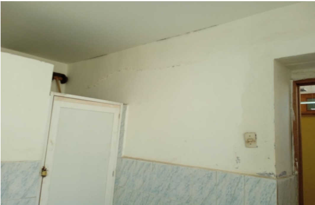
FOTO 08: Presencia manchas de Humedad en muros originales
