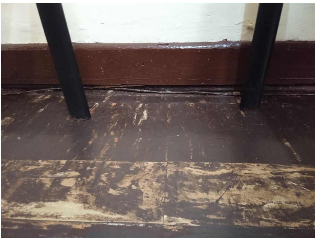
FOTO 15: apertura de la unión entre piso y muro por hundimiento
