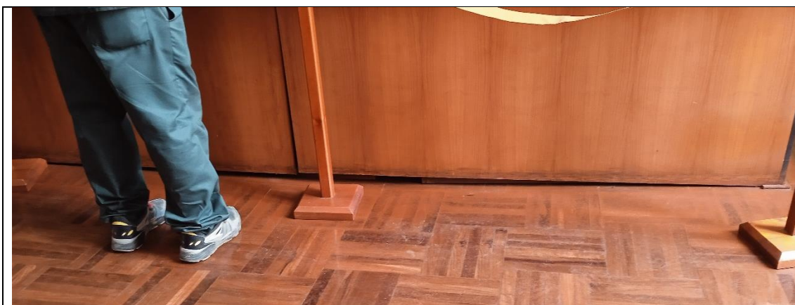
Foto 14: En la zona 06 (25.41m 2 ) y 07 (34.18m 2 ) se encuentra la Dirección General, siendo los ambientes de la secretaría y directora general los ambientes afectados por la deformación del piso, tal como se muestra en la imagen (luz entre el elemento divisorio y el piso).
