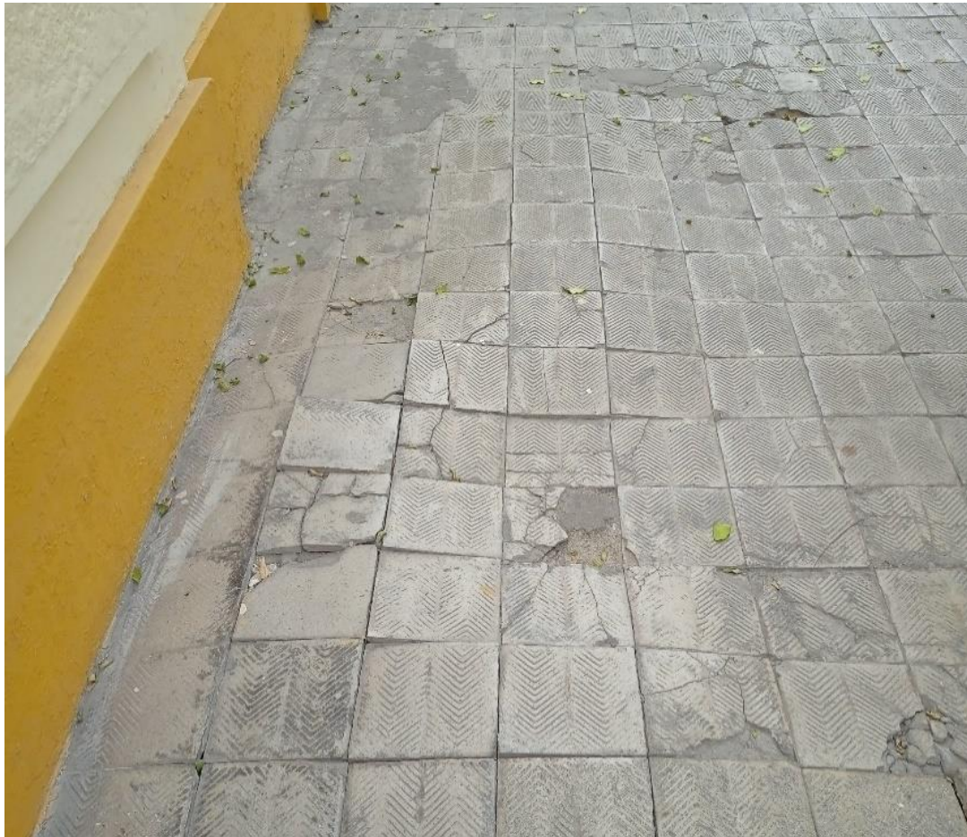
FOTO 20: erosión de superficie de corredor exterior
