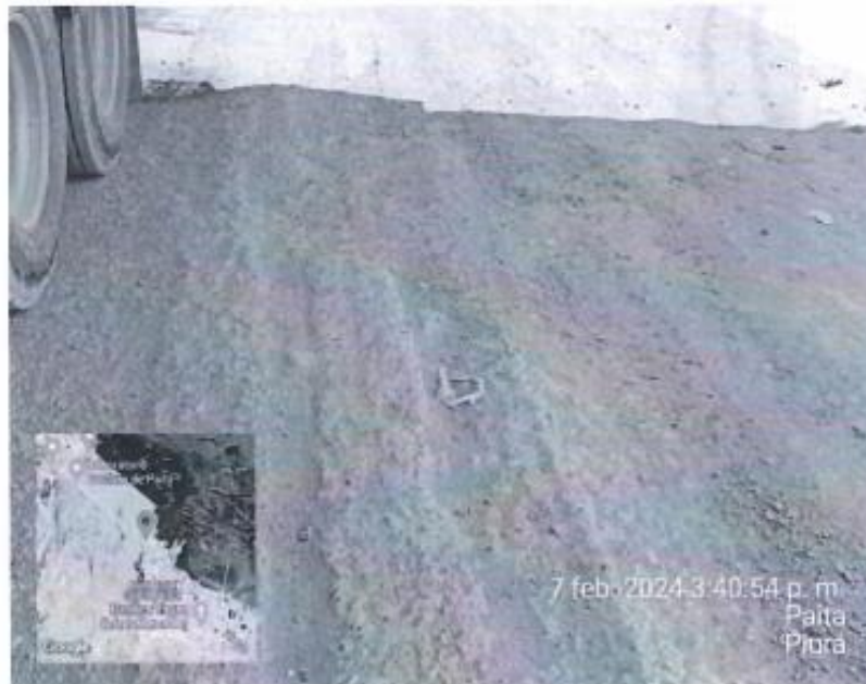
Figura 014. Pavimento Flexible con ahuellamientos – Tramo 1-369. Fuente: Equipo Consultor
