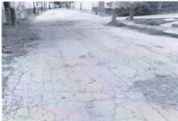
Figura 018. Pavimento Rígido con fisuras – Tramo 1-372. Fuente: Equipo Consultor
