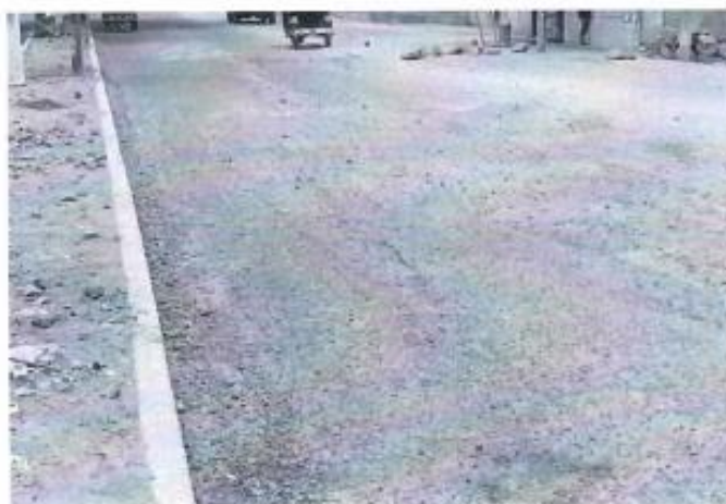
Figura 012. Desgaste en Pavimento Flexible K1+450 – Tramo 1-365. Fuente: Equipo Consultor
