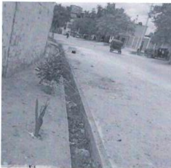
Figura 010. Cuneta rectangular de concreto obstruida – Tramo 1-364. Fuente: Equipo Consultor
