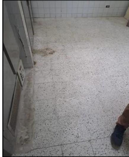
IMAGEN 12: PISO DE TERRAZO DETERIORADO POR EL TIEMPO (PRESENCIA DE MANCHAS)
