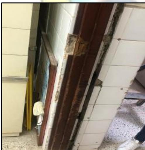
IMAGEN 03: MARCO DE LA PUERTA DETERIORADO, JUNTA SISMICA SIN TAPA JUNTA, DESPRENDIMIENTO DE ZOCALO, AL INGRESO DE SALA DE NECROPSIA
