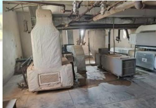
IMAGEN 15 Y 16: EQUIPOS DE CLIMATIZACION SIN MANTENIMIENTO, TECHO CON PROBLEMAS DE HUMEDAD
