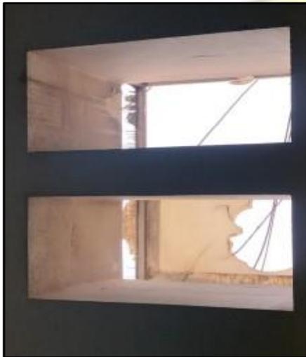
IMAGEN 13: CÚPULA EXISTENTE EN SALA DE MORTUORIO SIN MANTENIMIENTO (POLICARBONATO ROTO Y ESTRUCTURA METÁLICA SIN MALLA DE SEGURIDAD).
