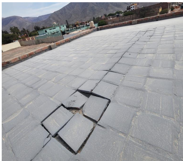
F2: Retiro y reposición de ladrillo pastelero
