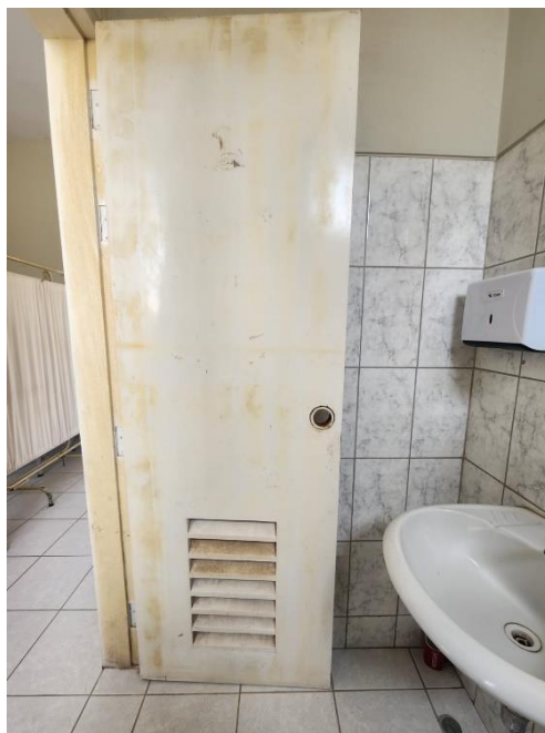
F7: Mantenimiento y pintado de puerta de madera y reposición de cerradura tipo perilla
