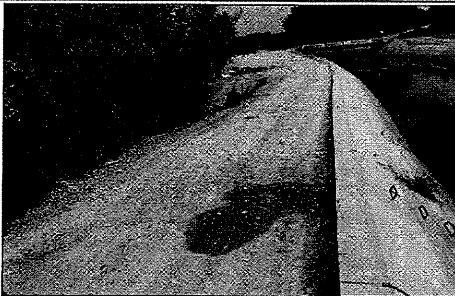
Foto N° 01: Camino de Servicio con presencia de huecos y desnivel con respecto al borde del canal.
