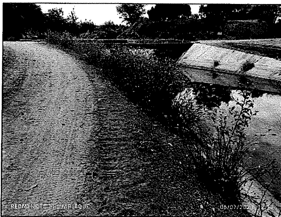
Foto N° 02: Se Observa la vegetación en la berna y/o borde del canal margen Izquierda
