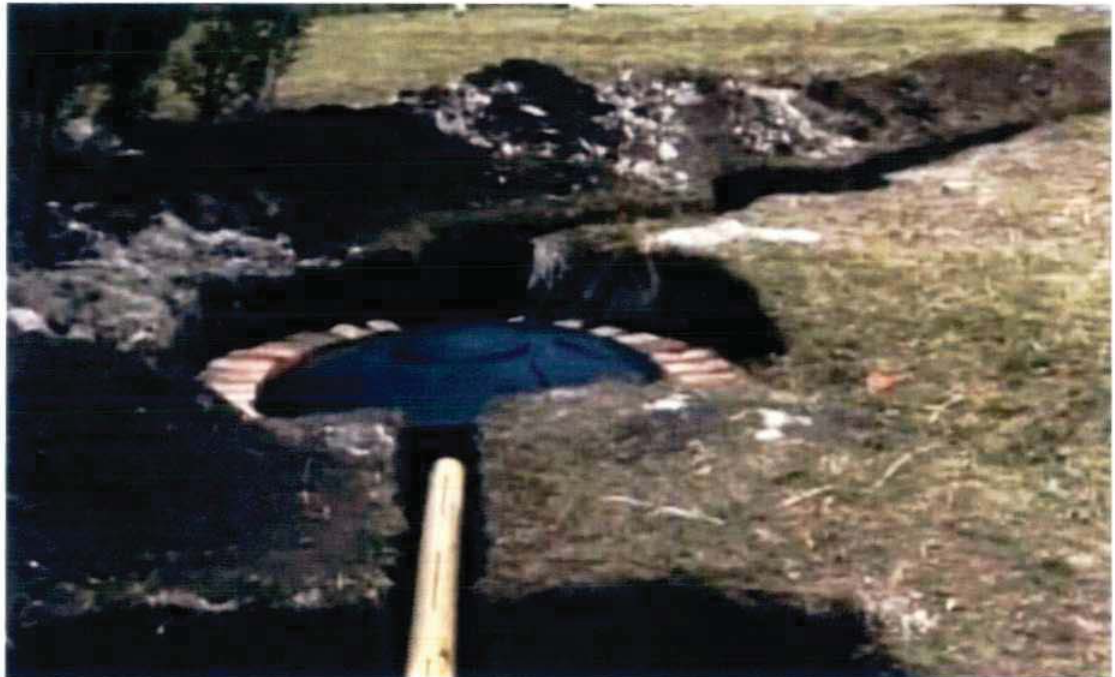
Vista de un tanque biodigestor autolimpiante
