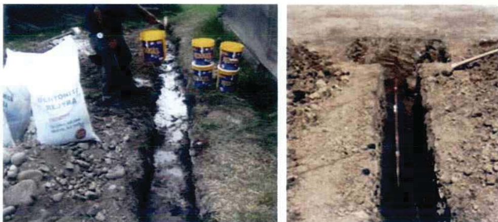
Vistas 3 del proceso de instalación de poza atierra horizontal
