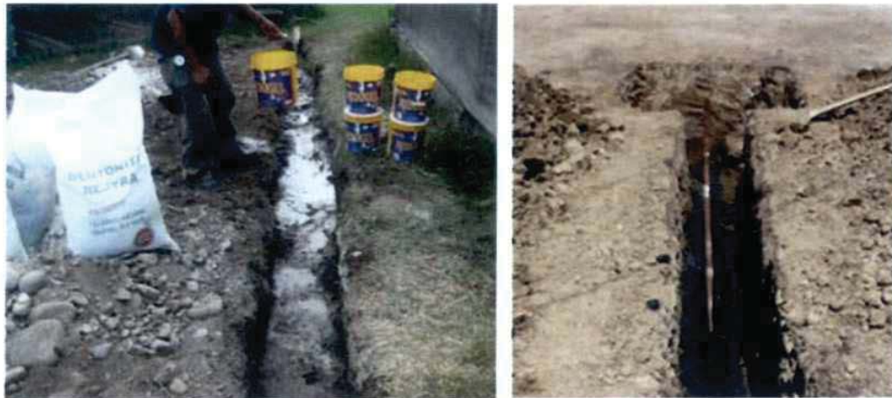
Vistas 2 del proceso de instalación de poza atierra horizontal (Imagen referencial)
