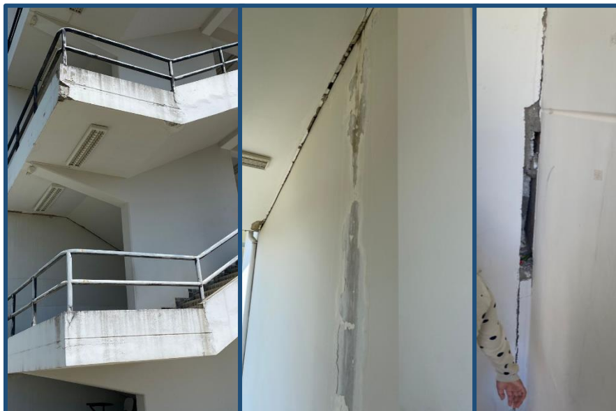
Ilustración 2: Deterioro de pintura y juntas sísmicas
