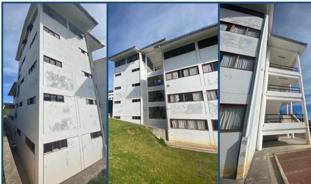
Ilustración 1: Deterioro de la pintura exterior
