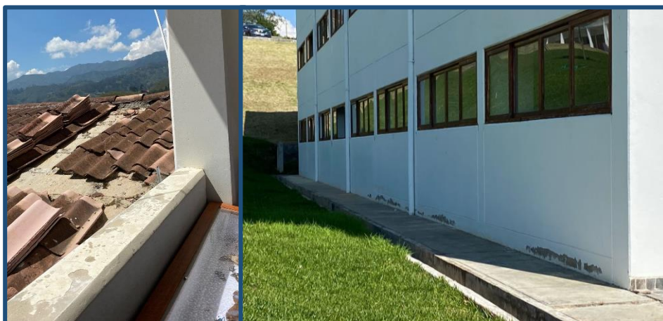
Ilustración 3: Deterioro de pintura en muro y ventanas. Mal estado de cobertura
