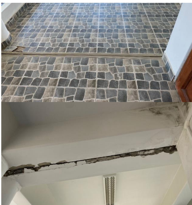
Imagen de juntas sísmicas existentes*
