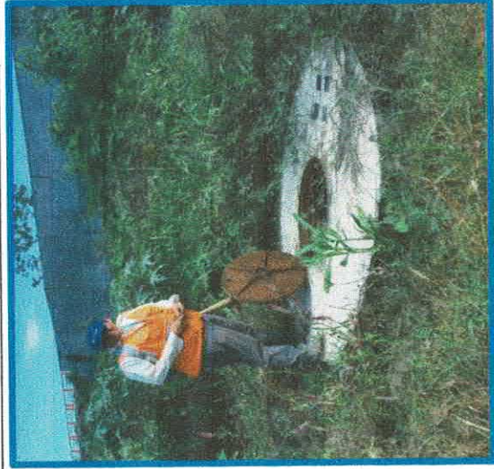
FOTO 09: SE OBSERVA EN EL JR. LOS ANDES CDRA.02 EL ESTADO DE LA TAPA Y CUERPO DE BUZON EXISTENTE.
