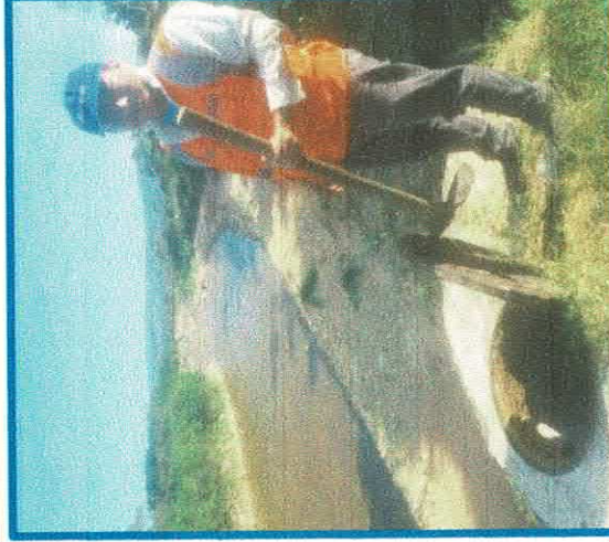
FOTO 06: SE OBSERVA EN LA IMAGEN EL BUZON A PUNTO DE PERDERSE POR LA EROSION DE UNA PARTE DEL SUELO EN EL JR. MALECON CUMBaza.
