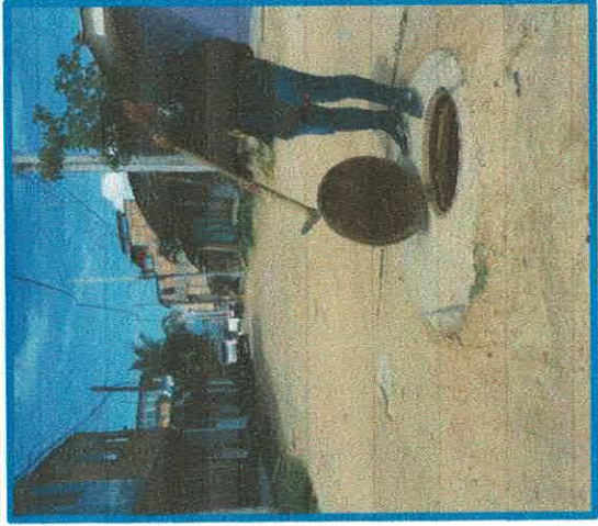
FOTO 09: SE OBSERVA EN LA IMAGEN LA VERIFICACION DE LAS CONDICIONES DE LA TAPA Y EL CUERPO DEL BUZON POR PARTE DEL PERSONAL CAPACITADO, EN LA CUADRA 03 DEL JIRON OSCAR R. BENAVIDES.
