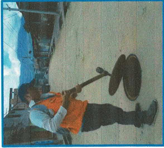
FOTO 03: SE OBSERVA EN LA IMAGEN LA VERIFICACION DE LAS CONDICIONES DE LA TAPA Y EL CUERPO DEL BUZON POR PARTE DEL PERSONAL CAPACITADO, EN LA CUADRA 03 DEL JIRON LOS ANDES.
