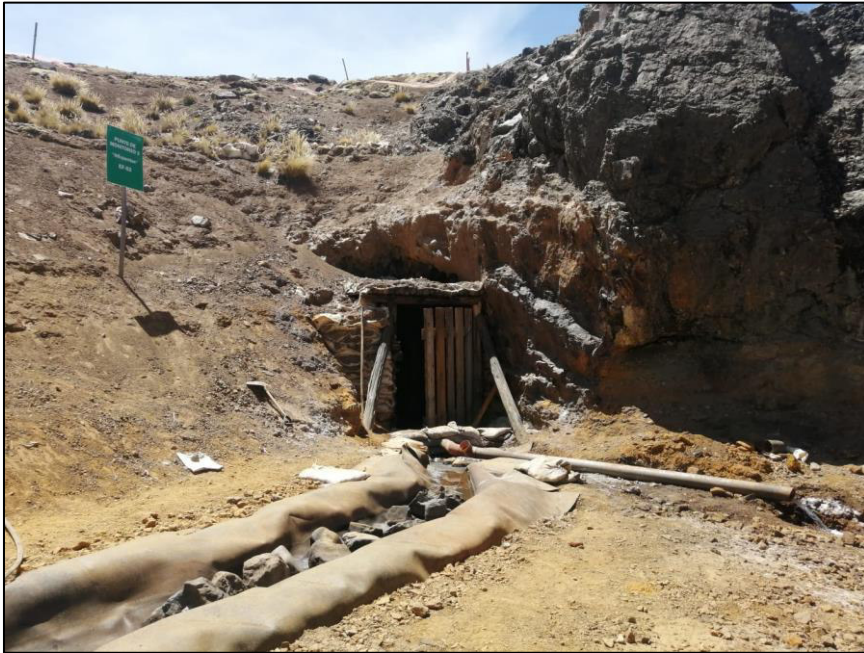
Figura 3: Bocamina ID 8746 (Sección actual 1.0 m x 1.2 m aproximadamente)
