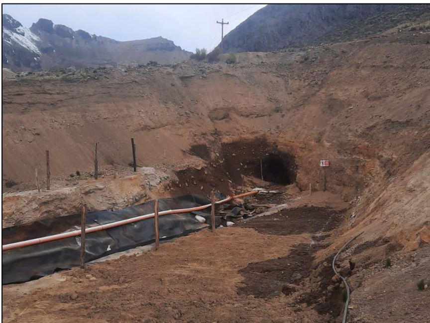
Figura 3: Bocamina ID 8746 (Sección actual 1.0 m x 1.2 m aproximadamente)
