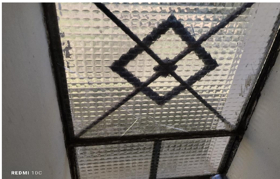
FOTO N°08: VIDRIOS DETERIORADOS
