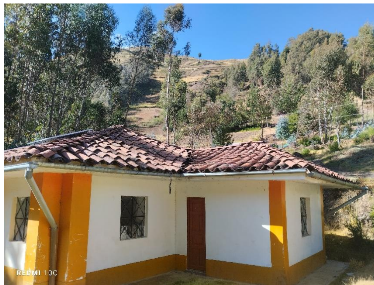
FOTO N°02: CANALETAS PLUVIALES
