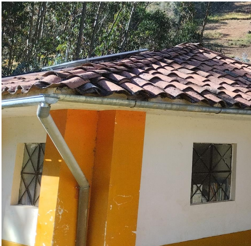
FOTO N°06: MONTANTES DETERIORADOS
