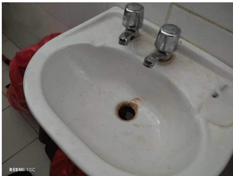
FOTO N°07; ACCESORIOS DE LAVADEROS MALOGRADOS
