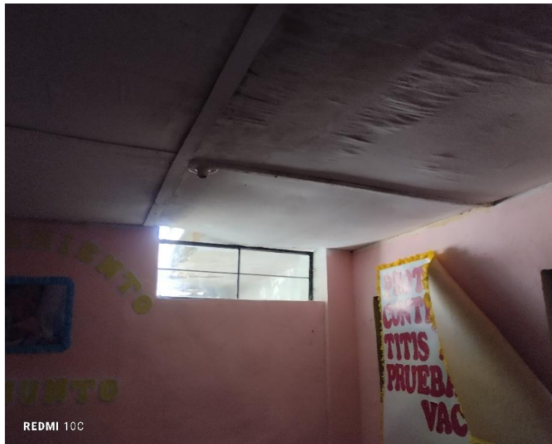
FOTO N°06: MONTANTES DETERIORADOS
