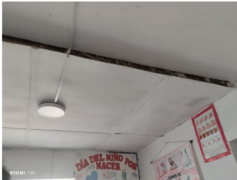
FOTO N°06: MONTANTES DETERIORADOS
