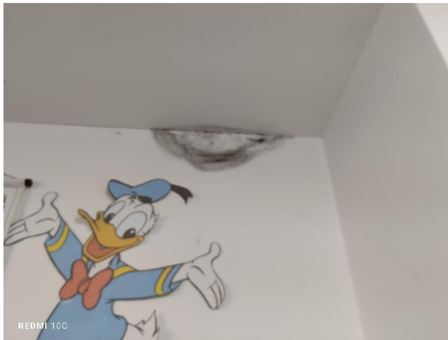
FOTO N°10 : PINTURA DE MUROS DETERIORADAS
