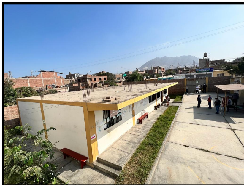
FOTOGRAFÍA N° 2.- SE OBSERVA VOLADIZO SIN CANALETA NI DESFOGUE.
