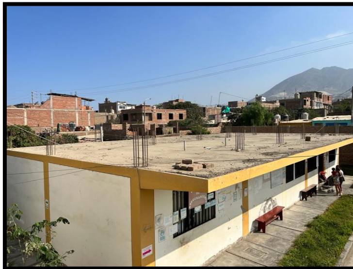
FOTOGRAFÍA N° 1.- TECHO DE LOSA ALIGERADA CON FISURAS Y SIN TUBOS DE DESFOGUE DE ACUMULACIÓN DE AGUA.
