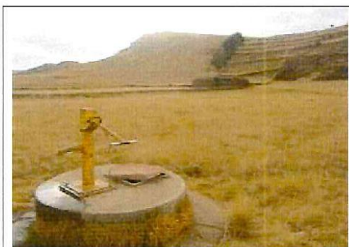
POZO ARTESANAL FUENTE DE ABASTECIMIENTO DE AGUA POTABLE
