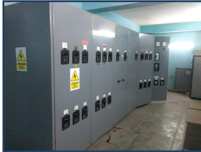
Celdas de llegada y salida y Tableros de transferencia automática
