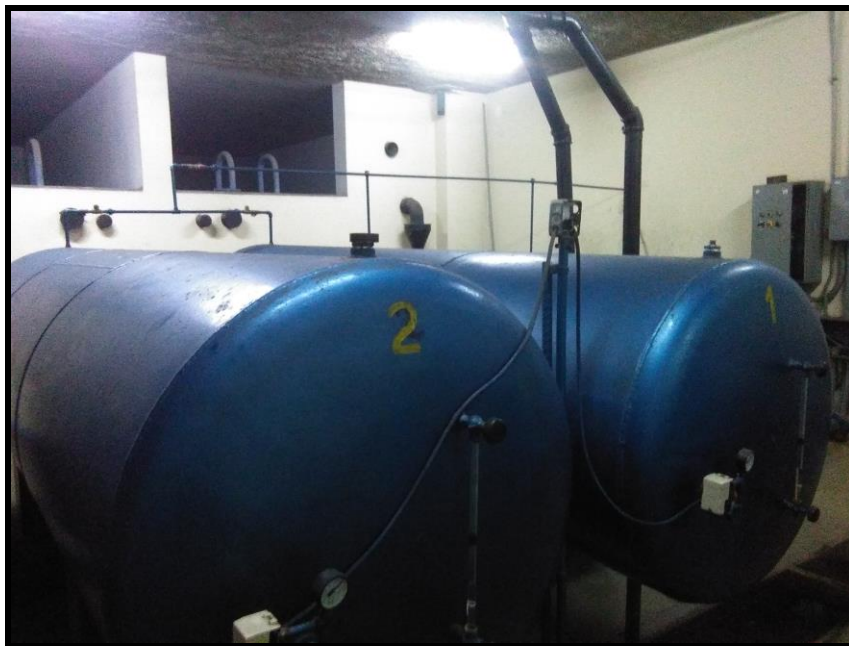
Electrobombas, cisternas compresoras, tanques hidroneumáticos
