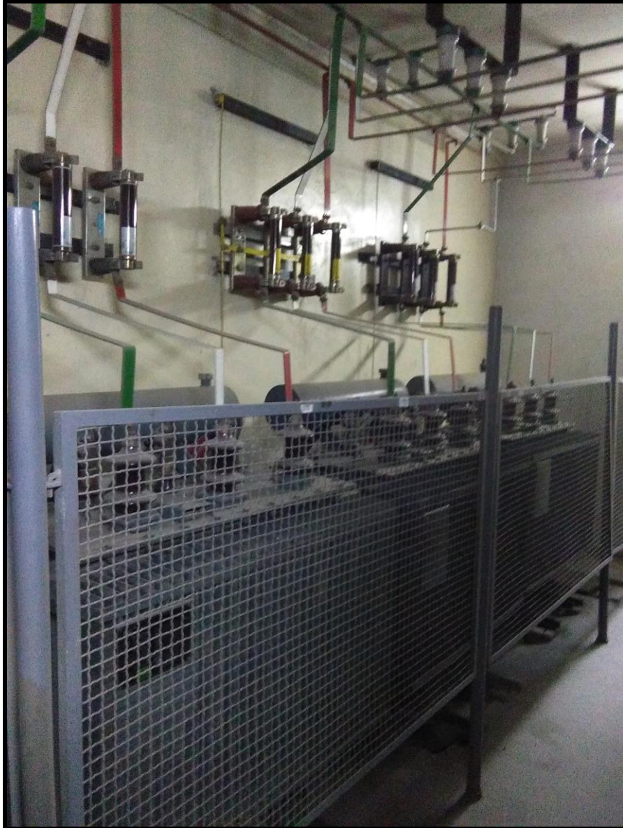
Transformadores sin muros cortafuego
