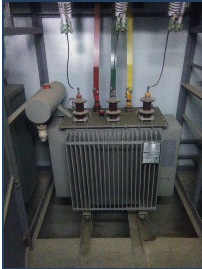
Transformadores sin muros cortafuego
