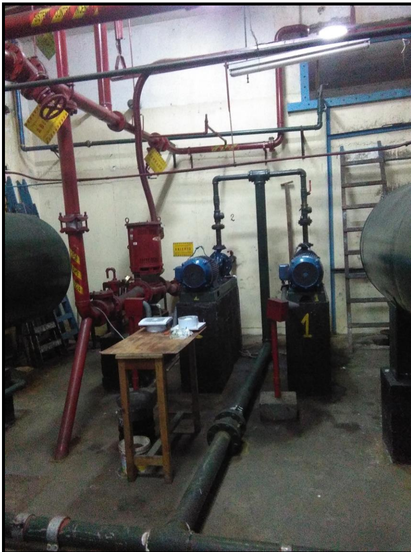
Electrobombas junto a Bomba contra incendio
