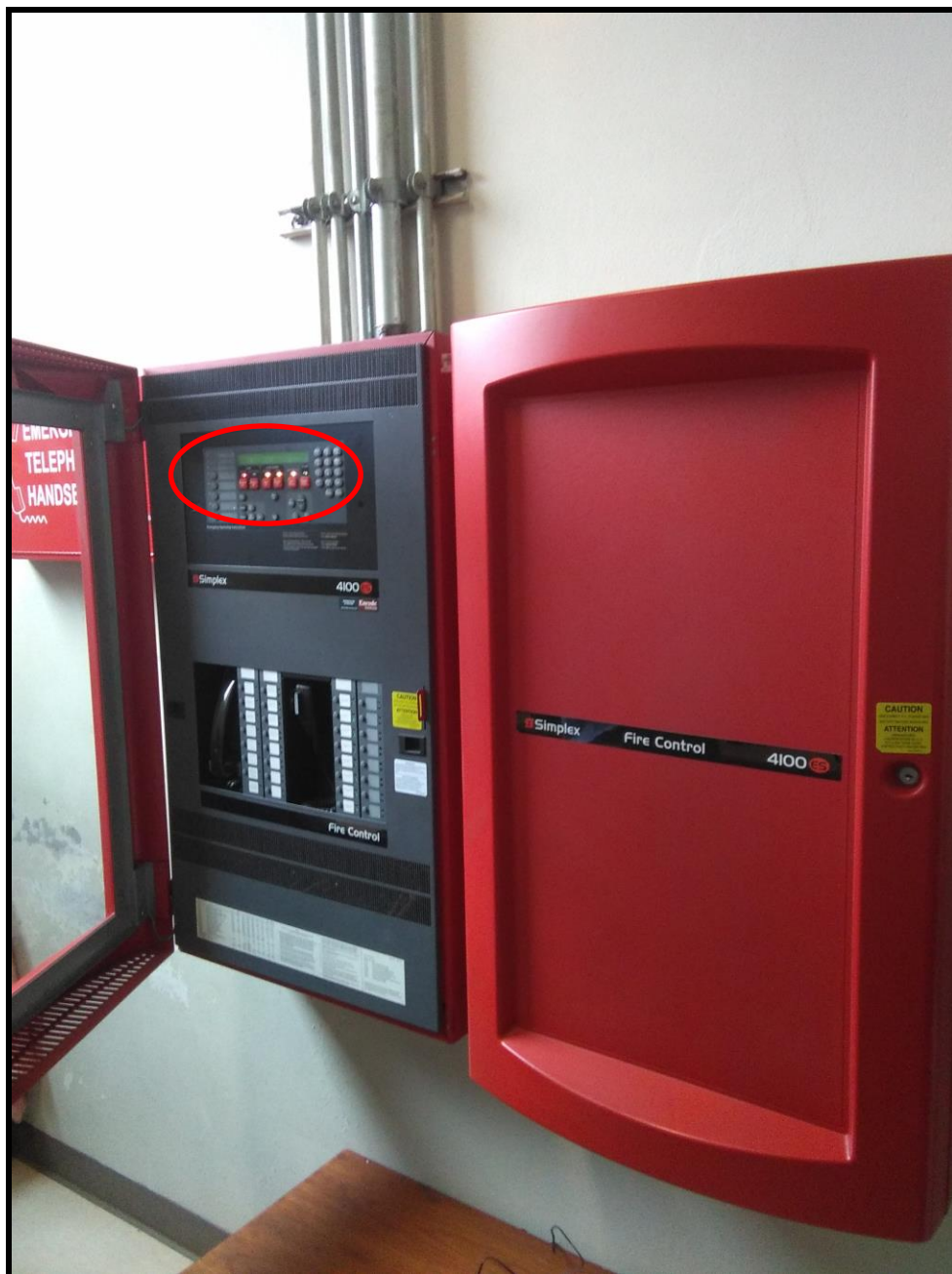
Panel de control con luces de alarmas encendidas
