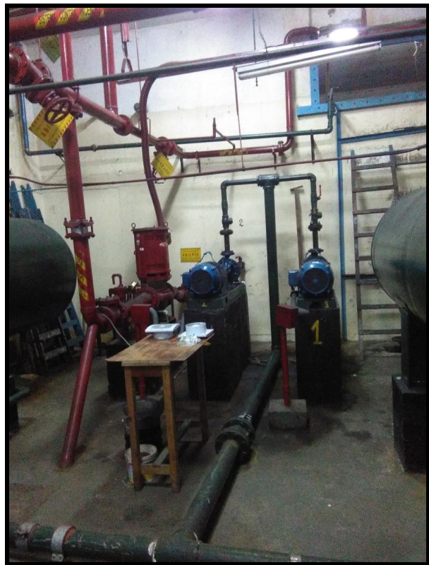
Gabinetes y Bomba contra incendio Edificio Lima
